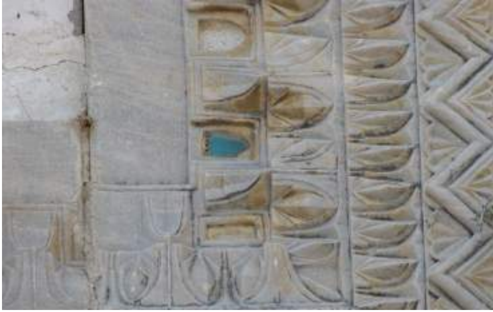
Fotoğraf: 356b Pencerenin mukarnaslı silmesinde firuze çiniler
