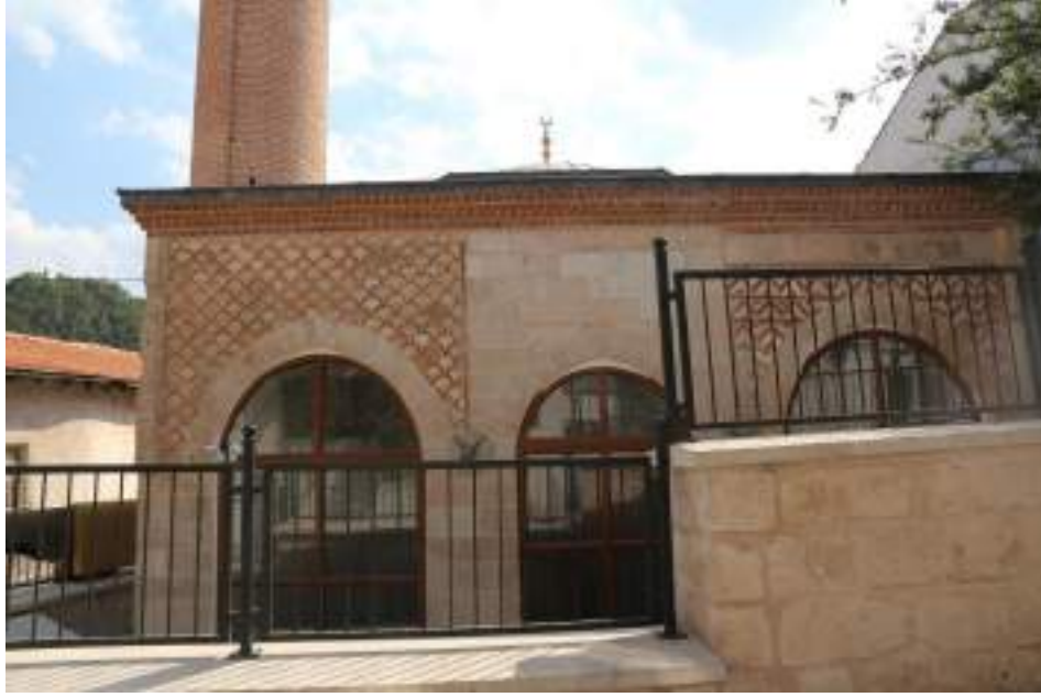
Fotoğraf: 300 Kütahya Kurşunlu Camii, ön cephe
