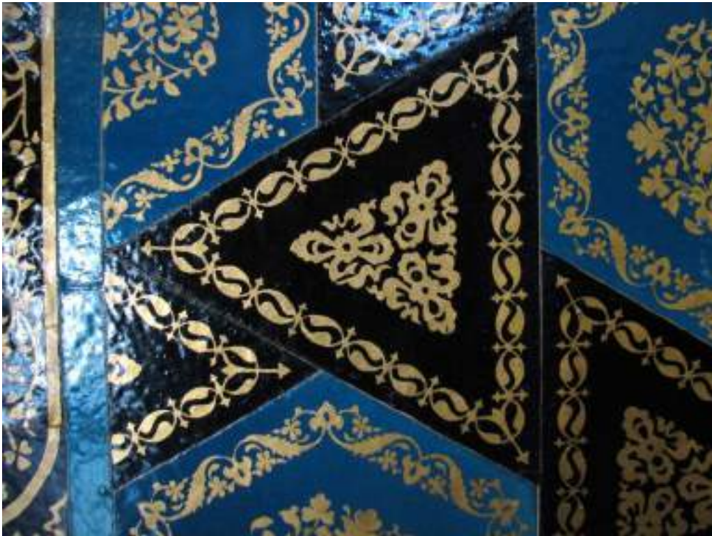
Fotoğraf: 161 Baskı yöntemi ile yapılan, tek renk sır üstü yıldız uygulaması
