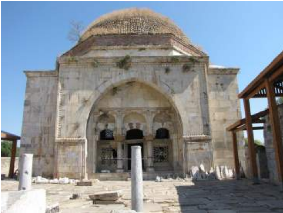
Fotoğraf: 344 Balat İlyas Bey Camii, kuzey cephe (Restorasyon sırasında)
