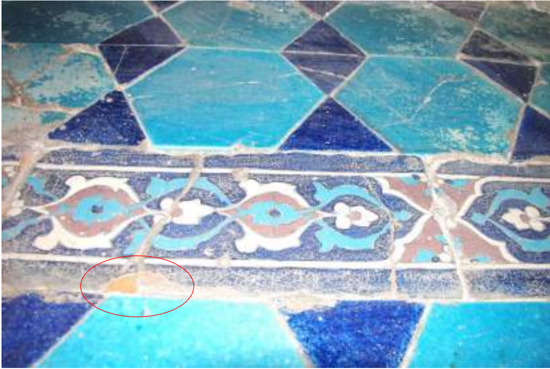
Fotoğraf: 282 Türbe zemininde yer alan renkli sır tekniğinde çiniler
