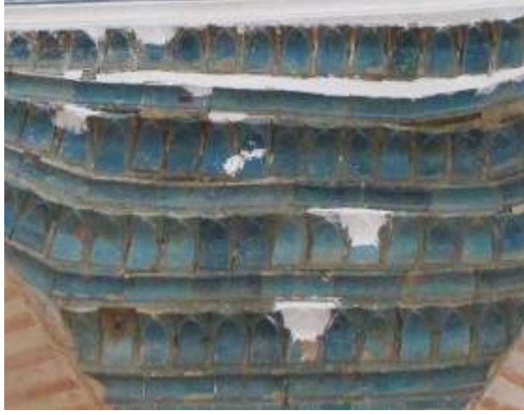
Fotoğraf: 267 Pandantiflerin üst kısmını oluşturan çini mukarnaslar
