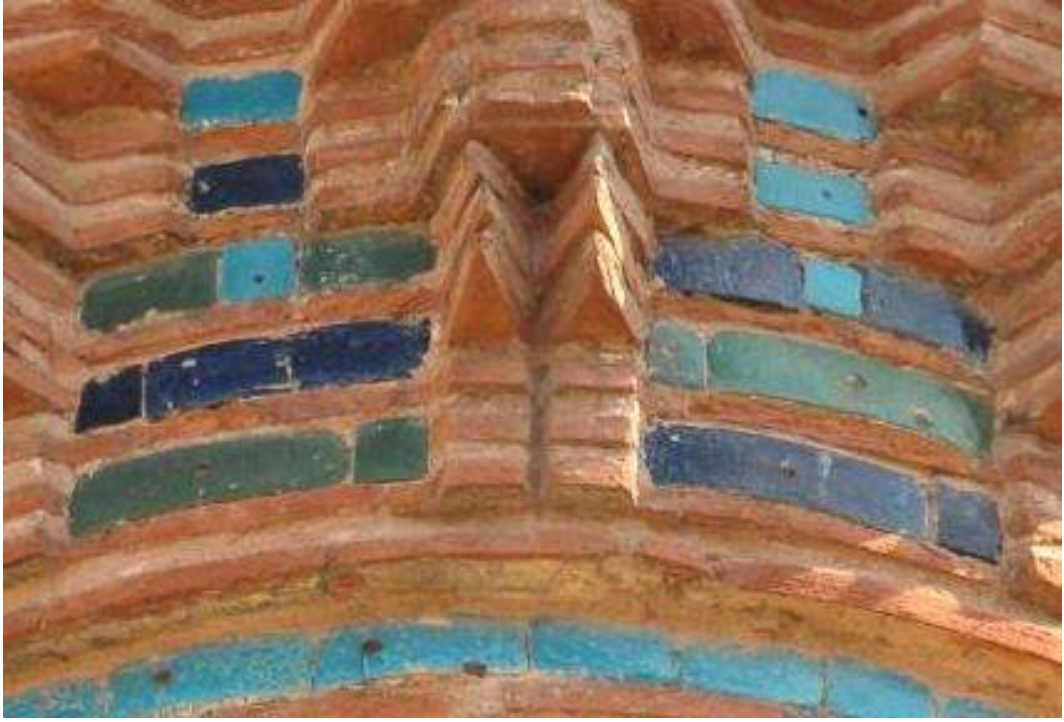
Fotoğraf: 309 Minarede sırlı tuğlaların çivi ile sabitlenmesi
