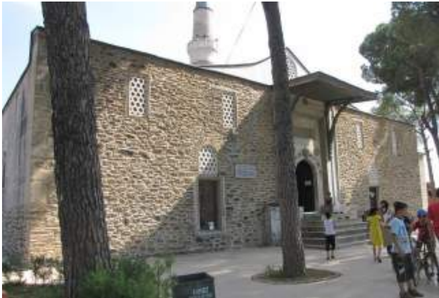
Fotoğraf: 196 Birgi Ulu Camii, kuzey cephe
