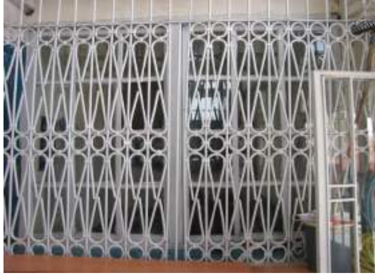
Fotoğraf: 291 Caminin son cemaat yerinden türbeyi ayıran camekân
