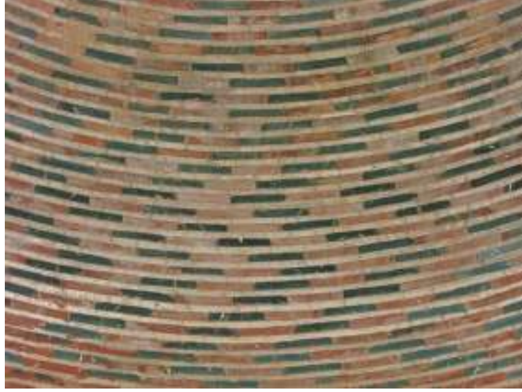
Fotoğraf: 235 Kubbe eteğinde zikzak şeklinde firuze sırlı tuğlalar
