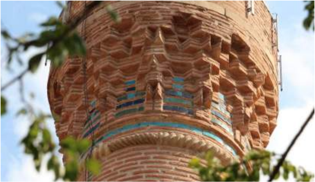
Fotoğraf: 308 Minarede sırlı tuğla bezeme
