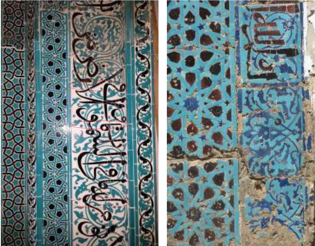
Fotoğraf: 125 Uygulamada ek yerlerinin derz harcı ile kapatılması
