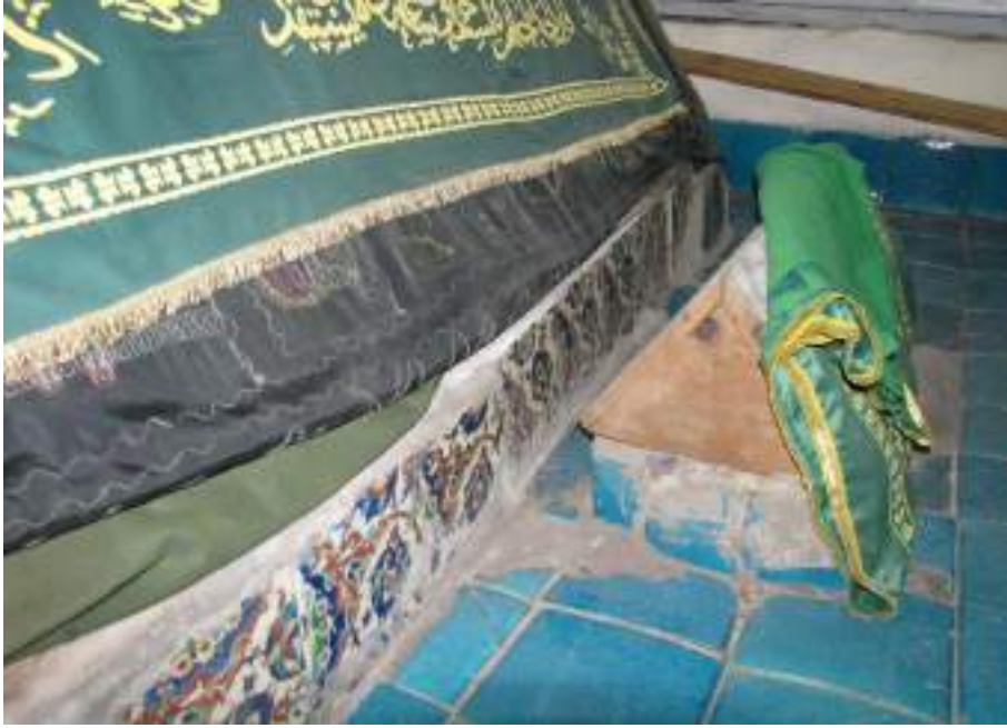
Fotoğraf: 297 Sandukaların kaide kısmında sır altı tekniğinde çini plakalar
