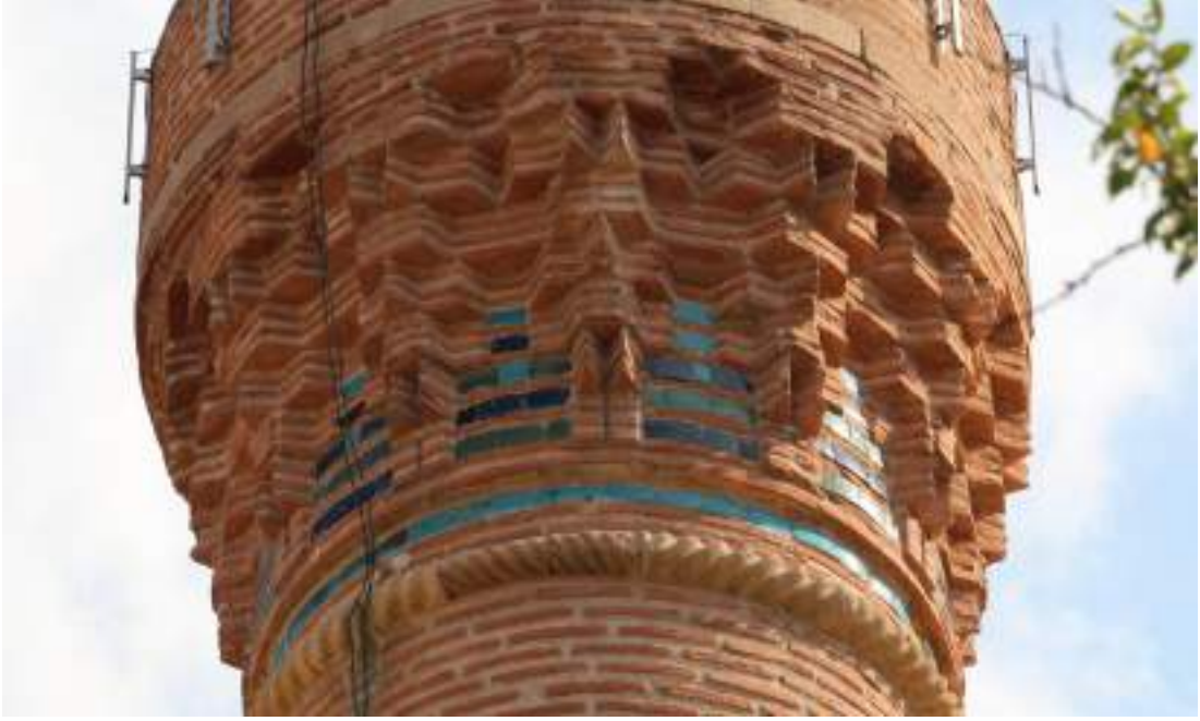
Fotoğraf: 307 Minarede sırlı tuğla bezeme
