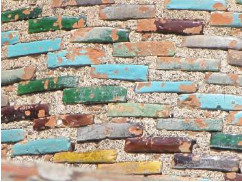
Fotoğraf: 376 Minare gövdesindeki deęişik renkte sırlı tuğlalar
