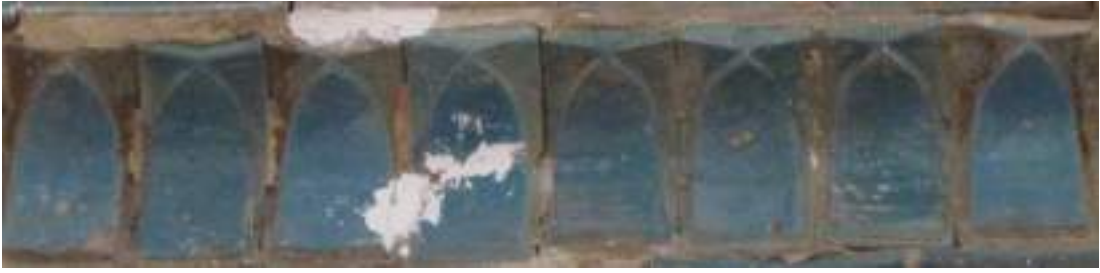
Fotoğraf: 268 Pandantiflerin üst kısmını oluşturan çini mukarnaslar, ayrıntı
