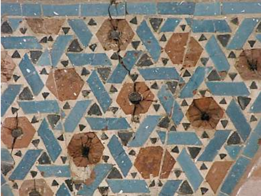
Fotoğraf: 127 Belli ölçülerde hazırlan birimlerin çivi ile sabitlenmesi (Konya Karatay Medresesi- Selçuk İsa Bey Camii)
