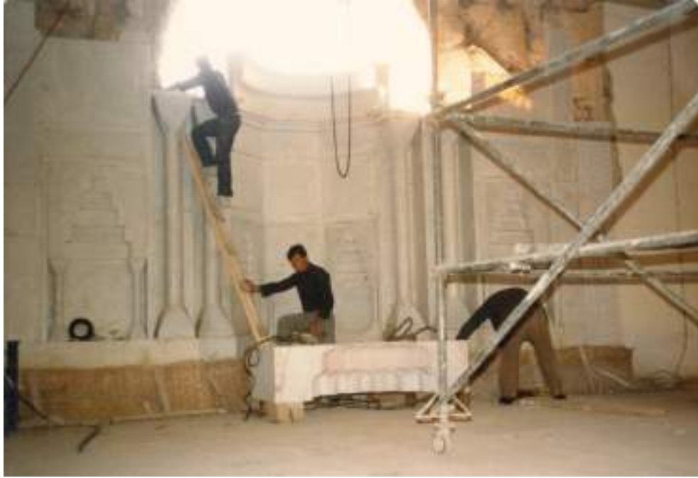
Fotoğraf: 258 Selçuk İsa Bey Camii, mihrabın yeniden inşası (VGM arşivi)
