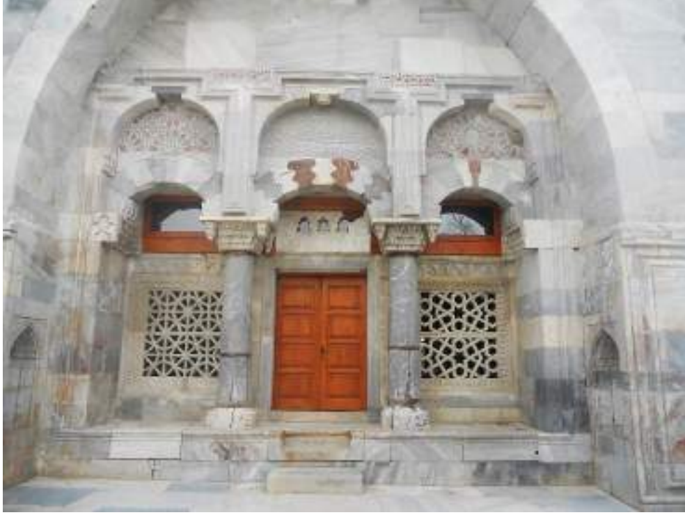
Fotoğraf: 345 Balat İlyas Bey Camii, taç kapı (Restorasyon sonrası)
