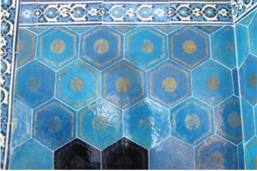
Fotoğraf: 159 Bursa Şehzâde Cem türbesi, tek renk sır üstü yıldız uygulaması
