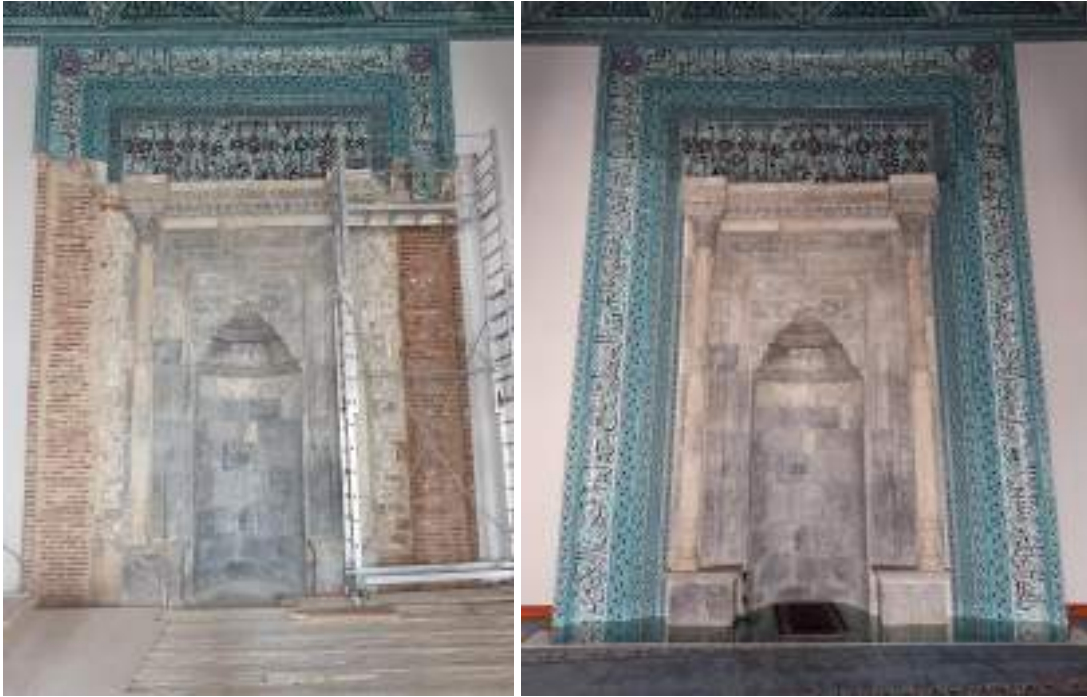
Fotoğraf: 50 Konya Alâeddin Camii Mihrabı, Restorasyon Çalışması
