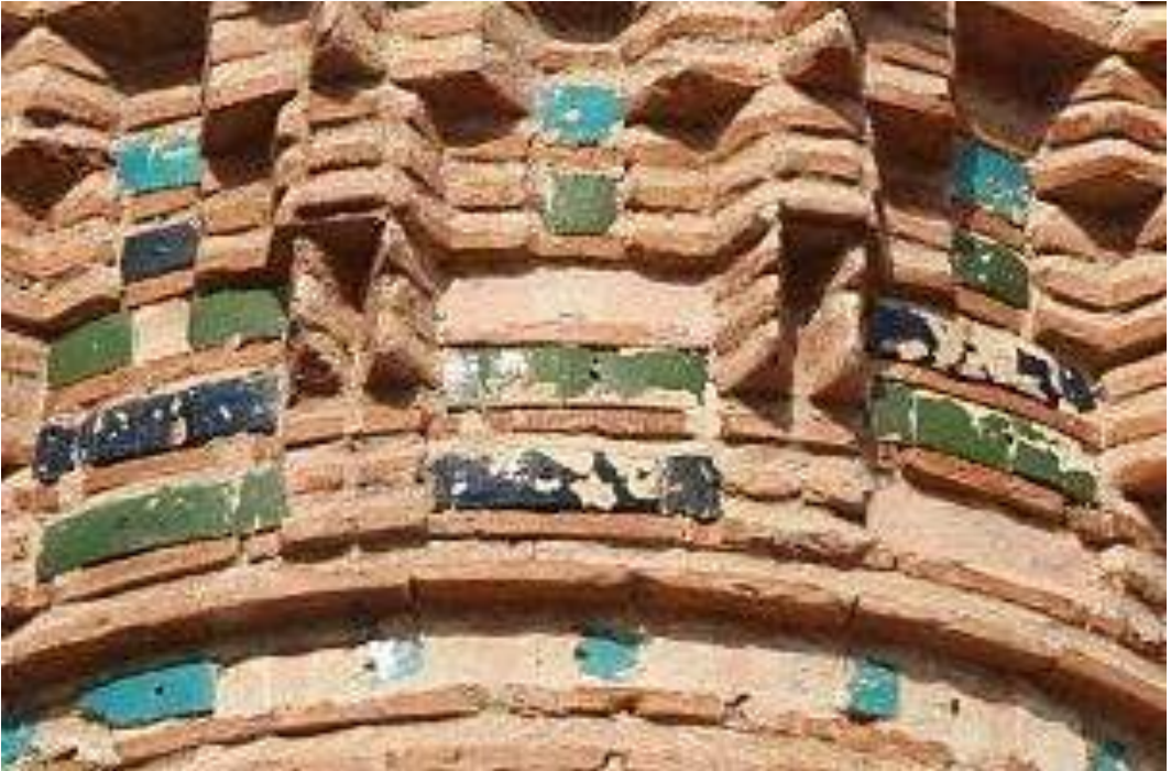
Fotoğraf: 310 Minarede sırlı tuğla bezeme, ayrıntı
