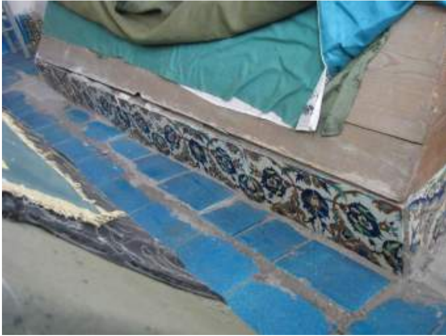
Fotoğraf: 296 Sandukaların kaide kısmında sır altı tekniğinde çini plakalar
