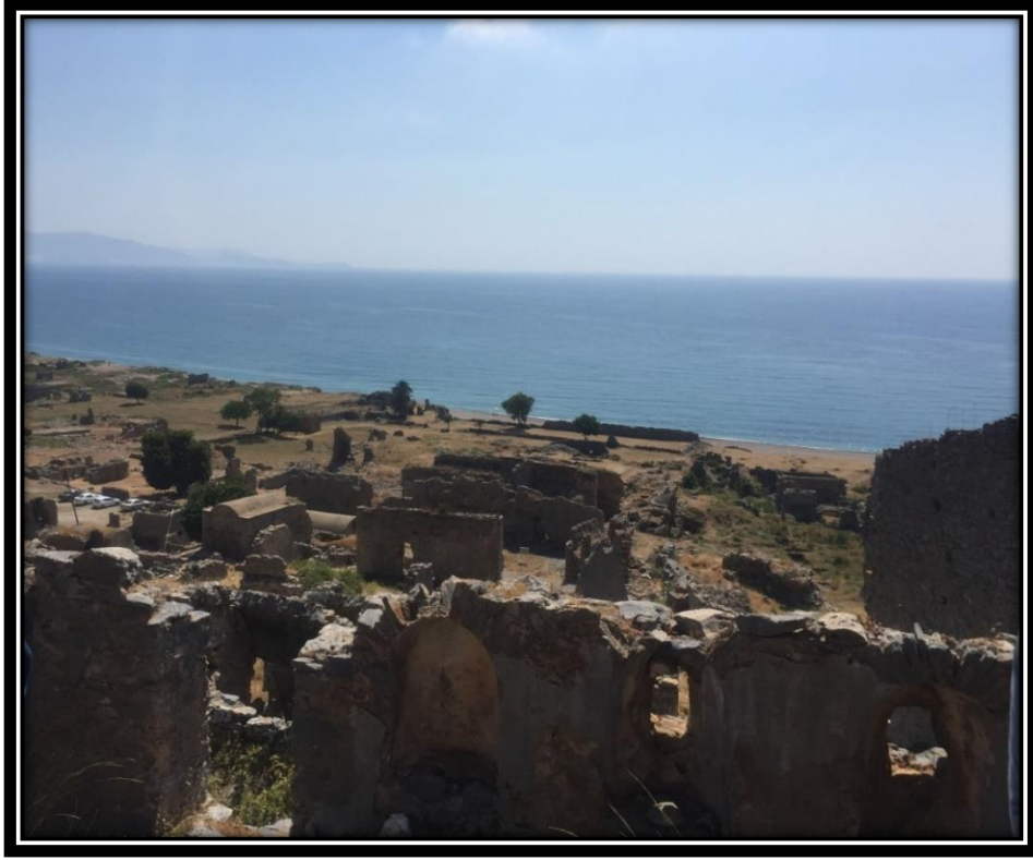
Şekil 3.2. Anemurium Antik Kent alanında hasar gören taş yapıların genel görünümü
