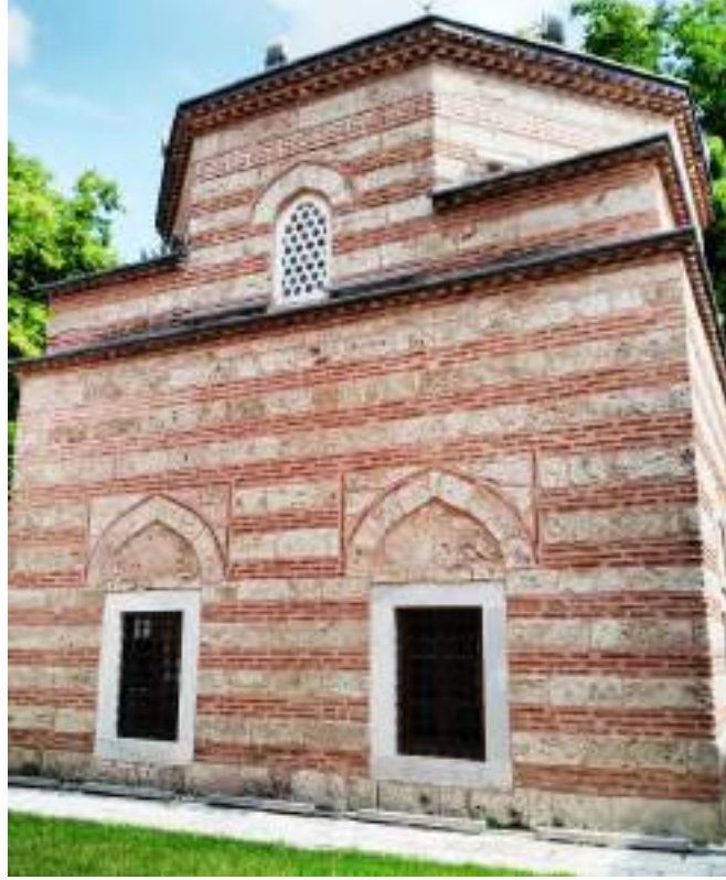
Fotoğraf 62. Türbenin batı cephesinde alt ve üst katta yer alan pencereler (F: Baysal, 2025).
