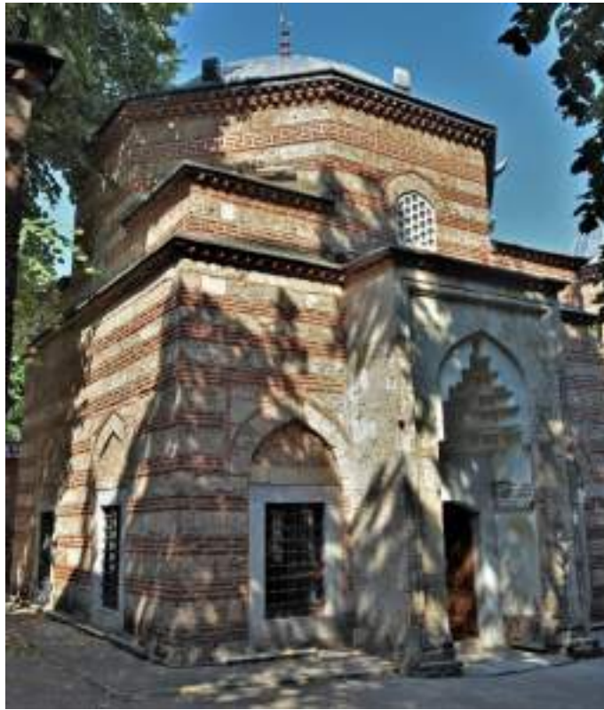
Fotoğraf 82. Mükrim Hatun Türbesi (Şah Sultan Türbesi) restorasyon sonrası dıştan görünüm (F: Baysal, 2025).
