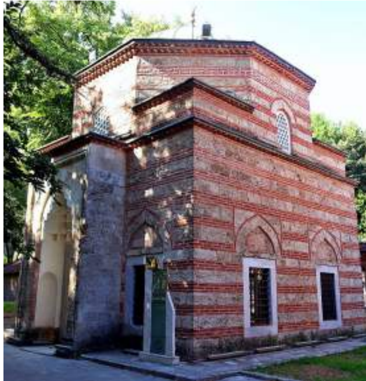
Fotoğraf 13. Mükreme Hatun Türbesi dıştan görünüm (F: Baysal, 2025).
