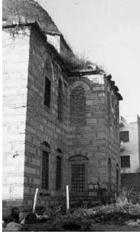
Fotoğraf 54. Zircirli Camii'nin konservasyon çalışmaları başlamadan önce güneyden görünümü (Argyris Bakirtzis ve Sambanopoulou, 2009).
