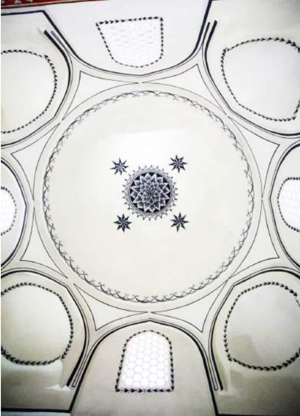
Fotoğraf 70. Mükrim Hatun Türbesi (Şah Sultan Türbesi) kubbe (F: Baysal, 2025).
