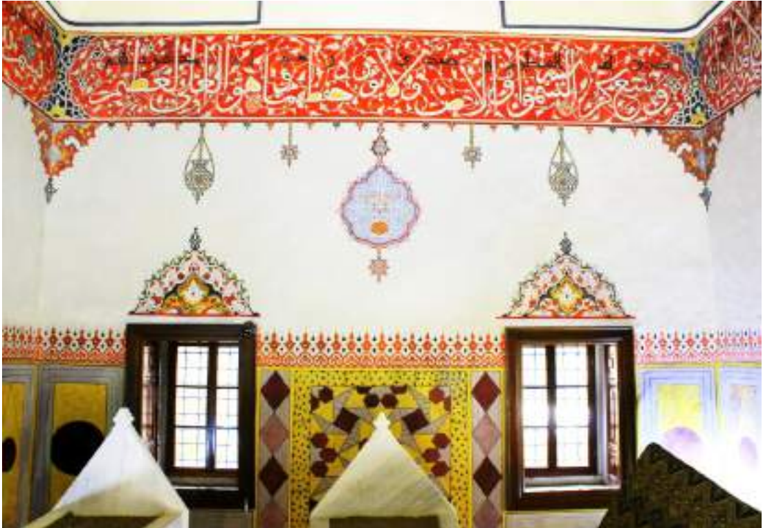
Fotoğraf 75. Mükrim Hatun Türbesi (Şah Sultan Türbesi) batı duvarı (F: Baysal, 2025).
