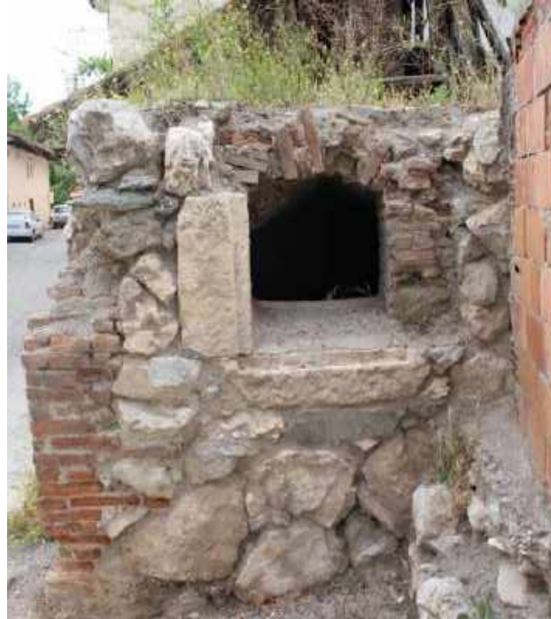
Resim 326: Çiğdem Sokak Çeşmesi, Batı Cephe
