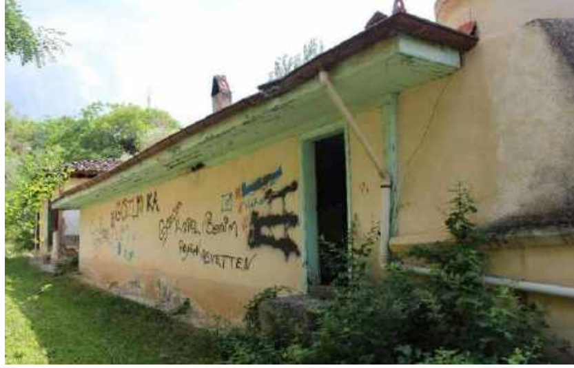
Resim 221: Kuşçular Köyü Merkez Cami, Doğu Cephe
