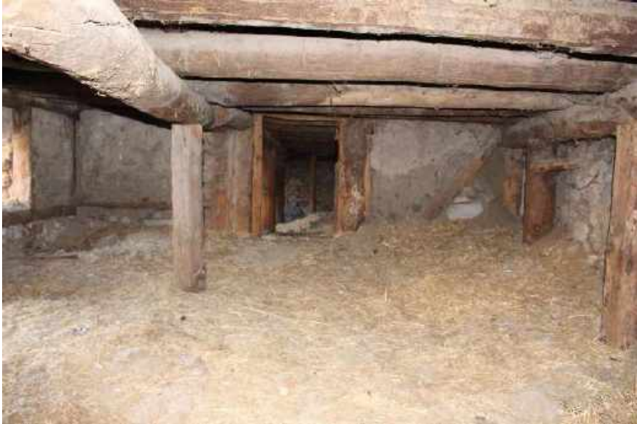
Resim 347: 177 Ada 2 Parseldeki Ev, Bodrum Kat, Ahır ve Samanlık
