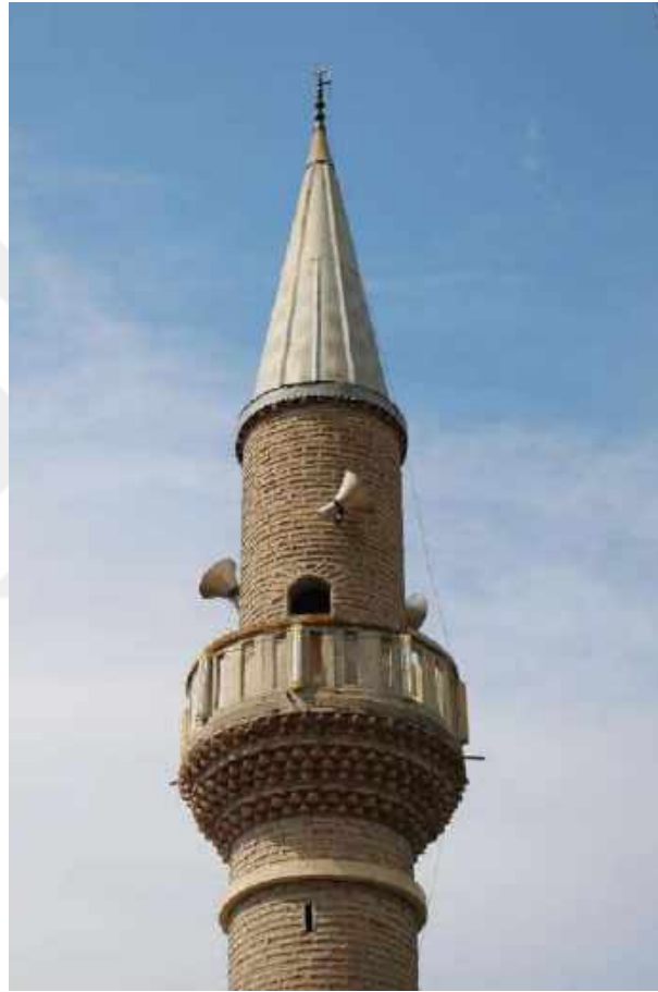
Resim 225: Kuşçular Köyü Merkez Cami, Minare
