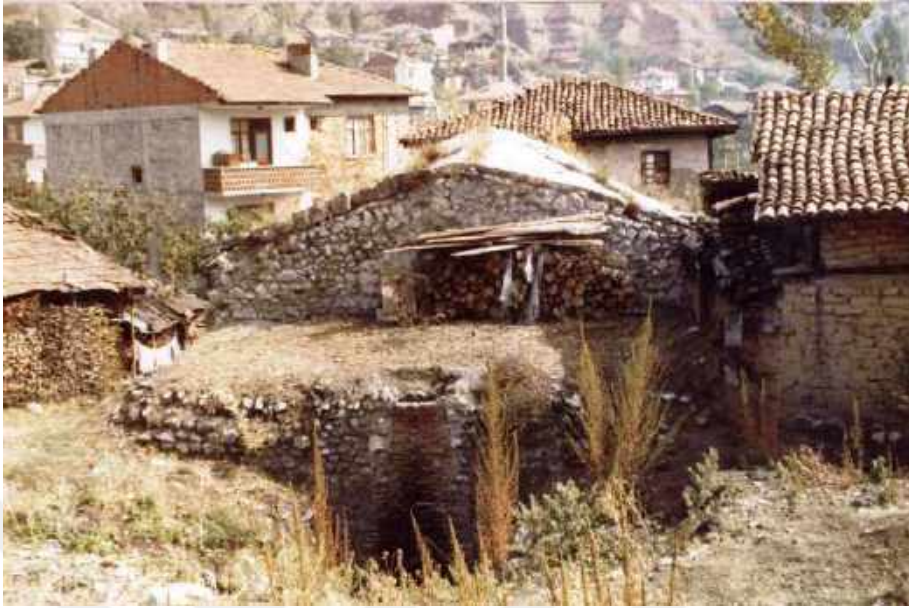
Resim 307: Tekke Hamamı, Batı Cephe, Su Deposu Bölümü (VGM Arşivi- 1992)
