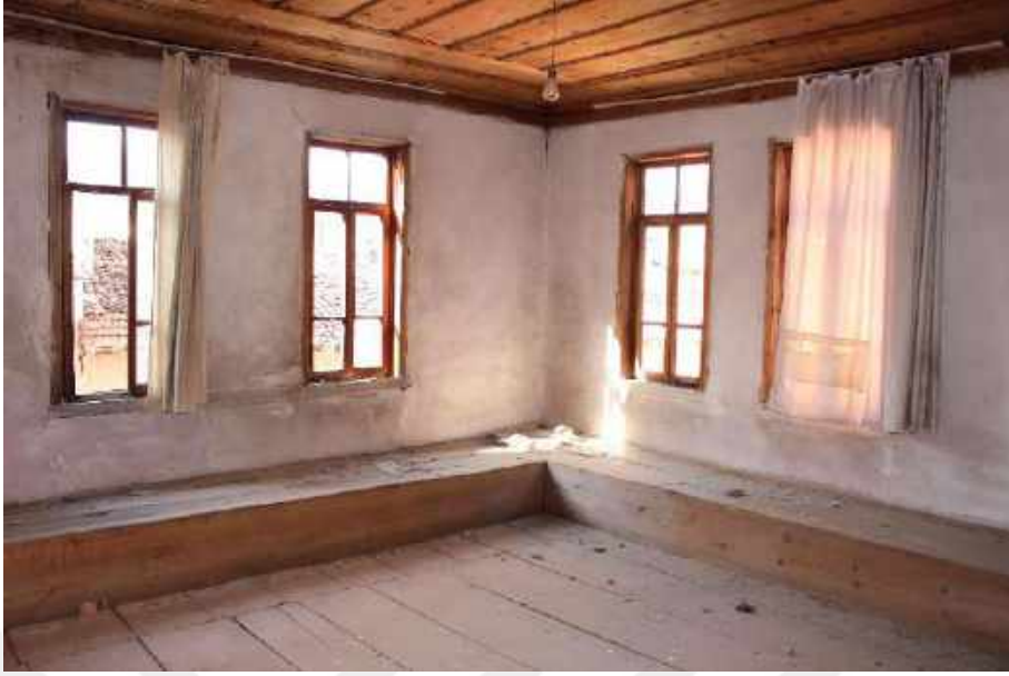
Resim 382: 141 Ada 1 Parseldeki Ev, Birinci Kat, Sağdaki Oda, Doğu ve Güney Duvarı
