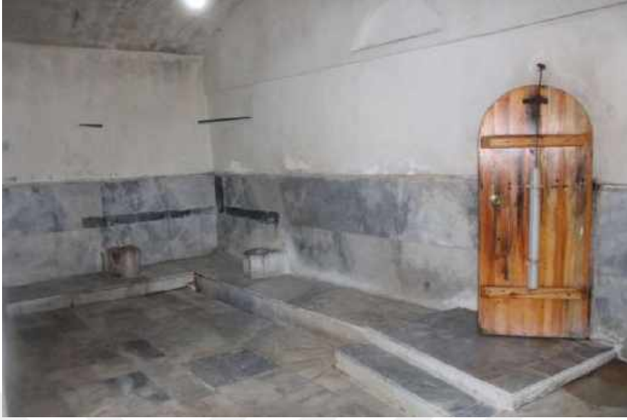
Resim 312: Tekke Hamamı, Ilıklık Bölümü, Güney ve Batı Duvarları
