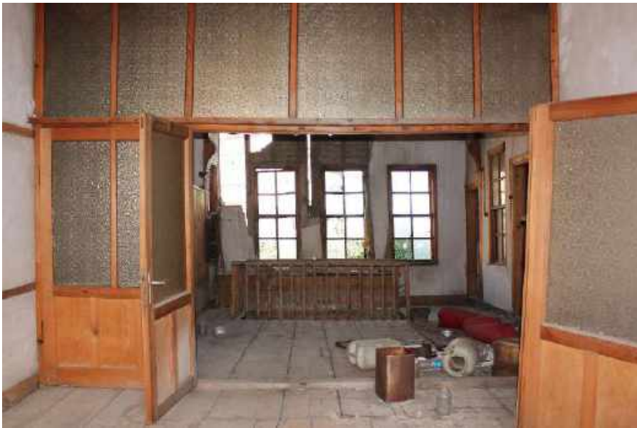
Resim 387: 141 Ada 1 Parseldeki Ev, İkinci Kat, Eyvandan Sofa Bölümüne Bakış
