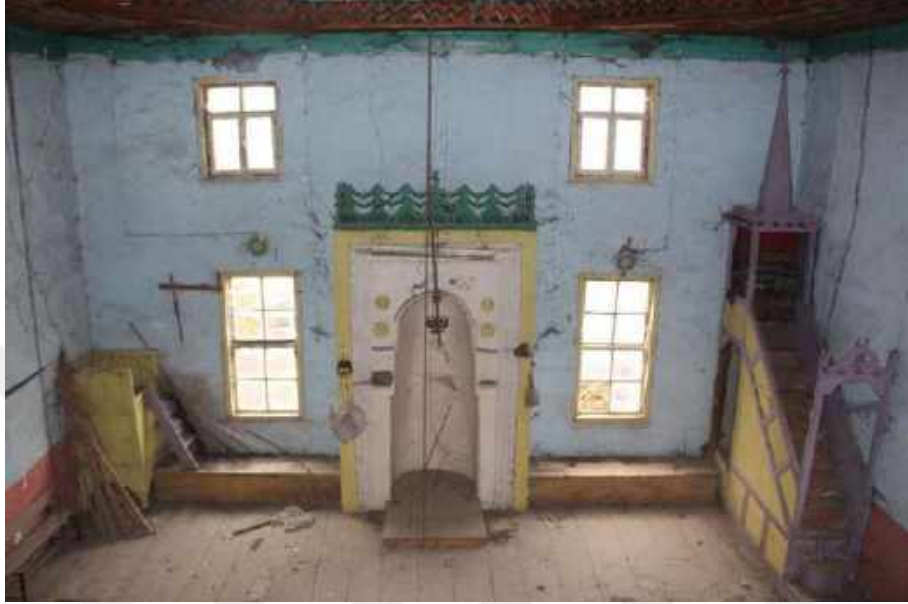
Resim 144: Ekincik Köyü Cami, Harim, Güney Duvarı
