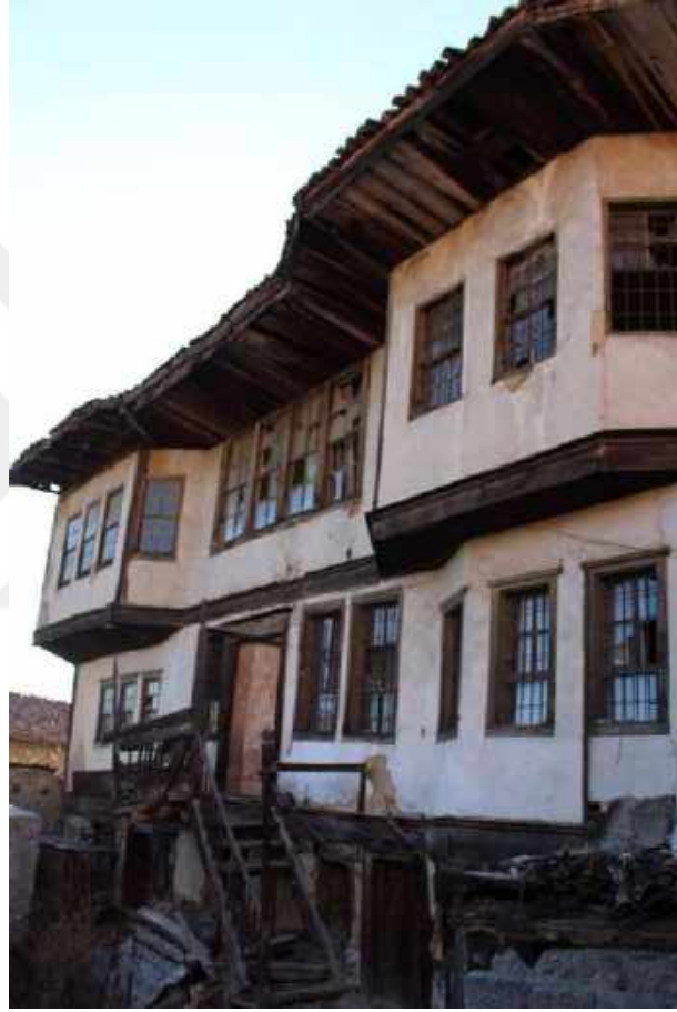
Resim 343: 177 Ada 2 Parseldeki Ev, Doğu Cephe
