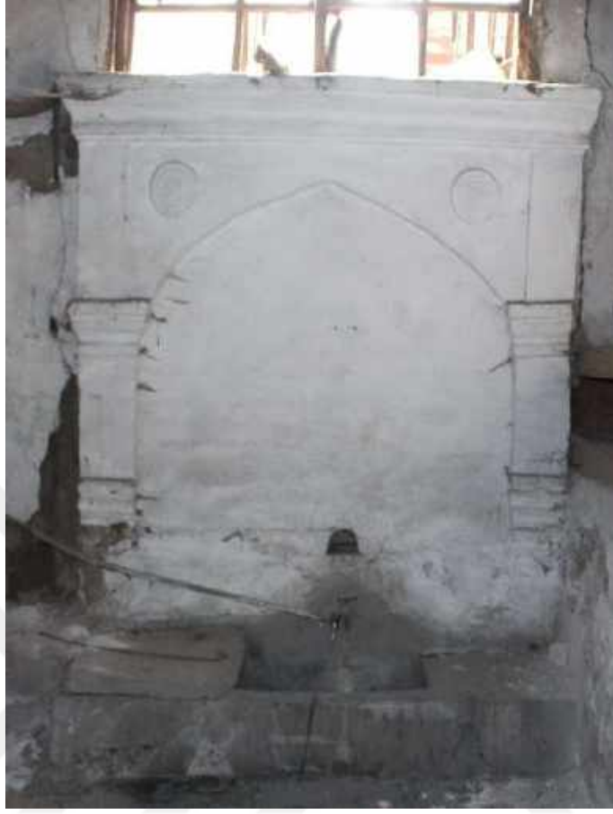
Resim 377: 141 Ada 1 Parseldeki Ev, Taş Mutfakta Bulanan Çeşme
