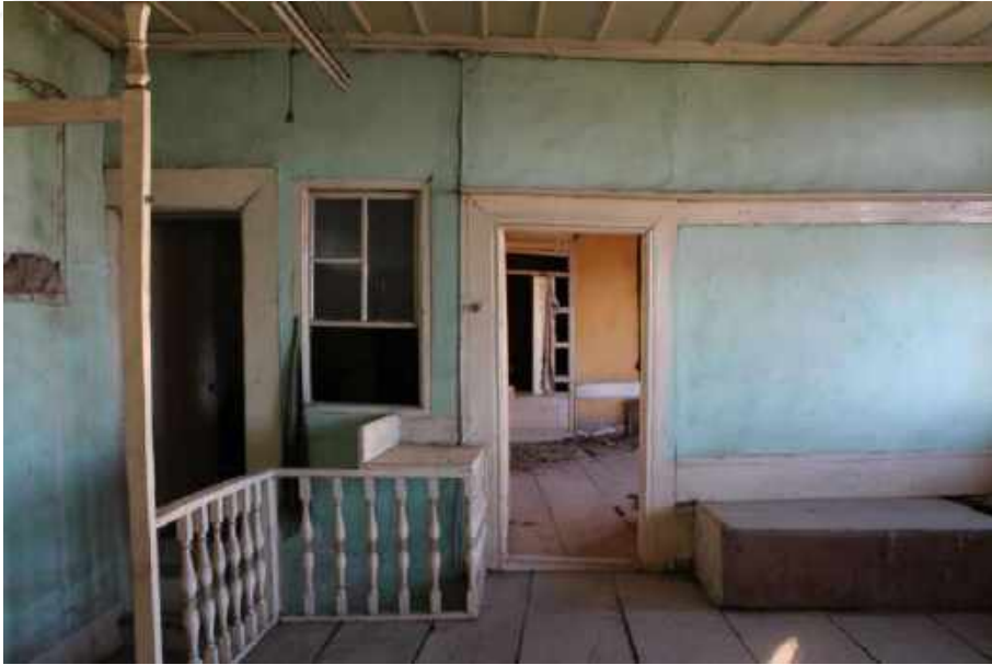
Resim 359: 177 Ada 2 Parseldeki Ev, Birinci Kat, Sofa, Kuzey Duvarı
