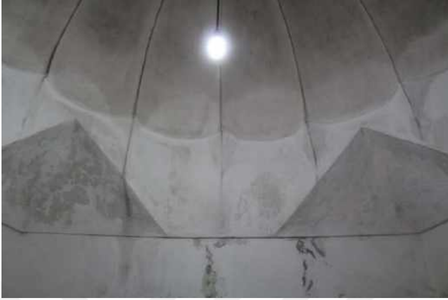
Resim 267: Vık-Vık Hamamı, Sıcaklık Bölümü, Üst Örtü Geçiş Elemanları
