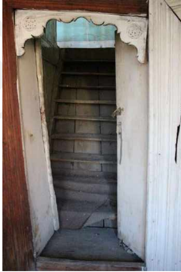
Resim 358: 177 Ada 2 Parseldeki Ev, Zemin Kat, Merdiven
