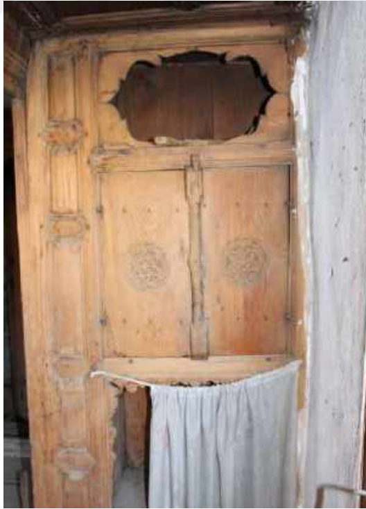
,Resim 357: 177 Ada 2 Parseldeki Ev, Zemin Kat, Soldaki Oda, Dolap Detayı
