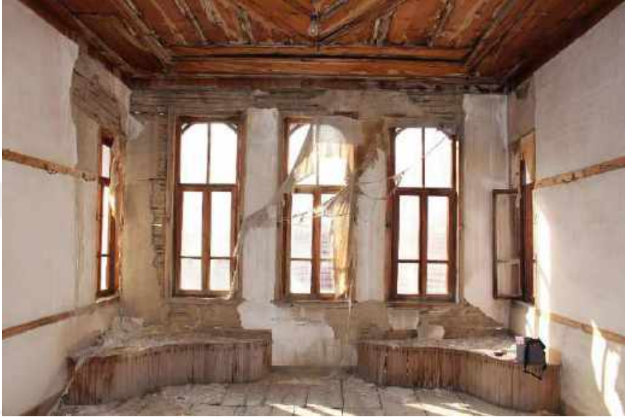
Resim 386: 141 Ada 1 Parseldeki Ev, İkinci Kat, Eyvan, Doğu Duvarı
