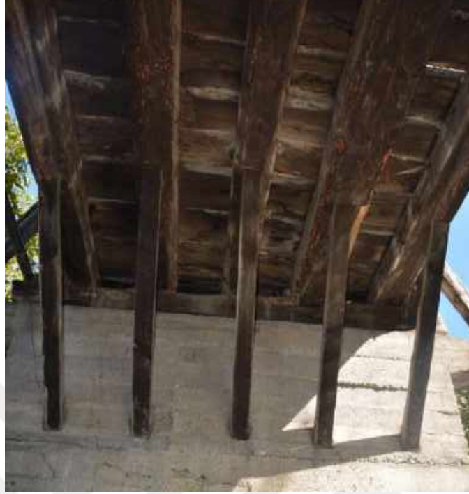
Resim 342: Dört Ocak Köprüsü, Tabanı Destekleyen Ahşap Kirişler
