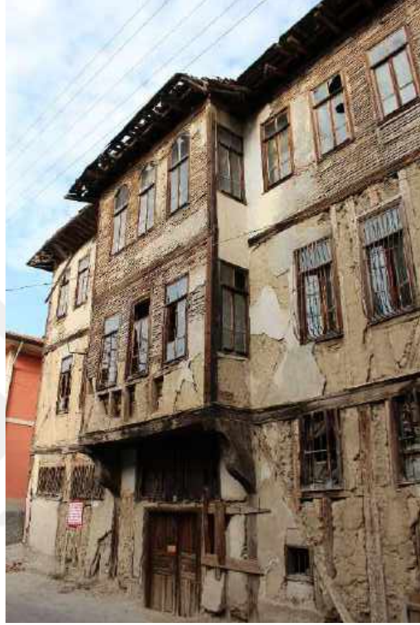
Resim 369: 141 Ada 1 Parseldeki Ev, Doğu Cephe
