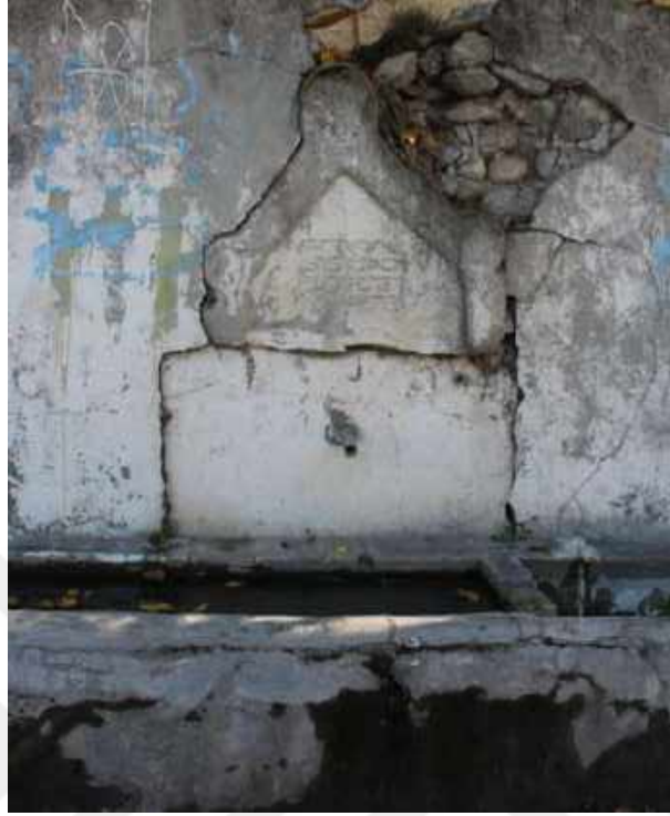
Resim 324: Karayılan Ođlu eşmesi, Kuzey Cephe
