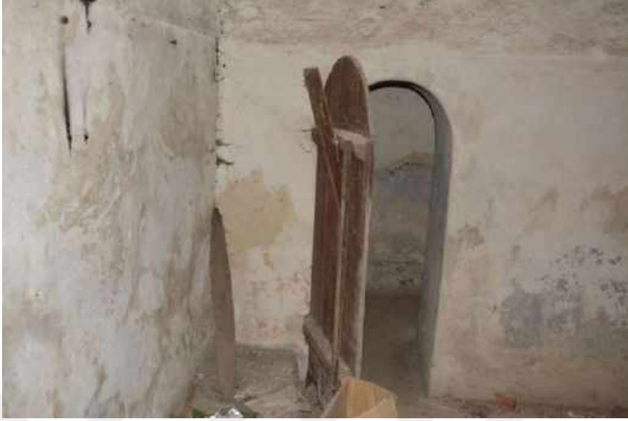
Resim 246: Şifa Hamamı, Aralık Mekanından Ilıklık Bölümüne Geçiş
