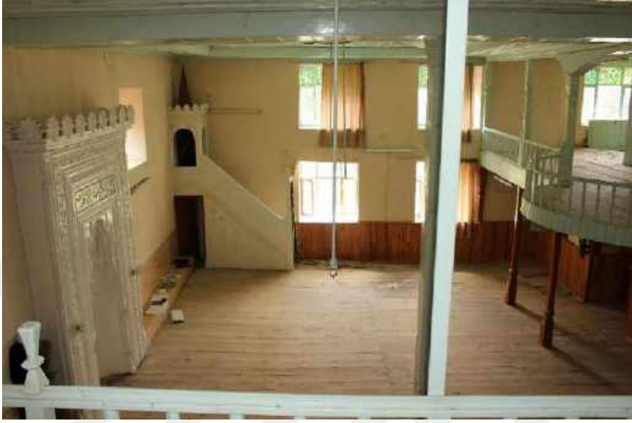
Resim 228: Kuşçular Köyü Merkez Cami, Harim, Güney ve Batı Duvarı
