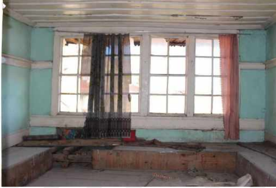
Resim 360: 177 Ada 2 Parseldeki Ev, Birinci Kat, Sofa, Dođu Duvarı
