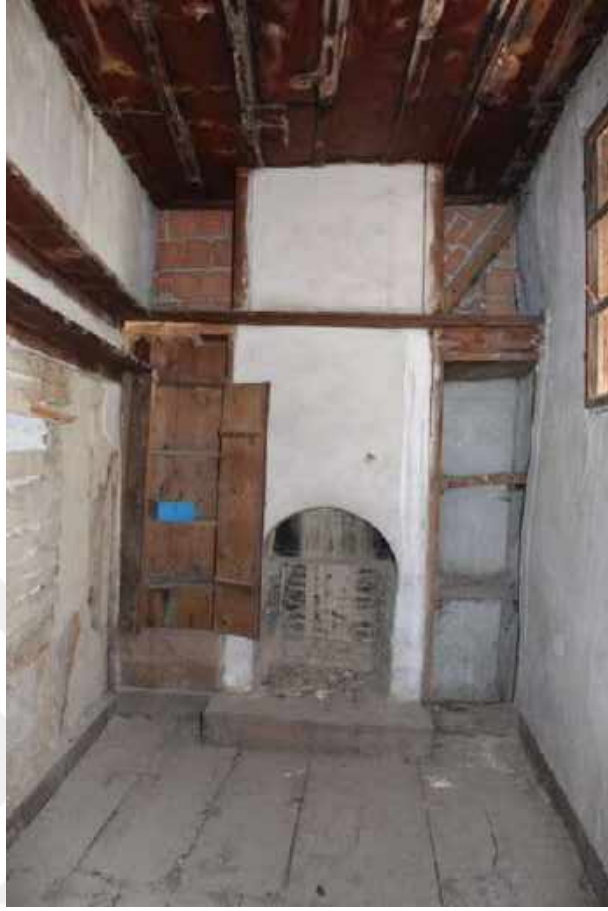
Resim 367: 177 Ada 2 Parseldeki Ev, Birinci Kat, Mutfak, Güney Duvar
