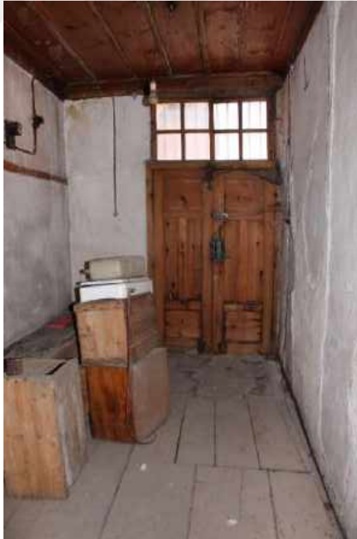
Resim 378: 141 Ada 1 Parseldeki Ev, Birinci Kat, Giriş Holü, Güney Duvarı
