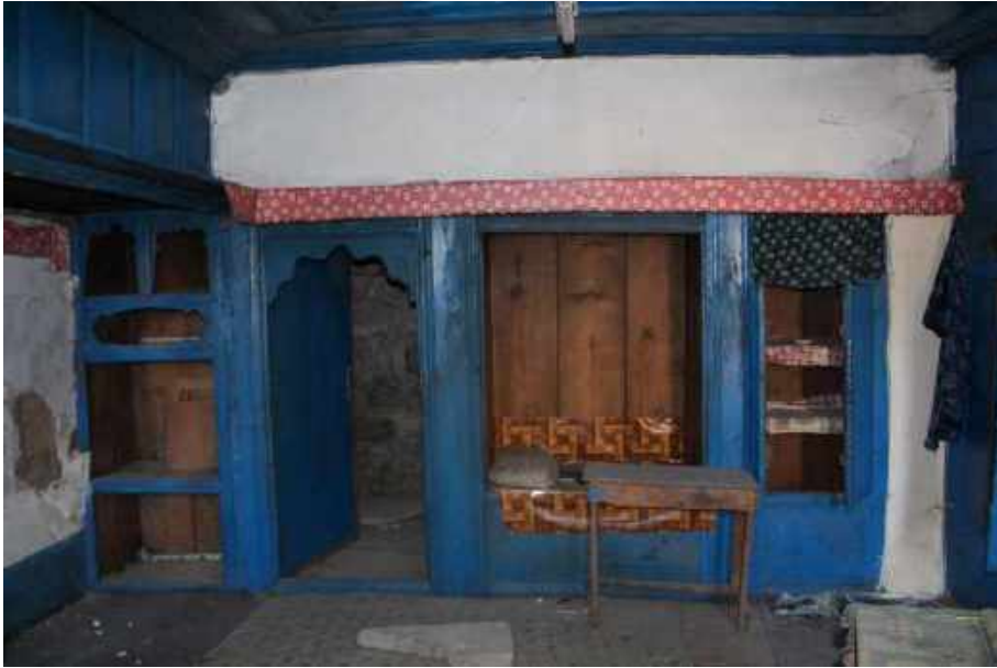
Resim 353: 177 Ada 2 Parseldeki Ev, Zemin Kat, Sağdaki Oda, Batı Duvarı
