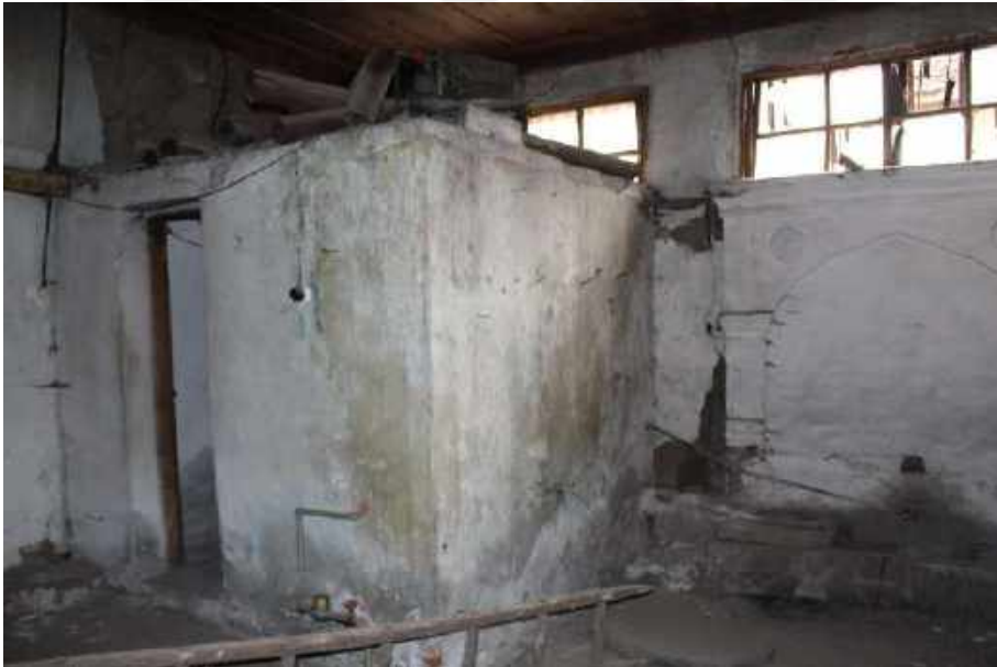
Resim 376: 141 Ada 1 Parseldeki Ev, Zemin Kat, Taş Mutfak, Doğu Duvarı
