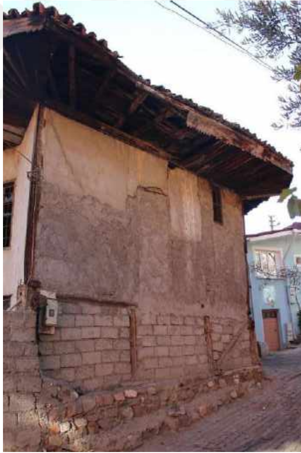
Resim 345: 177 Ada 2 Parseldeki Ev, Kuzey Cephe
