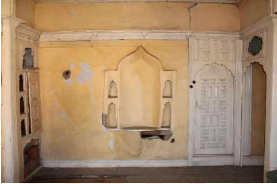
Resim 366: 177 Ada 2 Parseldeki Ev, Birinci Kat, Sağdaki Oda, Batı Duvarı
