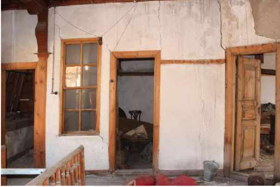
Resim 393: 141 Ada 1 Parseldeki Ev, İkinci Kat, Sofa, Kuzey Duvarı
