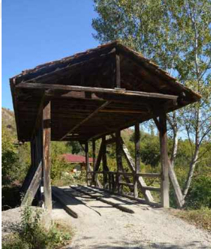
Resim 341: Dört Ocak Köprüsü, Doğu Cephe
