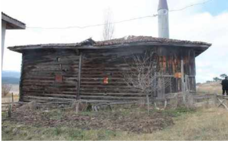
Resim 151: Kilkuyu Köyü Cami, Doğu Cephe (Eha Yapı Mimarlık-2019)
