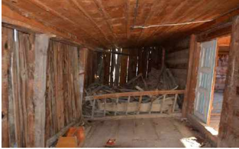
Resim 155:Kilkuyu Köyü Cami, Son Cemaat Yeri, Doğuya Bakış
