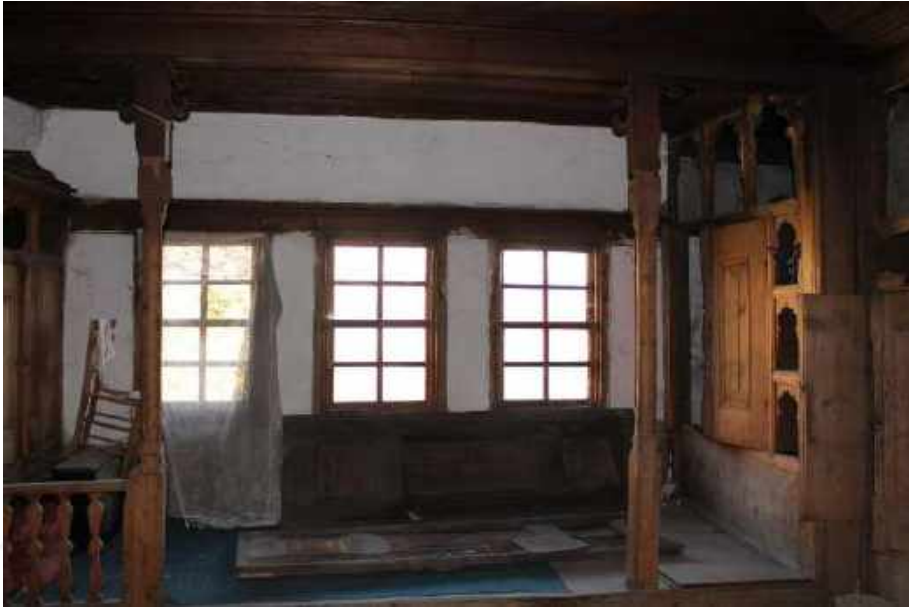
Resim 354: 177 Ada 2 Parseldeki Ev, Zemin Kat, Soldaki Oda, Doğu Duvarı
