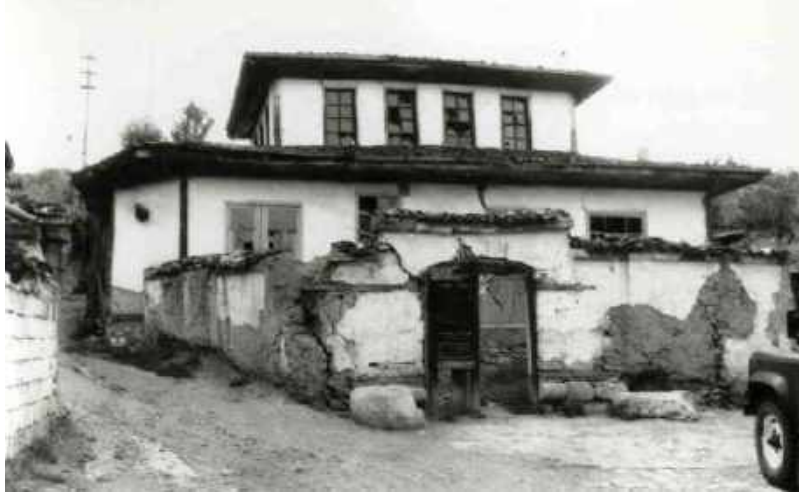
Resim 303: Tekke Hamamı, Doğu Cephe (VGM Arşivi-1989)
