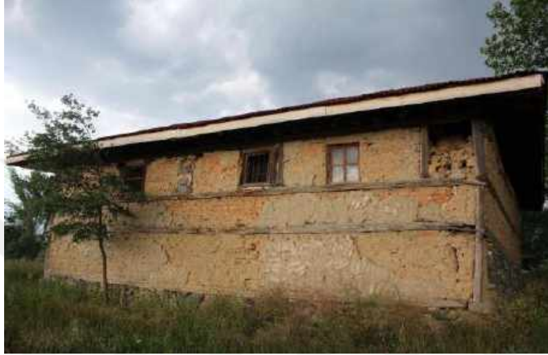
Resim 107: Kuşçular Köyü Eski Cami, Batı Cephe
