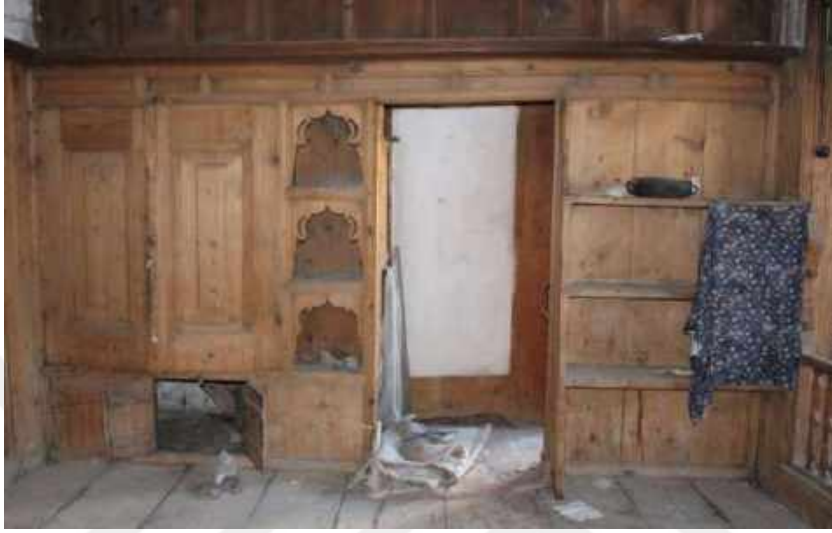
Resim 356: 177 Ada 2 Parseldeki Ev, Zemin Kat, Soldaki Oda, Kuzey Duvarı
