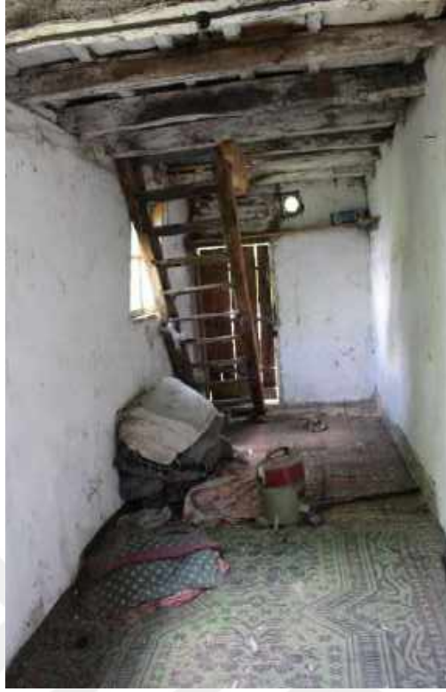
Resim 213: Çaykapı Köyü Cami, Son Cemaat Yeri, Doğuya Bakış
