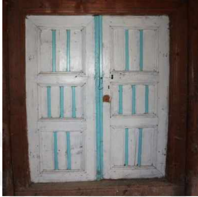
Resim 158: Kilkuyu Köyü Cami, Harim Giriş Kapısı (Eha Yapı Mimarlık-2019)
