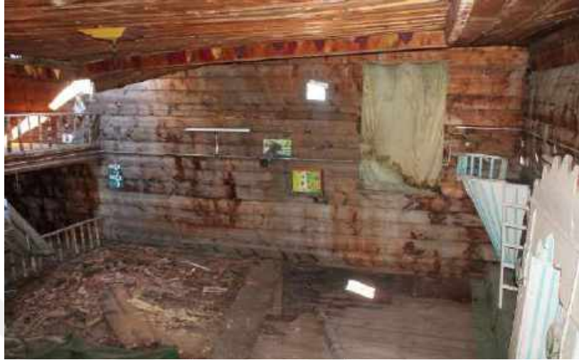
Resim 165: Kilkuyu Köyü Cami, Harim, Doğu Duvarı (Eha Yapı Mimarlık-2019)
