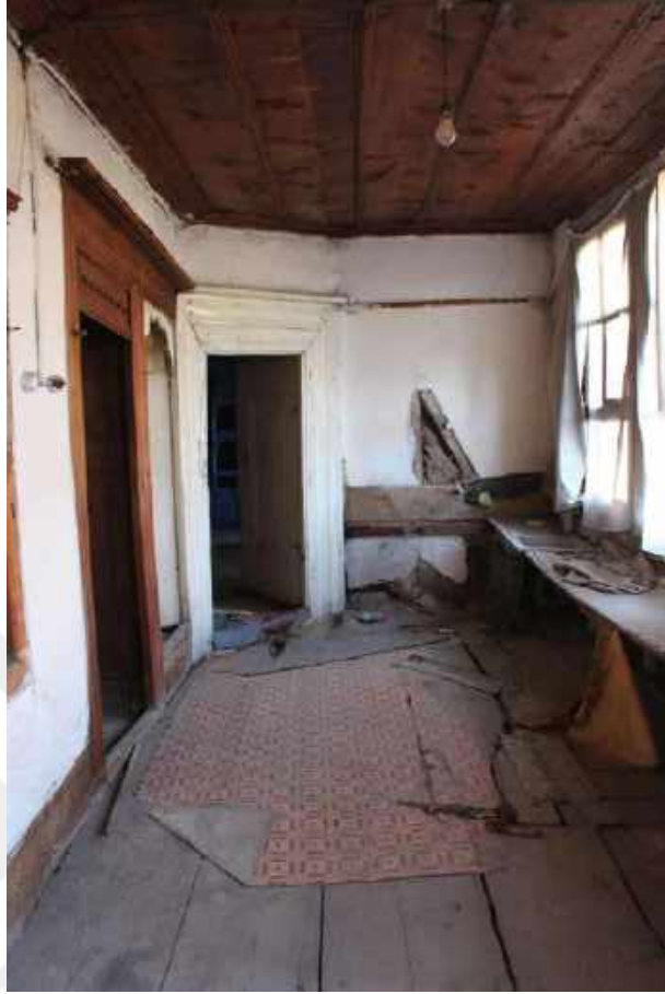
Resim 348: 177 Ada 2 Parseldeki Ev, Giriş Holü, Batıya Bakış
