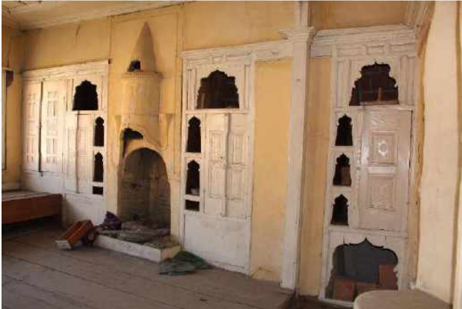
Resim 365: 177 Ada 2 Parseldeki Ev, Birinci Kat, Sağdaki Oda, Güney Duvarı
