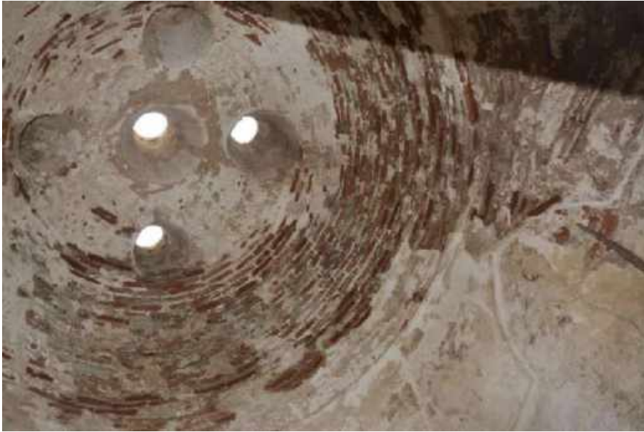
Resim 245: Şifa Hamamı, Aralık Bölümü, Üst Örtü
