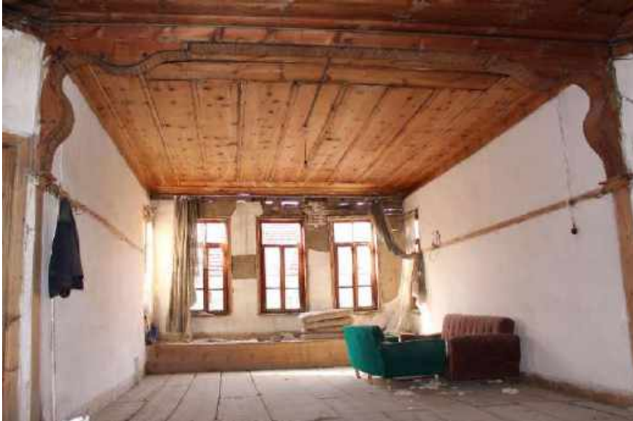
Resim 380: 141 Ada 1 Parseldeki Ev, Birinci Kat, Eyvan Bölümü, Doğu Duvarı
