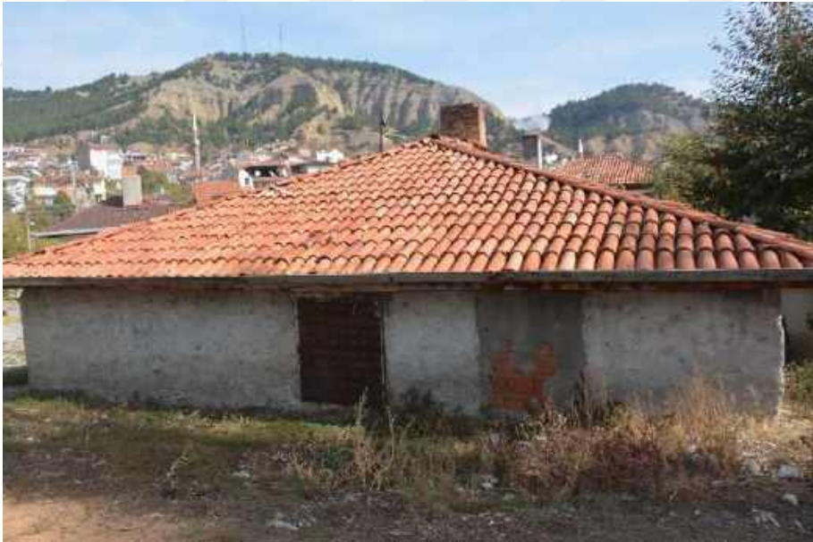
Resim 308: Tekke Hamamı, Batı Cephe, Su Deposu Bölümü
