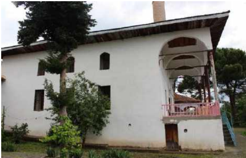
Resim 123: Çevlik Köyü Eski Mahalle Cami, Doğu Cephe
