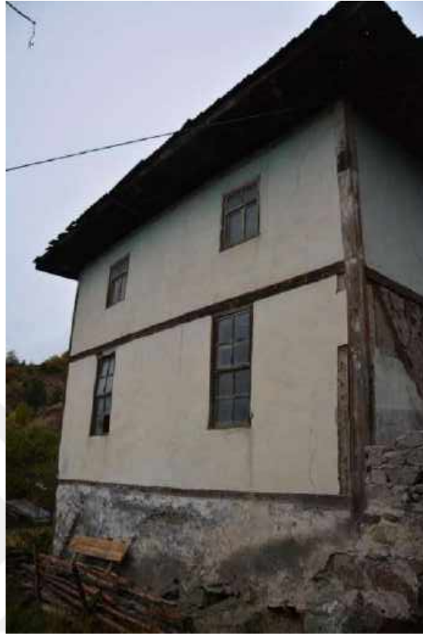
Resim 140: Ekincik Köyü Cami, Güney Cephe
