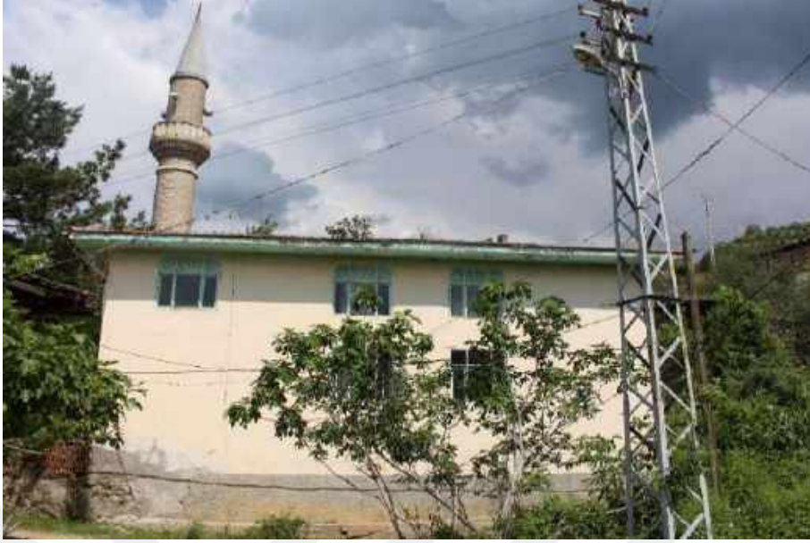
Resim 223: Kuşular Köyü Merkez Cami, Güney Cephe
