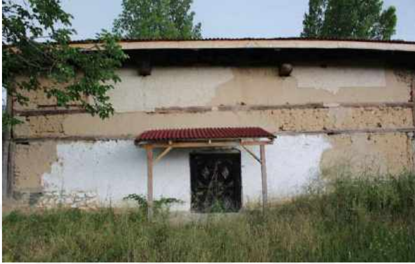
Resim 109: Kuşçular Köyü Eski Cami, Kuzey Cephe
