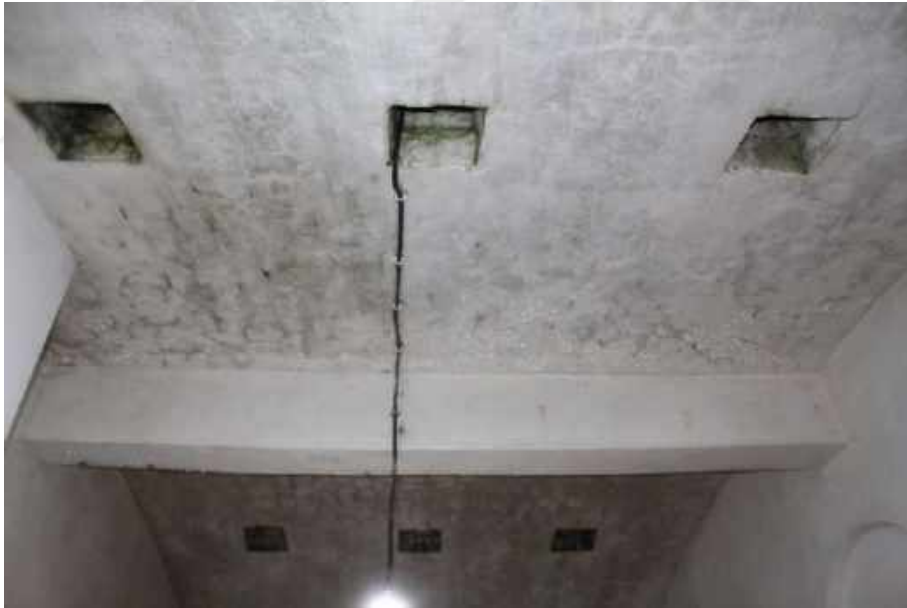
Resim 313: Tekke Hamamı, Ilıklık Bölümü, Üst Örtü
