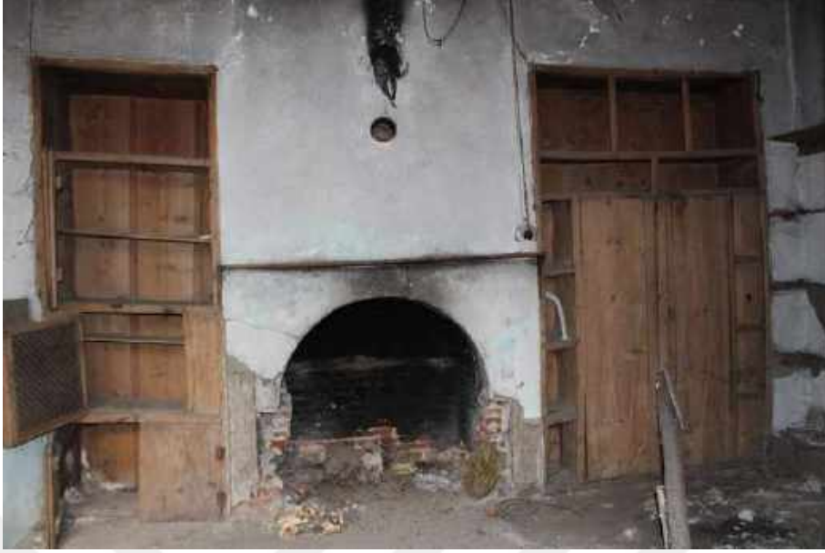
Resim 375: 141 Ada 1 Parseldeki Ev, Zemin Kat, Taş Mutfak, Batı Duvarı
