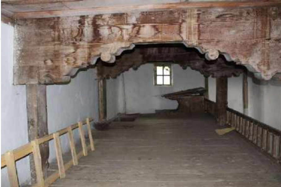
Resim 117: Kuşçular Köyü Eski Cami, Mahfil Katı Doğuya Bakış
