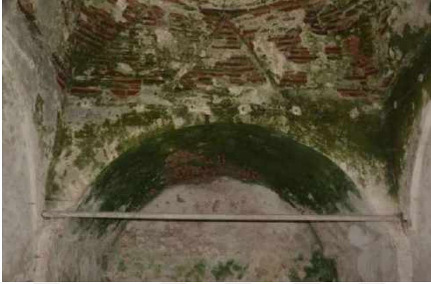
Resim 252: Şifa Hamamı, Sıcaklık Bölümü, Doğu Eyvan Üst Örtü
