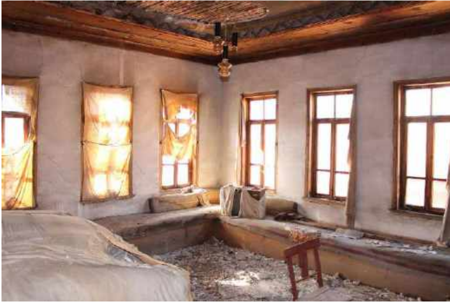
Resim 390: 141 Ada 1 Parseldeki Ev, İkinci Kat, Sağdaki Oda, Doğu ve Güney Duvarı
