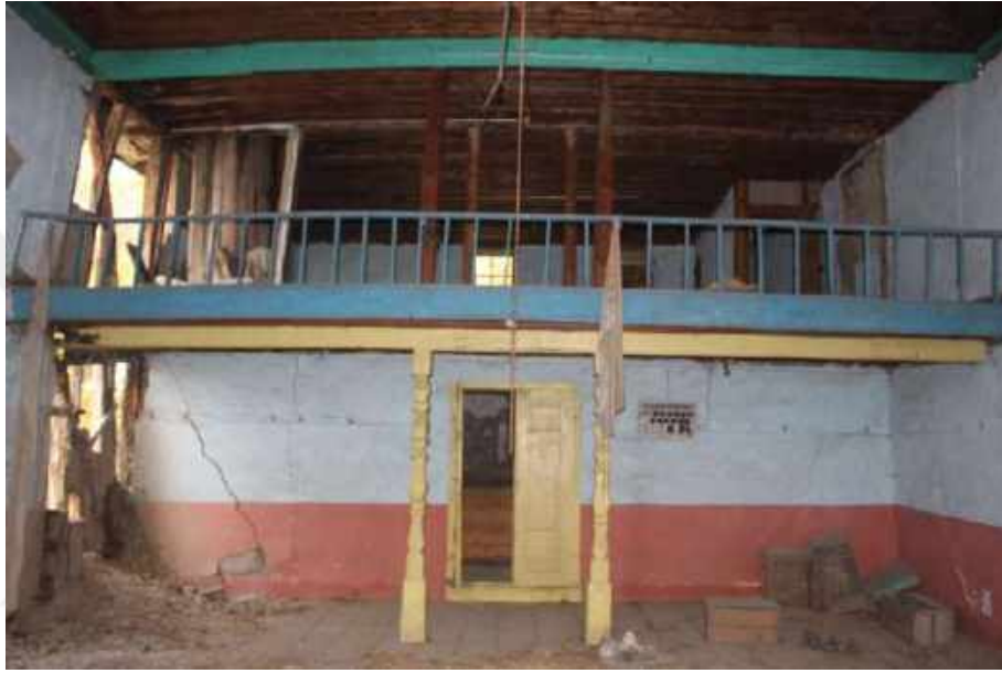
Resim 147: Ekincik Köyü Cami, Harim, Kuzey Duvarı ve Mahfil
