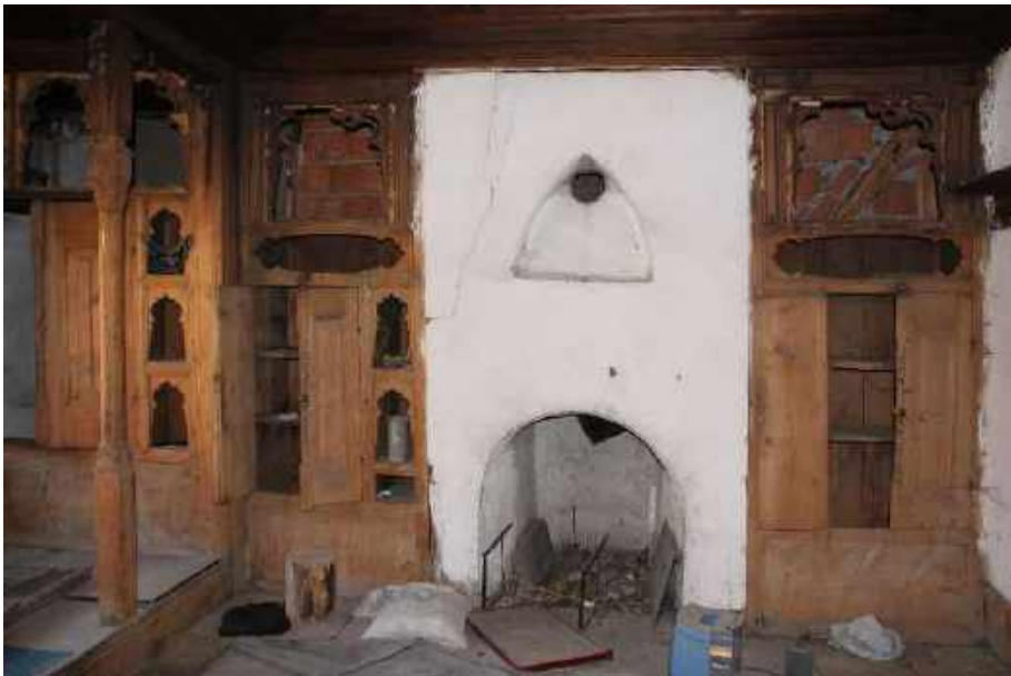
Resim 355: 177 Ada 2 Parseldeki Ev, Zemin Kat, Soldaki Oda, Güney Duvarı
