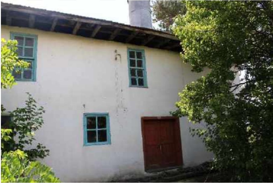
Resim 211: Çaykapı Köyü Cami, Kuzey Cephe
