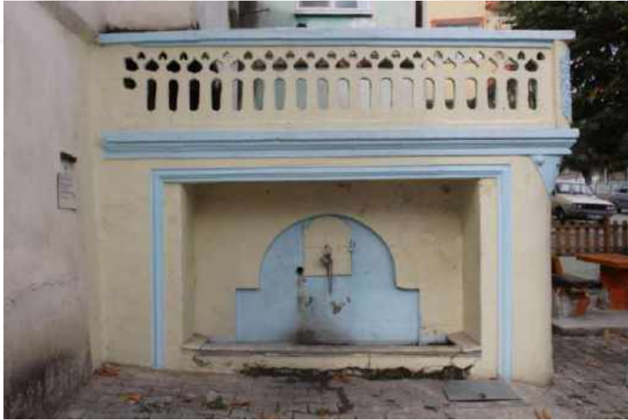
Resim 334: Tulumbacılar Çeşmesi, Doğu Cephe
