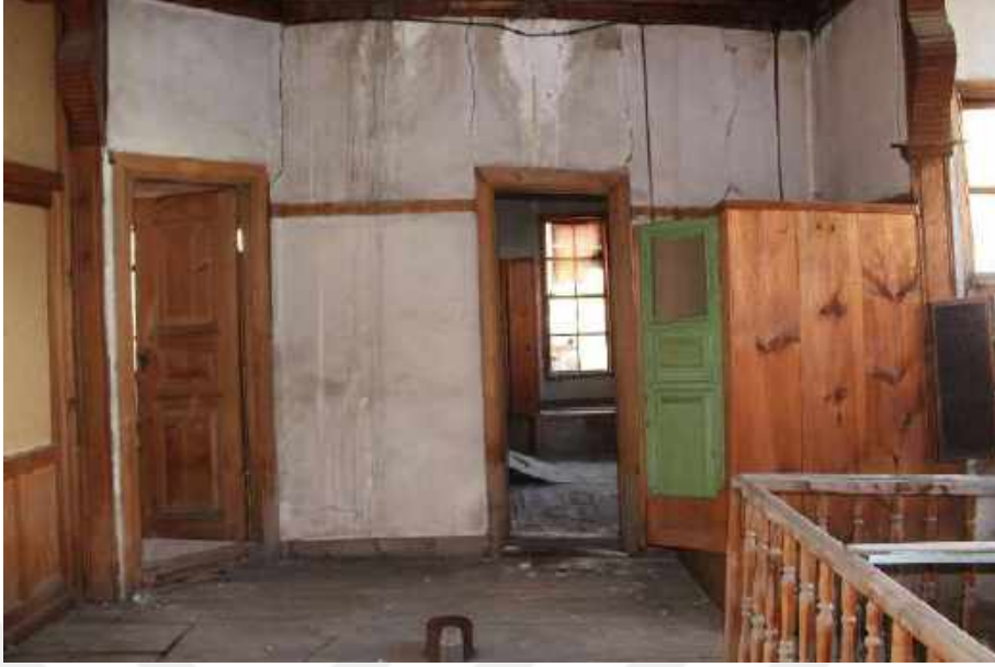
Resim 395: 141 Ada 1 Parseldeki Ev, İkinci Kat, Sofanın Güney Duvarı
