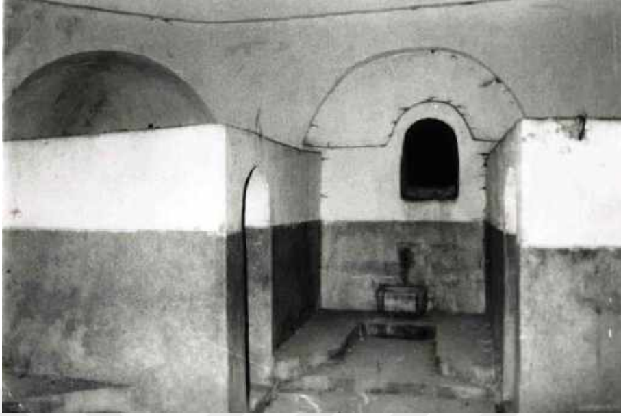
Resim 315: Tekke Hamamı, Sıcaklık Bölümü, Batı Duvarı (VGM Arşivi-1991)
