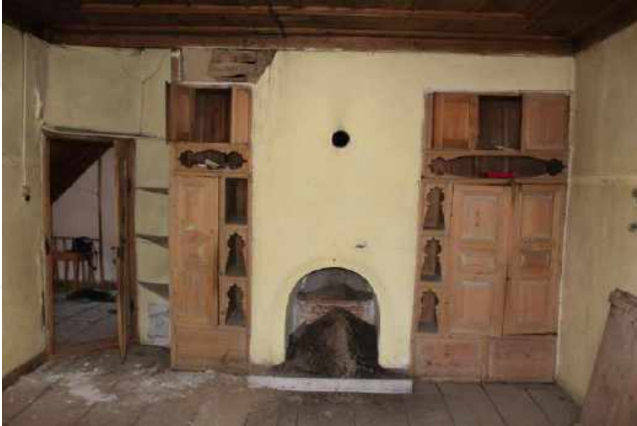
Resim 381: 141 Ada 1 Parseldeki Ev, Birinci Kat, Soldaki Oda, Batı Duvarı
