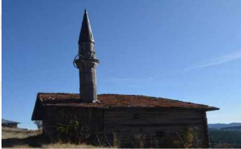
Resim 196: akırlar Ky Cami, Batı Cephe
