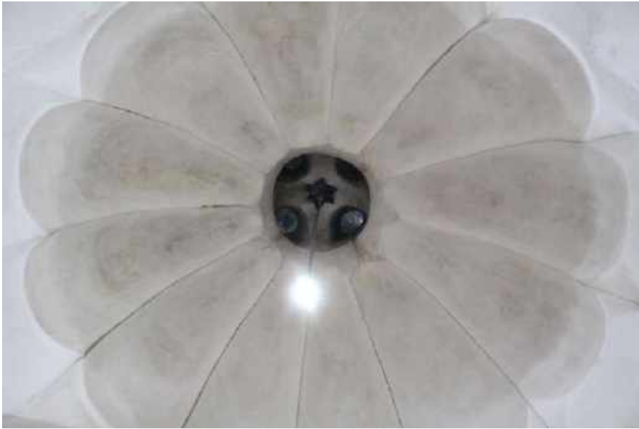
Resim 266: Vık-Vık Hamamı, Sıcaklık Bölümü, Üst Örtüsü
