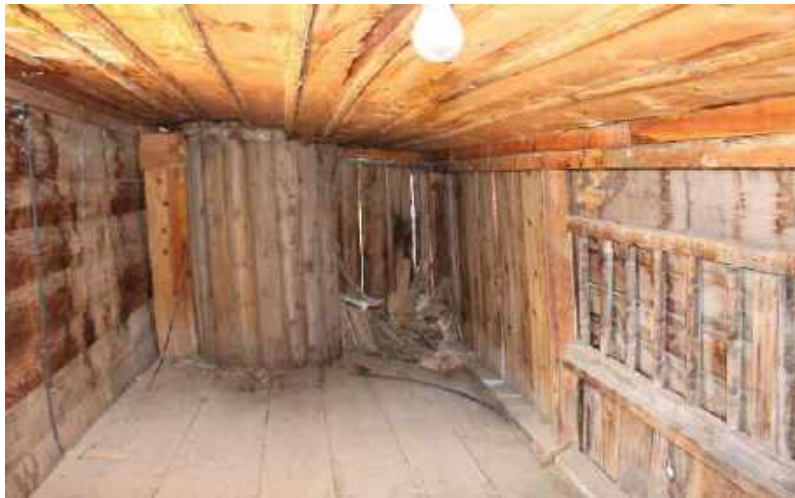
Resim 157:Kilkuyu Köyü Cami, Son Cemaat Yeri İkinci Kat Batı Duvarı (Eha Yapı Mimarlık-2019)
