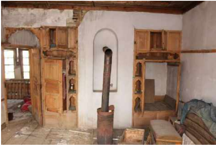
Resim 389: 141 Ada 1 Parseldeki Ev, İkinci Kat, Soldaki Oda, Batı Duvarı
