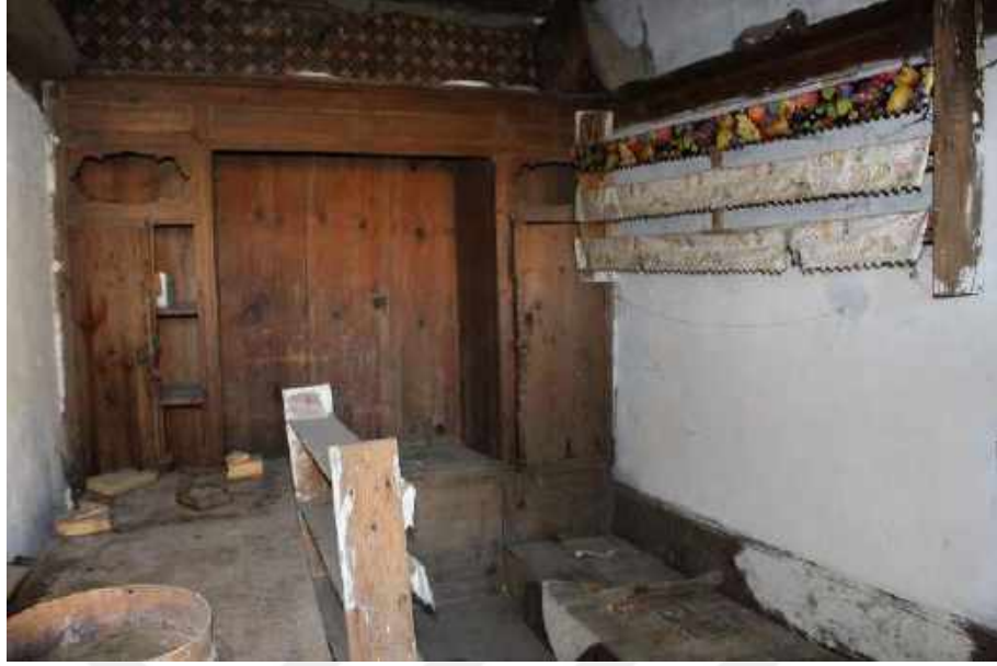
Resim 349: 177 Ada 2 Parseldeki Ev, Zemin Kat, Mutfak
