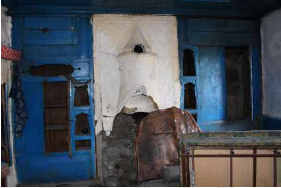
Resim 352: 177 Ada 2 Parseldeki Ev, Zemin Kat, Sağdaki Oda, Kuzey Duvarı
