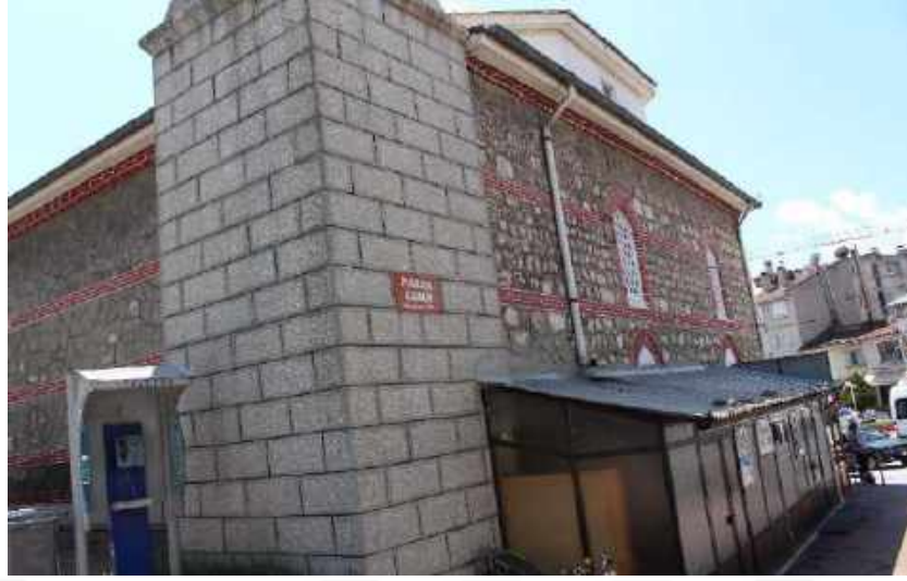
Resim 48: Pazar Cami, Batı Cephe
