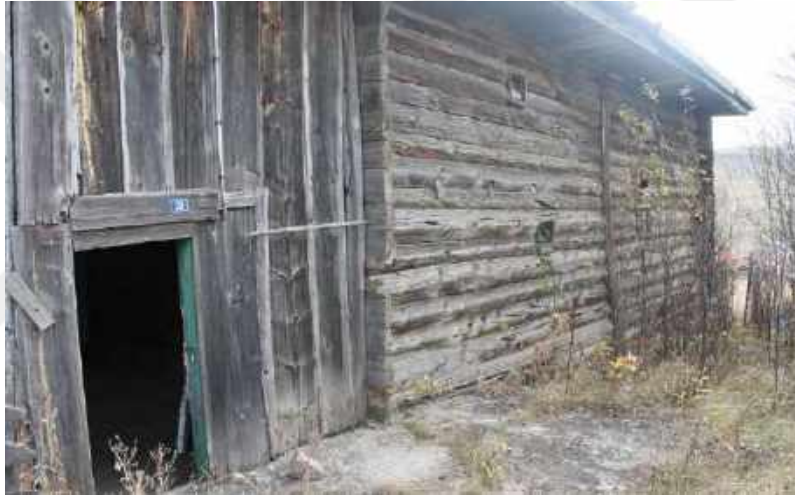
Resim 152: Kilkuyu Köyü Cami, Batı Cephe
