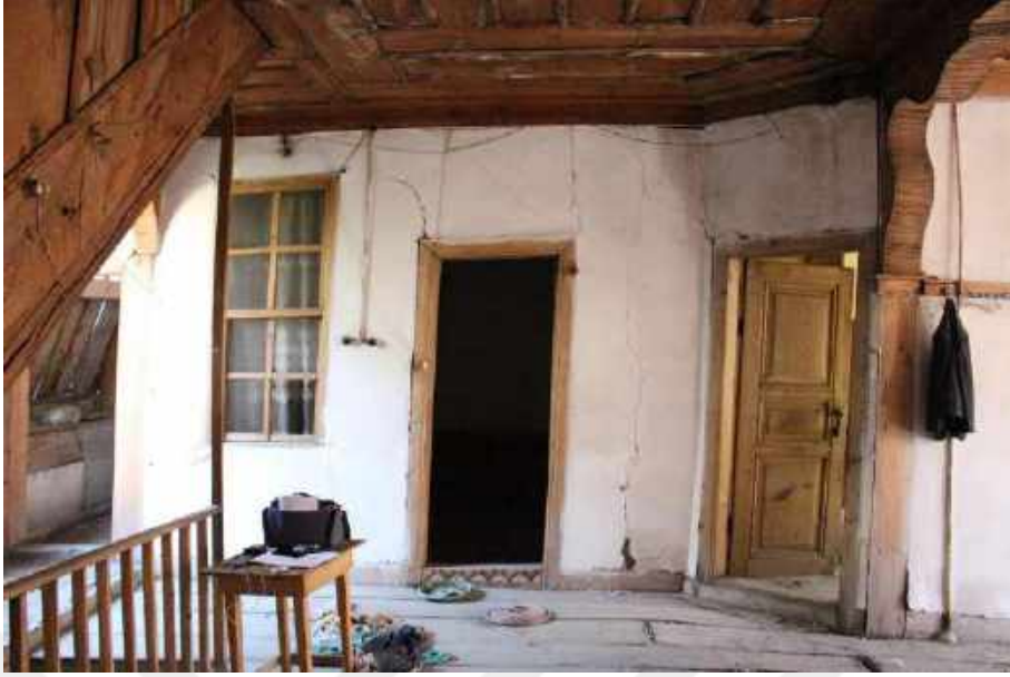
Resim 384: 141 Ada 1 Parseldeki Ev, Birinci Kat, Sofa, Kuzey Duvarı
