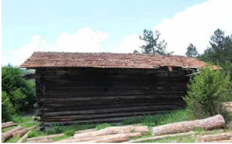
Resim 169: Gövrecik Köyü Cami, Doğu Cephe
