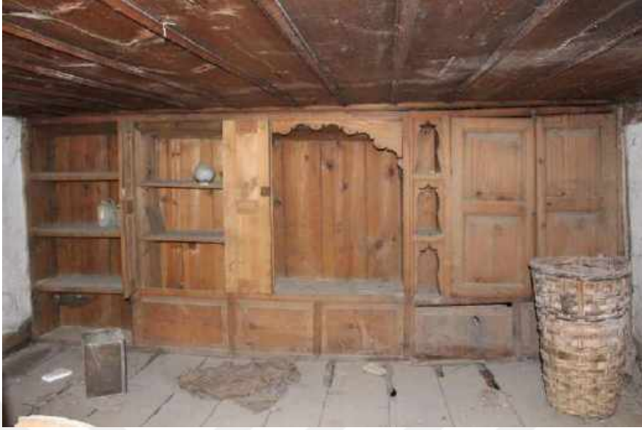
Resim 374: 141 Ada 1 Parseldeki Ev, Zemin Katta Bulunan Asma Kat, Batı Duvarı
