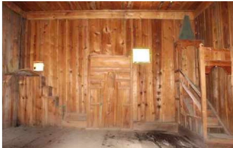
Resim 175: Gövrecik Köyü Cami, Harim, Güney Duvarı
