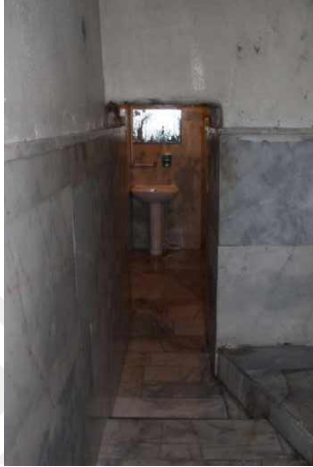
Resim 314: Tekke Hamamı, ılıklık Bölümü Helaya Giriş Açıklığı
