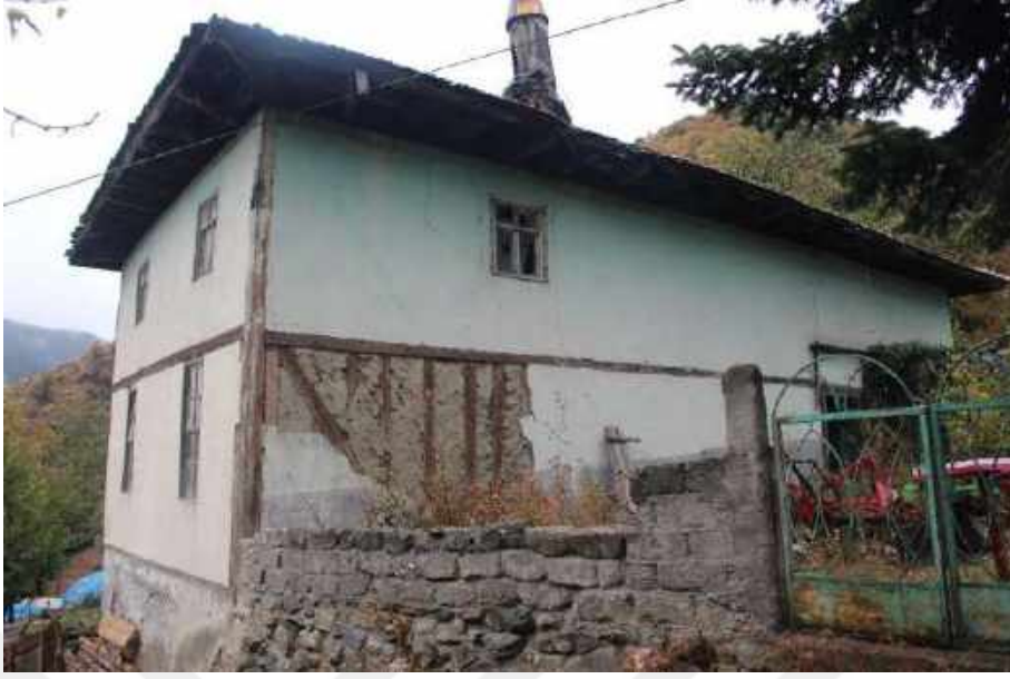
Resim 138: Ekincik Köyü Cami, Doğu Cephe
