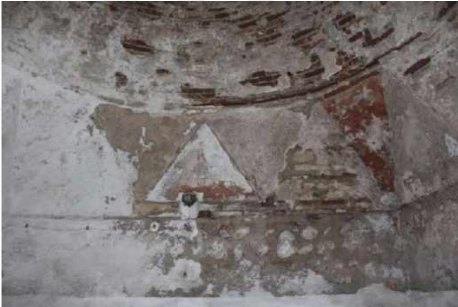
Resim 255: Şifa Hamamı, Halvet Hücreleri, Kubbe Geçiş Elemanı
