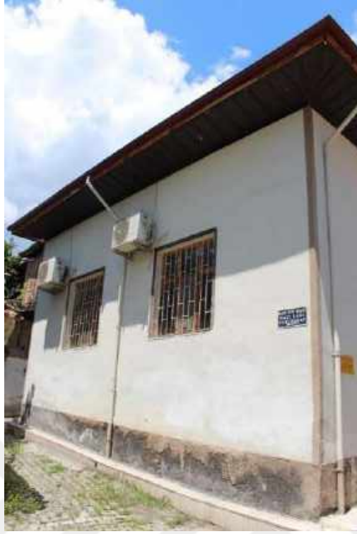
Resim 182: Hacı Baba Cami, Güney Cephe
