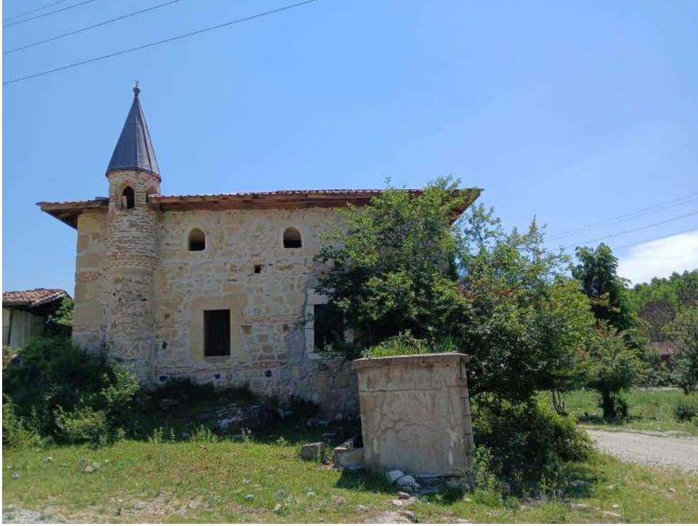
Fotoğraf 15: Mehranlı Köyü Camii Dış Görünümü 2 2024
