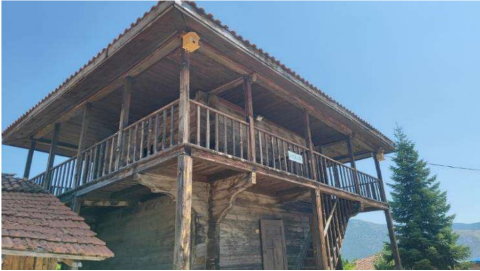
Fotoğraf 53:Bozatl Köyü Meydanındaki Ambar Dış Görünümü 2
