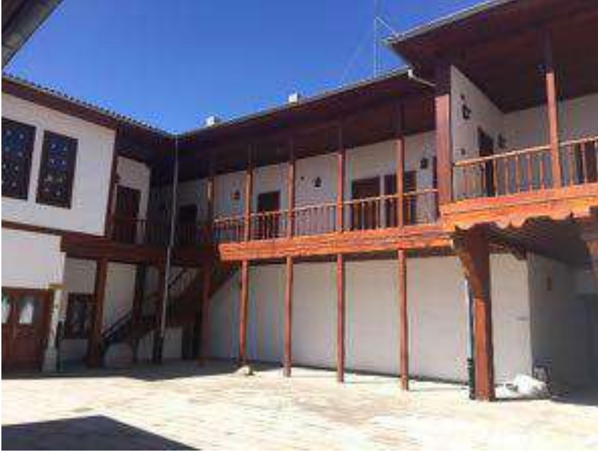
Fotoğraf 64: İmaret (Kasım Bey) Medresesi Onarım Sonrası İç Cephe (Filiz Karakuş'tan)
