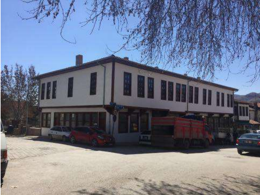
Fotoğraf 65: İmaret (Kasım Bey) Medresesi onarım sonrası dış cephe (Filiz Karakuş'tan)
