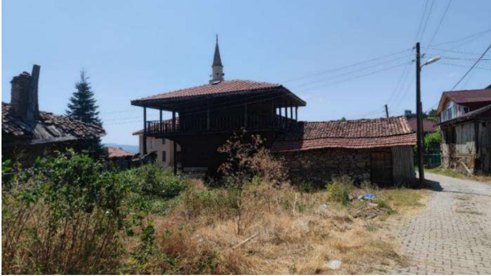
Fotoğraf 52:Bozatl Köyü Meydanındaki Ambar Dış Görünümü 1
