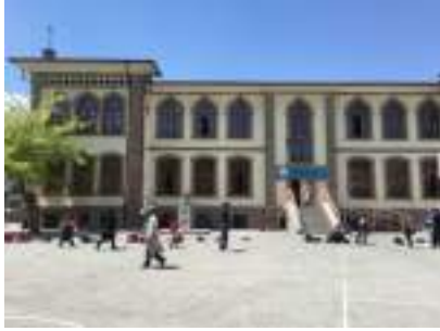
a. İsmetpaşa İlkokulu Doğu Cephesi
