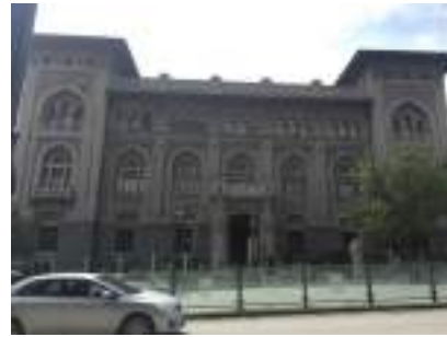
Resim 4.24. Ankara Ziraat Bankası İdare Binası (Mimarı Giulio Mongeri)
