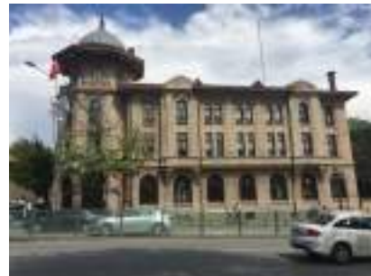
Resim 4.19. Tekel Başmüdürlük Binası (Mimarı Giulio Mongeri)
