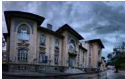
Resim 4.34. Maliye Vekaleti Binası (Maliye Bakanlığı) (Mimarı Yahya Ahmet-İrfan Bey) (Kaynak: http://www.fotografurk.com/ankara-valilik-binasi-p422571 (Son Erişim: 14.07.2016))
