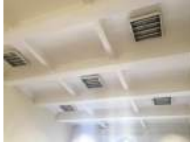
Resim 5.27. Sonradan Yapılan Betonarme Döşemeler
