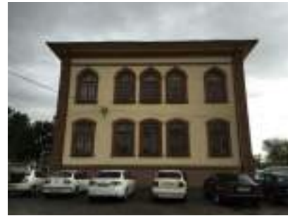
d. Hakimiyet-i Milliye İlkokulu Bugünkü Durumu
