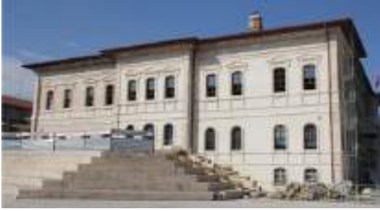
a. Sivas Lisesi Arka Cephe
