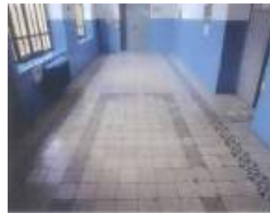
b. Yapının Özgün Döşeme Kaplaması (Kaynak: Kültür ve Tabiat Varlıklarını Koruma Kurulu Arşivi)
