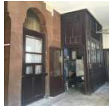
Resim 5.19. Ek Bina ile Arasına Yapılan Çay Ocağı
