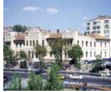
Resim 4.15. Hariciye Vekaleti Binasi (Mimarı Arif Hikmet Koyunoğlu)
