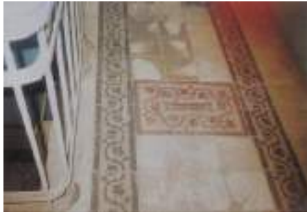
c. Özgün Döşeme Kaplaması (Kaynak: Eroğlu, 2001)
