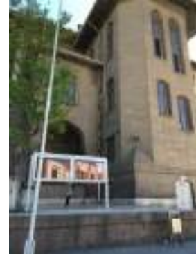
Resim 5.13. Dar-ül Muallimin Mektebi Kuzey-doğu Cephesi
