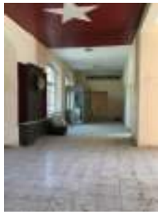
a. Zemin Kat Yenilenen Döşemeler
