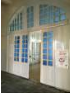
a. Dar-ül Muallimin Mektebi İç Mekan Kapıları
