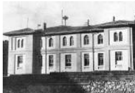
b. Eskişehir Atatürk Lisesi Yan Cephe (Kaynak: Sözen, 1984)
