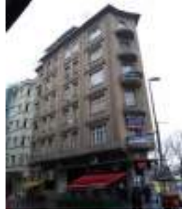
Resim 4.64. İstanbul Pertev Apartmanı (Mühendis Nihat Vedat) (Kaynak: http://www.panoramio.com/photo/31984871 (Son Erişim: 14.07.2016))
