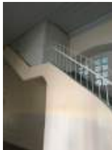
Resim 5.10. Çatı Arasına Çıkan Merdiven
