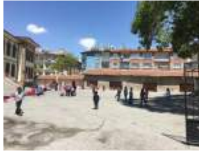
Resim 5.49. İsmetpaşa İlkokulu Ek Binaları
