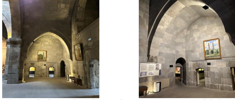
Şekil 3.62. Yakutiye Medresesi Eyvandan Görünüm- Yazar Arşivinden -2024
