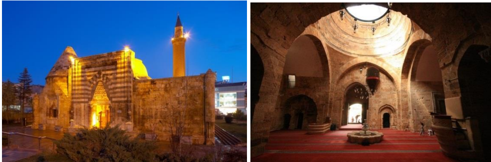
Şekil 2.15. Kırşehir Cacabey Medresesi İşlevlendirme Sonrası Dış Ve İç Mekan Görünümü (URL-9) Günümüzde kütüphane olarak hizmet veren Şemsi Paşa Medresesi yeni işlevine uyum sağlamıştır. Kazandığı yeni işlev, eğitim yapısının kimliğiyle çelişmemiş,
