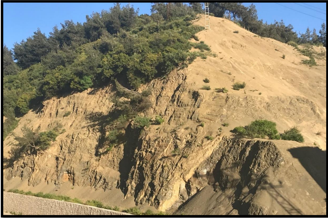
Şekil 27: Belen Geçidi'nde Yer Alan Yamaç Döküntüsüne Ait Bir Görünüm.
