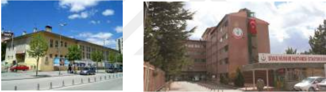
Şekil 4.33. İstasyon Caddesi'nin lojmanlar ve Pünzürük deresi arasında kalan bölgesinde kapalı spor salonu ve hastane binası (Önemlibiçak arşivi, 2018; yazar arşivi, 2018).
