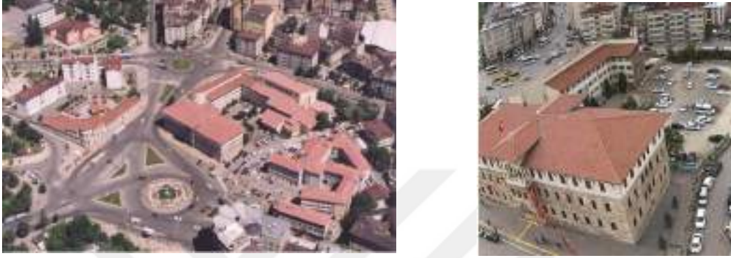
Şekil 5.61. Sivas Hükümet Konağı (Sivas Belediyesi, 2019).
