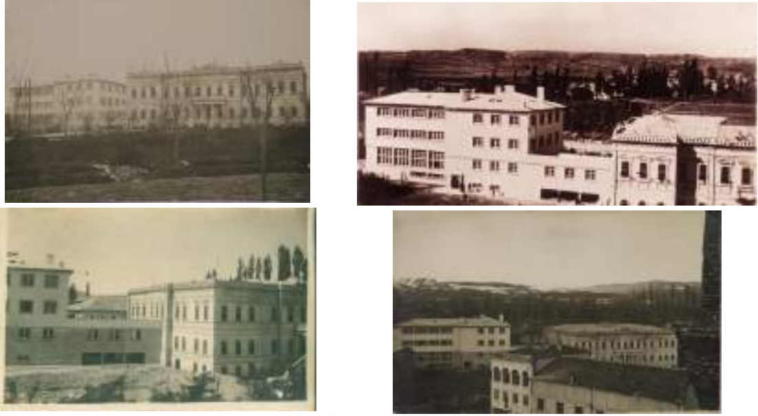
Şekil 4.38. Sivas Lisesi pansiyon binası (sivasresimleri, 2018).
