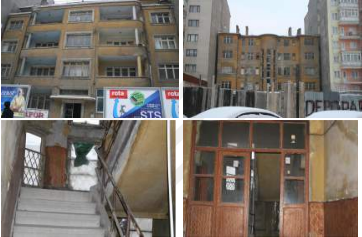
Şekil 4.67. Sivas'ta ilk modern apartman: Emek Apartmanı (Sivas KTVKK).
