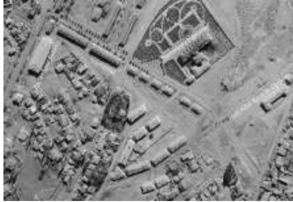
Şekil 5.3. 1959'da demiryolu lojmanları ve demiryolu hastanesi (birzamanlarsivas, 2018).
