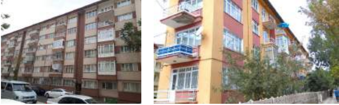
Şekil 5.58. Halil Rıfat Paşa Caddesi'nde Güvenevler ve Akdeğirmen Mahallesi'nde İşikevler (yazar arşivi, 2018).
