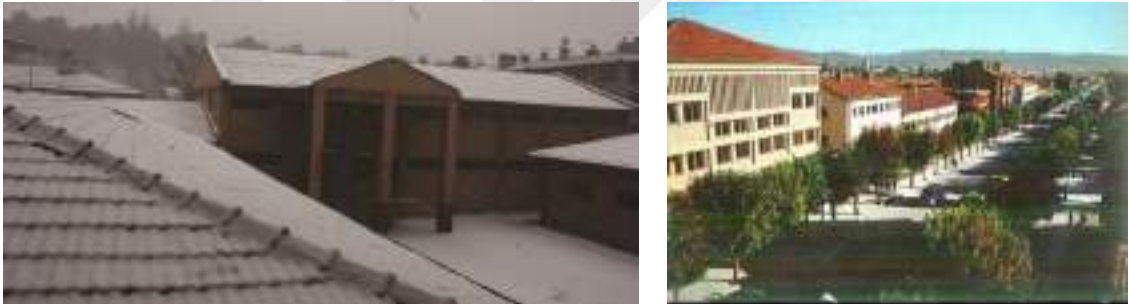
Şekil 4.46. Tekel binasının depo kısmını oluşturan kolonadlı giriş nişi ve Esen Sineması'nın ön yüzü (Sivas KTVKK; Önemlibıçak arşivi, 2018).
