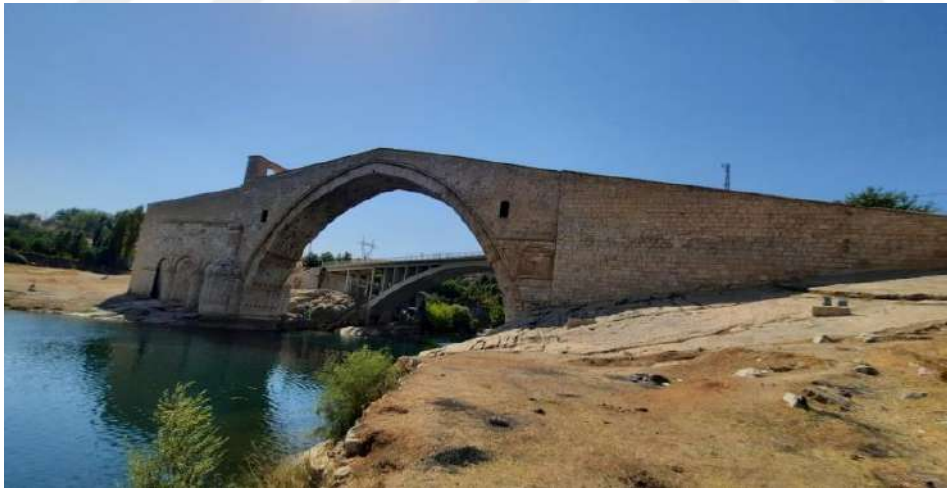
Fotoğraf 54: Malabadi Köprüsü Genel Görünüm.
