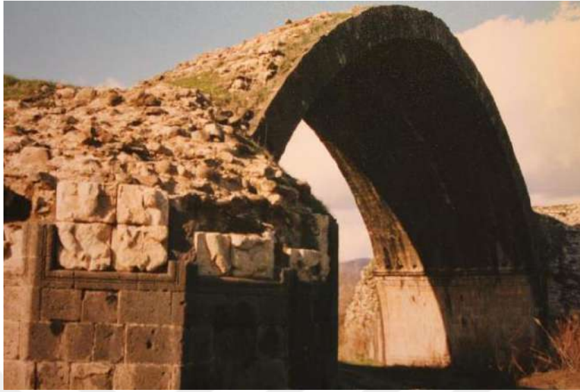
Fotoğraf 65: Cizre (Yafes) Köprüsü Genel Görünüm ( http://wikiapia.org/29940596/Ain-Diwar-Roman-Bridge#/photo/3859519 ).
