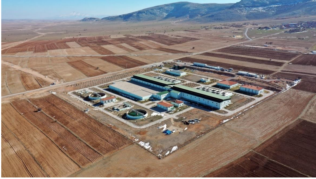
Şekil 2.5. KOSKİ Seçme Arıtma Tesisi (KOSKİ, 2024)
