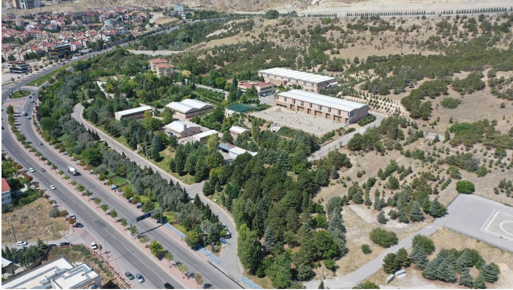
Şekil 2.3. Akyokuş İçme Suyu Arıtma Tesisleri (KOSKİ, 2024)
