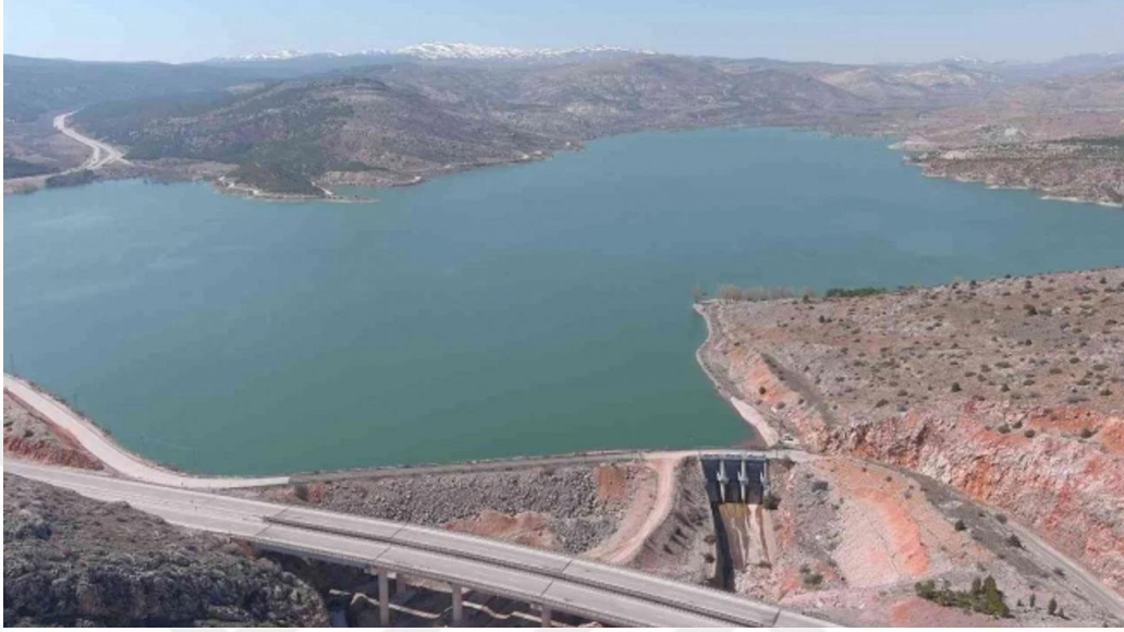
Şekil 2.2. Altınapa Barajı (KOSKİ, 2024)
