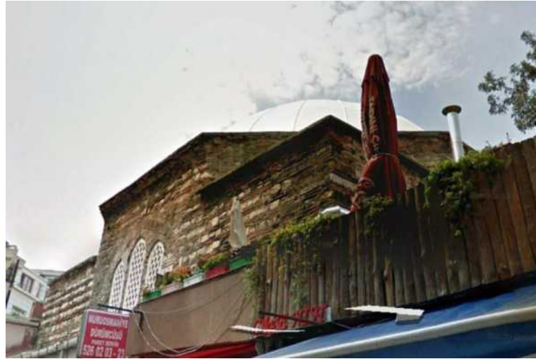
Şekil 4.52. Çağaloğlu Hamamı güneydoğu cephesi (Google Earth, 2021)
