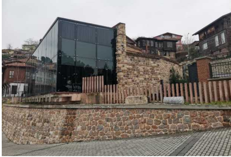
Şekil 4.4. Kocaeli Süleyman Paşa Hamamı doğu cephesi (Yazara ait fotoğraf arşivi, 2021)
