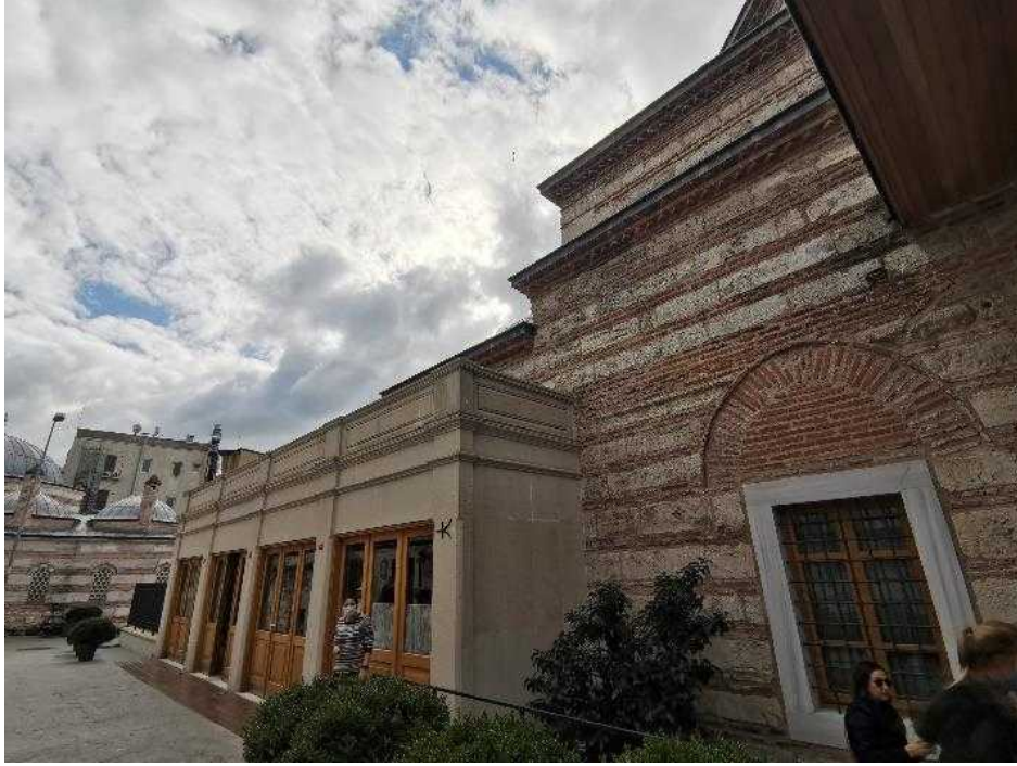
Şekil 4.12. Kılıçlı Paşa Hamamı giriş cephesi ve yeni eki (Yazara ait fotoğraf arşivi, 2020)
