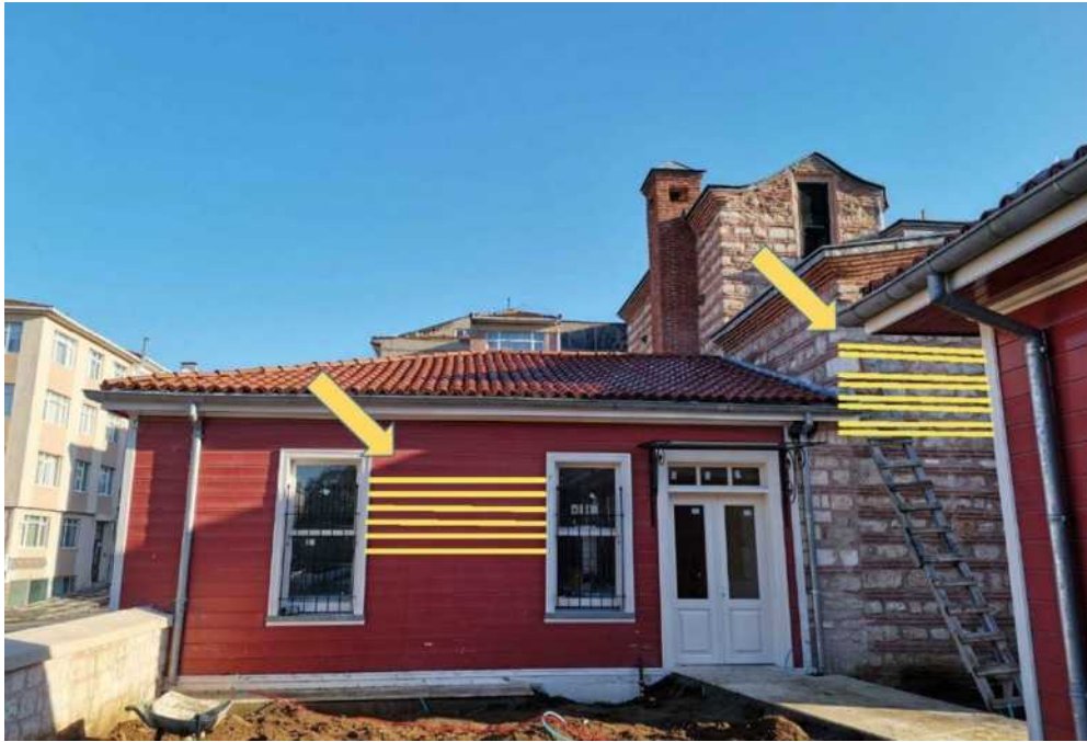
Şekil 4.39. Selimiye Hamamı güneybatı cephesi (Yazara ait fotoğraf arşivi, 2020)
