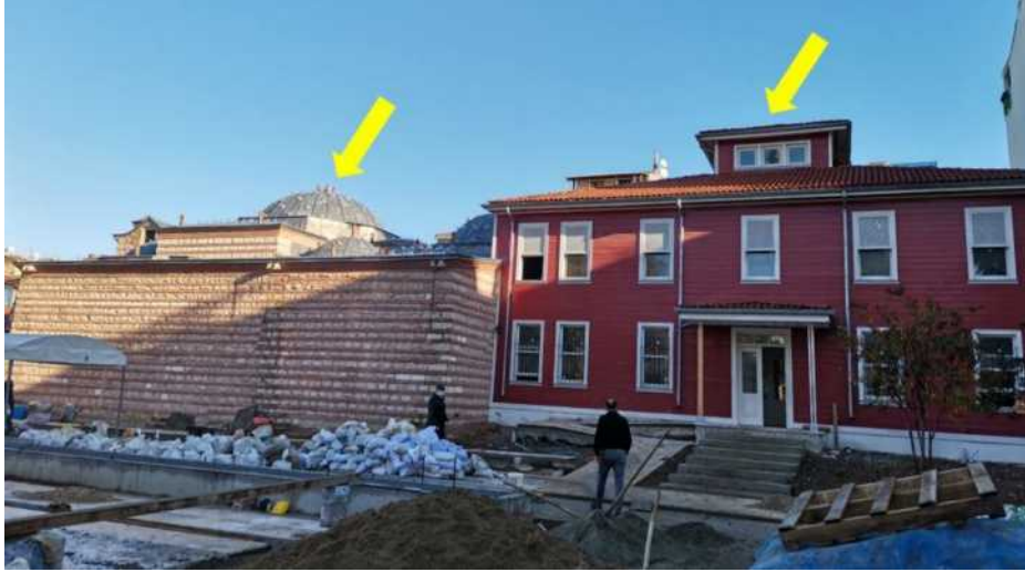
Şekil 4.36. Selimiye Hamamı güneybatı cephesi (Yazara ait fotoğraf arşivi, 2020)
