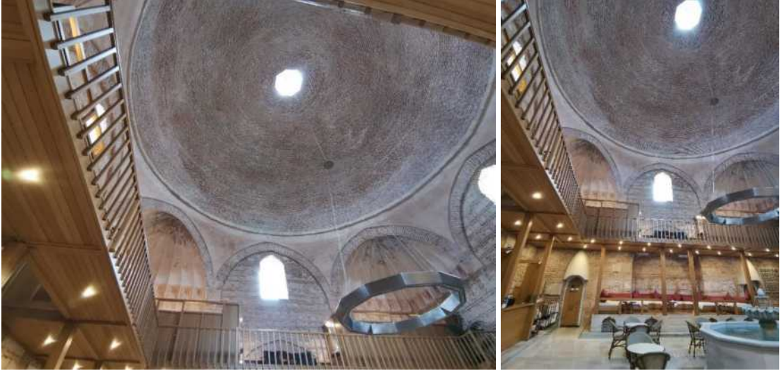
Şekil 4.11. Kılıçlı Paşa Hamamı soyunmalık bölümü ve kubbe çatı örtüsü (Yazara ait fotoğraf arşivi, 2020)
