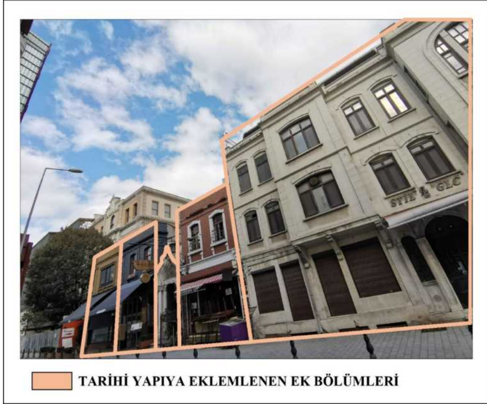
Şekil 4.49. Çagaloglu Hamamı Ön Cephesine ait yeni ekleri (Yazara ait fotoğraf arşivi, 2020)
