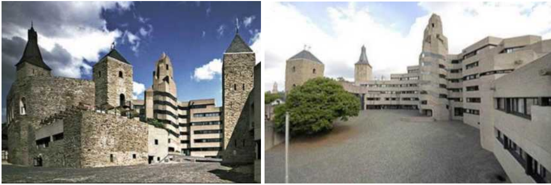
Şekil 2.16. Bensberg Tarihi Belediye Binası ve eki (Kılıç, 2015 a, s.85)
