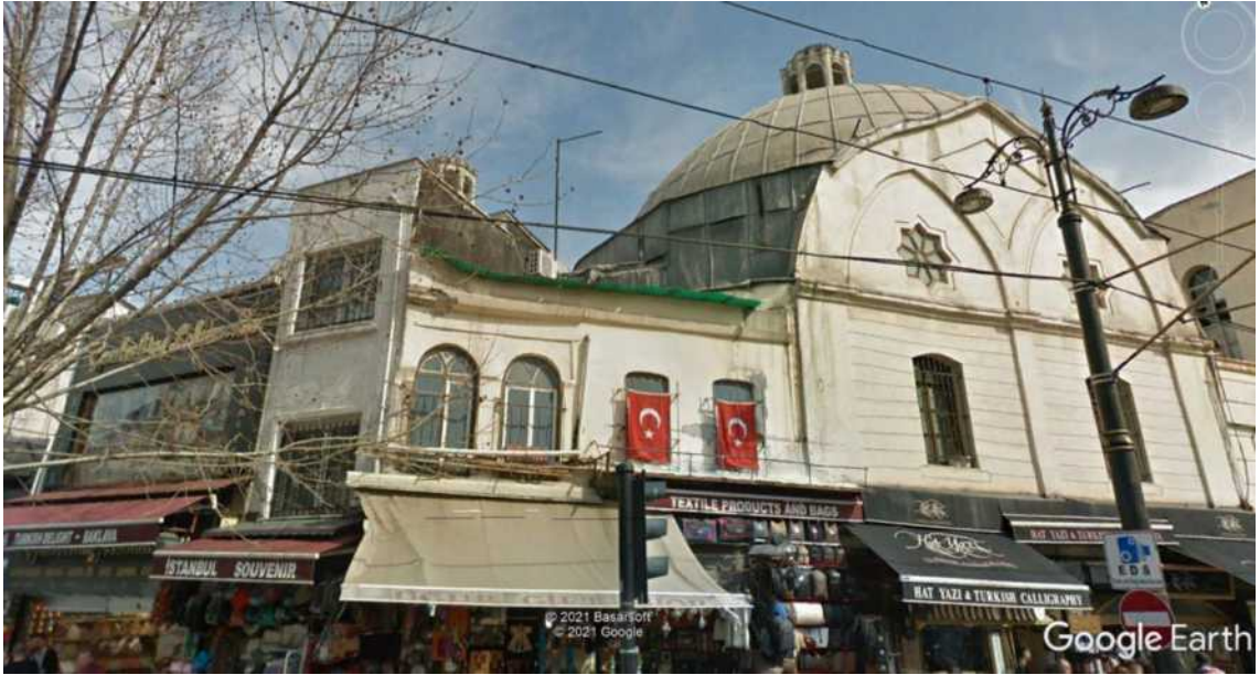
Şekil 4.45. Çemberlitaş Hamamı güney cephesi (Google earth'ten alınmıştır , 2021)
