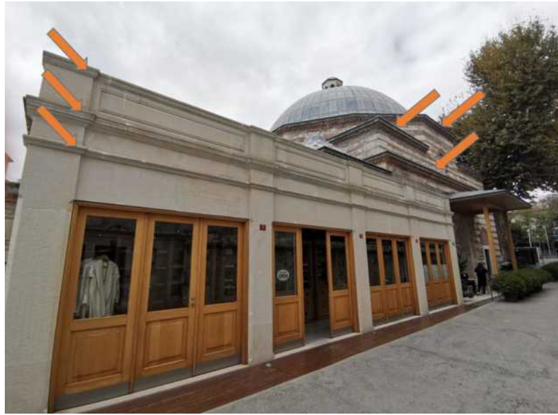
Şekil 4.16. Kılıç Ali Paşa Hamamı yatay yönlü kirpi saçaklar ve yeni ekine ait yatay yönlü silmeler (Yazara ait fotoğraf arşivi, 2020)
