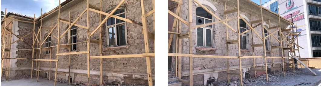
Şekil 3.12. Güney (sol) ve kuzey (sağ) bölümlerin duvar örgüsü farkı.
