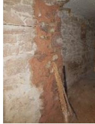
b. Hemşire Lojmanı restorasyonunda derz uygulaması.
