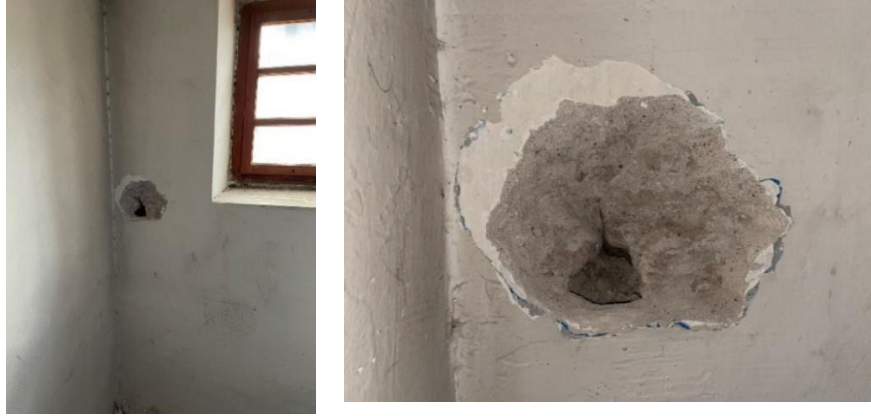
Şekil 3.42. HMO H-04 örneğinin alındığı yüzey.
