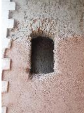
b. Hemşire Lojmanı restorasyonu
