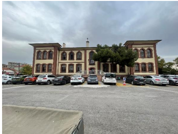
Şekil 3.34. Okulun güney cephesi.
