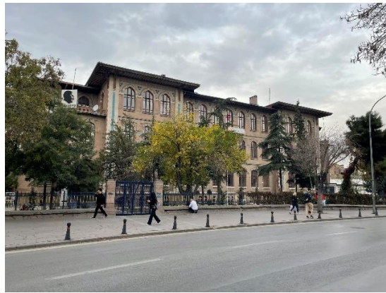
Şekil 3.53. Gazi Lisesi doğu cephesi.
