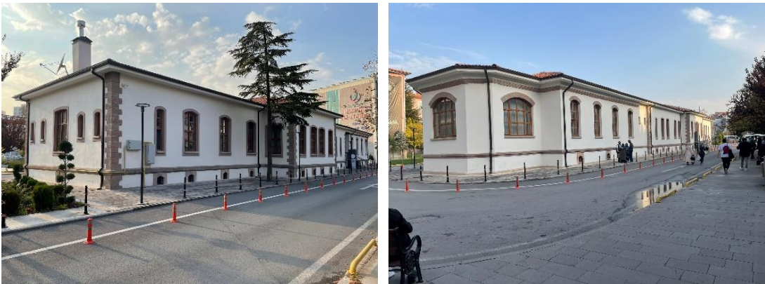
Şekil 3.8. Restorasyon sonrası Hemşire Lojmanı Binası.
