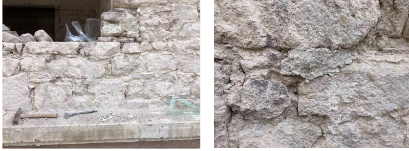
Şekil 3.17. HB H-04 örneğinin alındığı yüzey.
