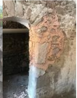
c. Horasan harcı örgü harcı örneği.
