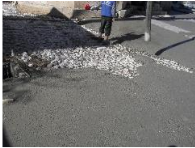
Şekil 2.4. Çimento-kireç karışımı tesfiye harcı örneği.
