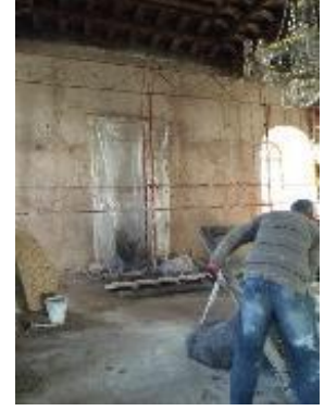
c. Yukarıçiğil Merkez Camii restorasyonu
