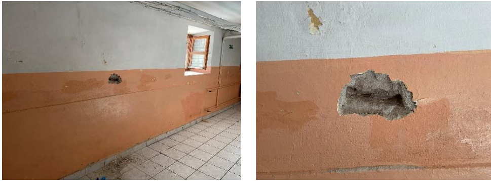
Şekil 3.49. İO H-01 örneğinin alındığı yüzey.
