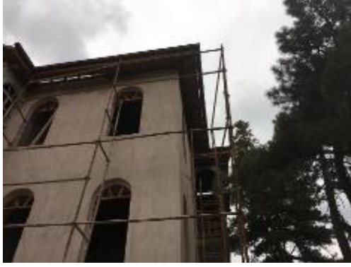
a. Kalfaoğlu Konağı restorasyonu
