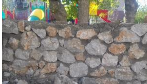
b. Çimento-Kireç karışımı örgü harcı örneği.
