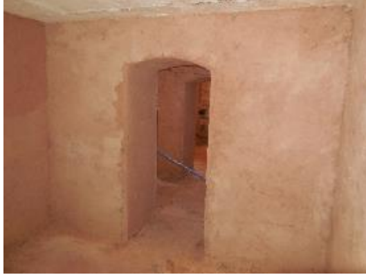
a. Hemşire Lojmanı restorasyonunda sıva uygulaması.
