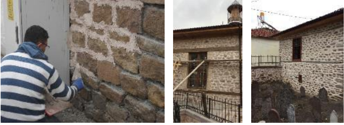
Şekil 2.7. Sille Subaşı Camii'nde Horasan harcı derz örnekleri.
