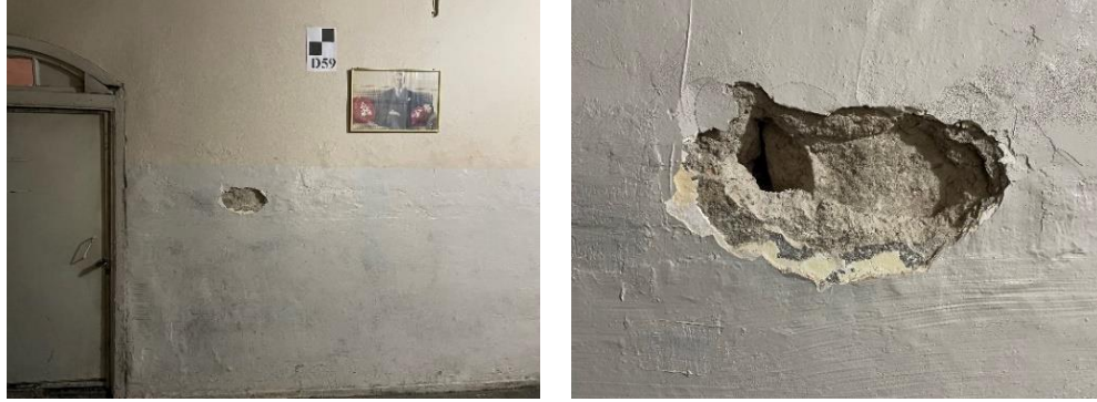
Şekil 3.63. GL H-04 örneğinin alındığı yüzey.
