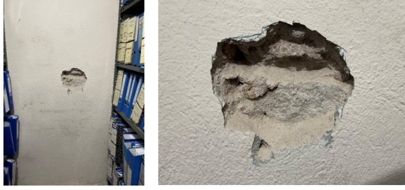
Şekil 3.40. HMO H-02 örneğinin alındığı yüzey.
