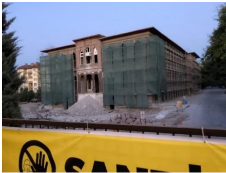
a. Restorasyon uygulaması sırasında ek bölüm kaldırıldıktan sonra özgün batı cephesi. (2022)
