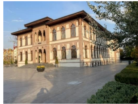
b. Restorasyon sonrasında batı cephe.
