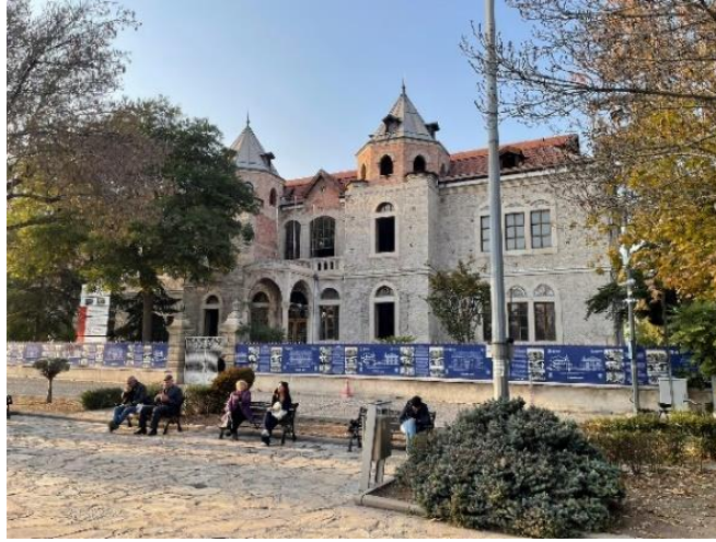
Şekil 3.65. Restorasyon uygulaması sırasında Sanayi Mektebi güney cephesi.
