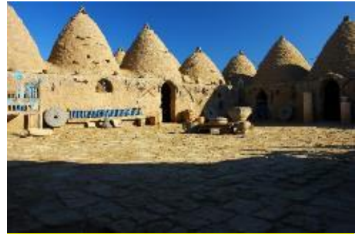
b. Kerpiç bağlayıcı ve blokların yakın döneme kadar yoğun olarak kullanıldığı Güneydoğu Anadolu Bölgesi’nden Harran Evleri.
