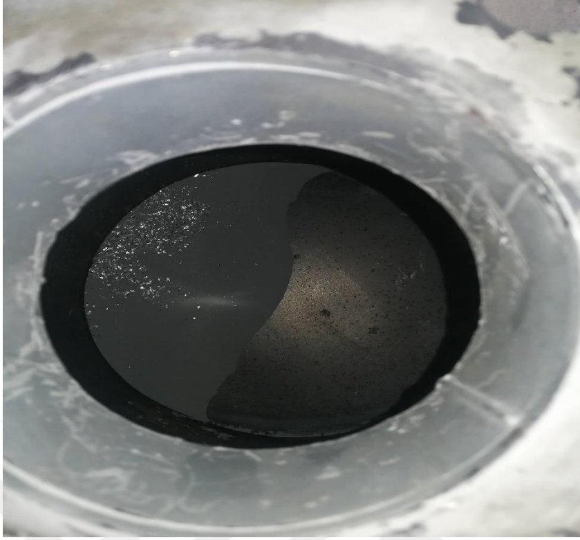
Resim 4.7. Kule toz toplama ünitesi
