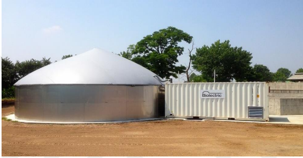
Şekil 3.8.: Çiftlik Tipi Biyogaz Tesisi
