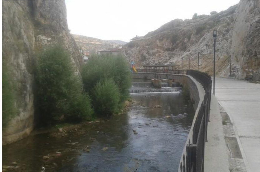
Şekil 4.19. Tesis mansabında yapılan ve taşkın riskini artıran regülatör yapısına ait görüntü
