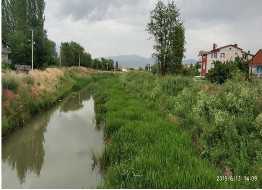
Şekil 4.31. Konya İli Beyşehir İlçesi Aşağı Esence taşkın koruma tesisinde kanal içerisinde taşkına sebep olabilecek kadar biriken rüsubata ait görüntü
