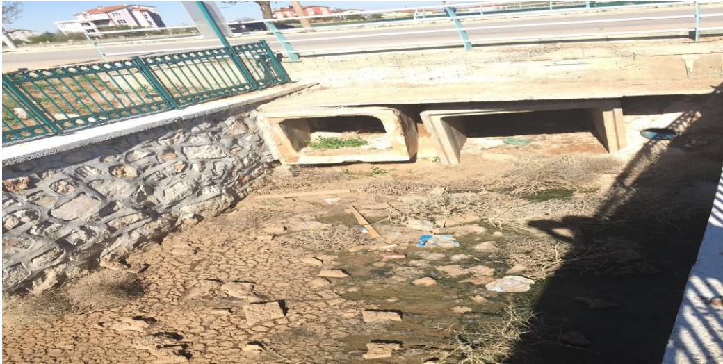
Şekil 4.1. İlgili belediye tarafından yol geçişine yapılan dar kesitli menfez-1 görüntüsü
