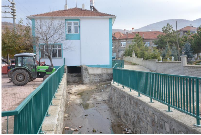
Şekil 4.25. Bostandere Mahallesi taşkın tesisi üzerine yapılan müdahaleye ait görüntü
