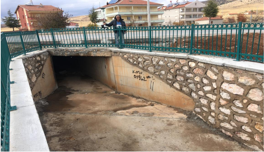
Şekil 4.2 İlgili belediye tarafından yol geçişine yapılan dar kesitli menfez-2 görüntüsü
