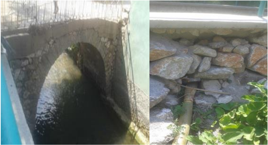
Şekil 4.20. Dereköy Taşkın Tesisi üzerine yapılan yetersiz kesitli kemer köprüsü ve vatandaş sulama müdahalelerine ait görüntüler
