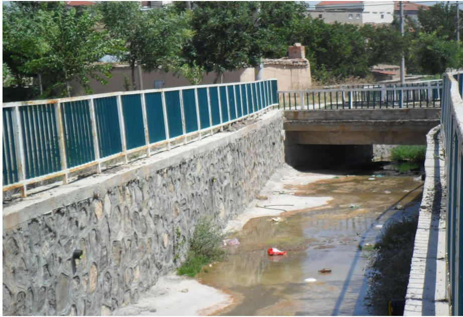
Şekil 4.28. Konya İli Kulu İlçesi Bulduk Kasabası taşkın koruma tesisinde taşkına sebep olabilecek kadar kesiti yetersiz olan yol geçişine ait görüntü
