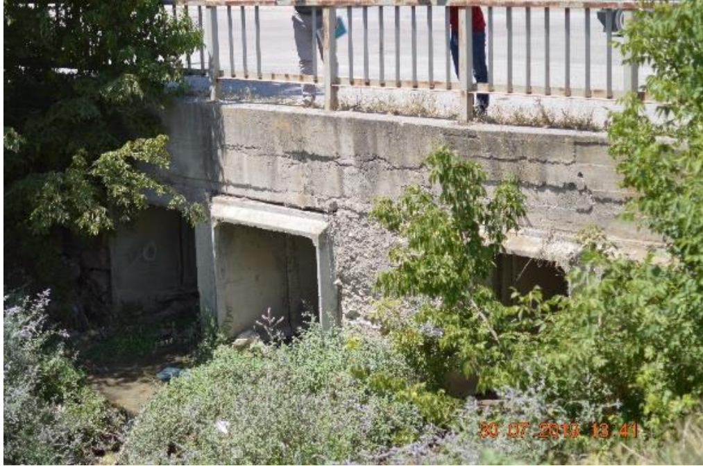
řekil 4.10. Konya İli Kulu İlçesi Kozanlı Mahallesi giriřinde bulunan ve ilgili belediye veya diđer kurumlar tarafından yapılan yol geçiři altı yetersiz kesit kutu menfezlere ait görüntü
