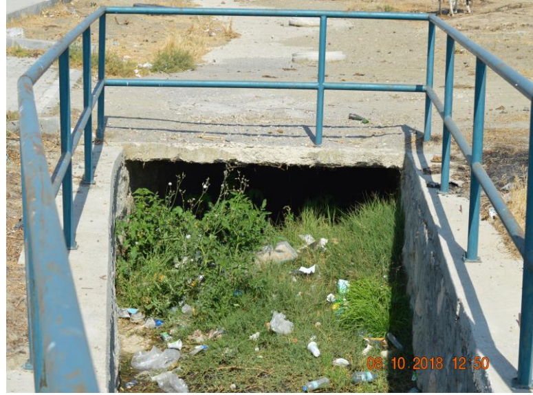
Şekil 4.27. Konya İli Kulu İlçesi Zincirlikuyu Mahallesi taşkın koruma tesisi kanal içerisinde taşkına sebep olabilecek kadar biriken rusubat vb.ait görüntü
