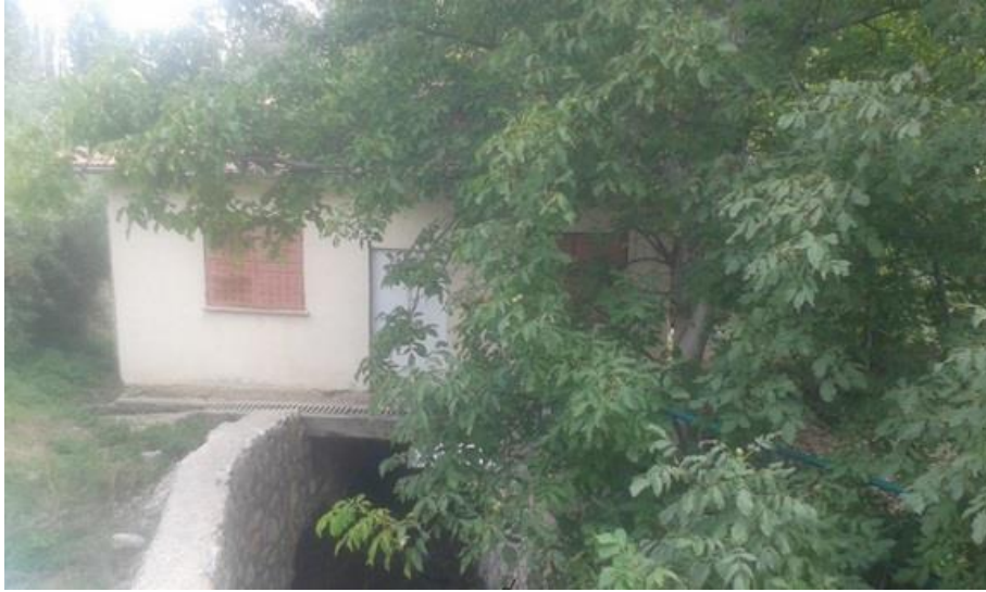
Şekil 4.21. Harmanpınarı taşkın tesisi üzerine yapılan vatandaş müdahalesine ait görüntü
