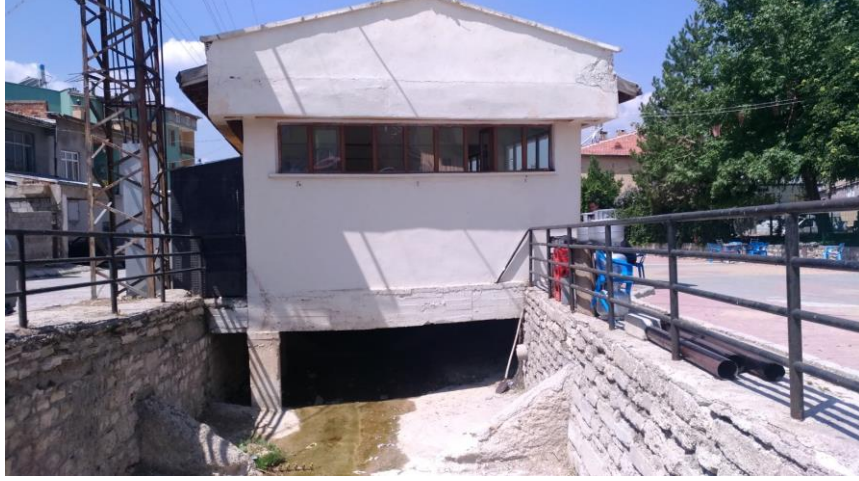
Şekil 4.24. Başarakavak Mahallesi taşkın tesisi üzerine yapılan müdahaleye ait görüntü
