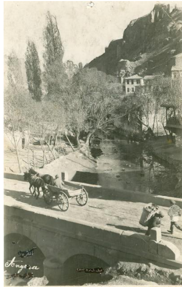
Fotoğraf 3.10. Ankara Bend/Bent Deresi, Görsele Osmanlıca Yazılmış Debbağhane/ Tabakhane Köprüsü/ 1930 Tarihli Görsele 213
