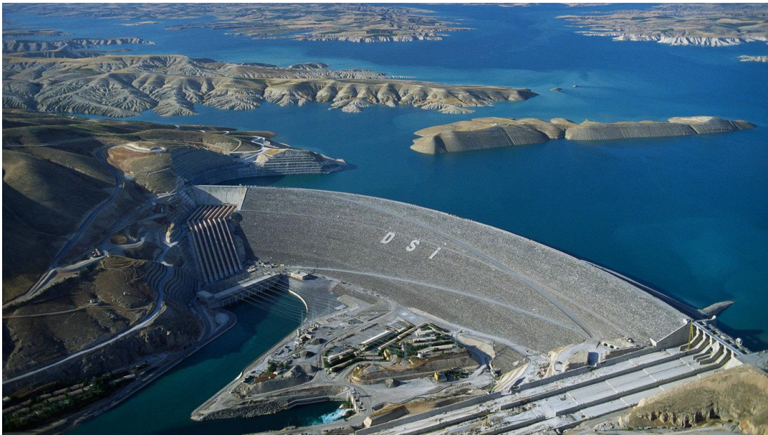
Fotoğraf 3.86. Atatürk Barajı ve Hidroelektrik Santrali Görşeli 542
