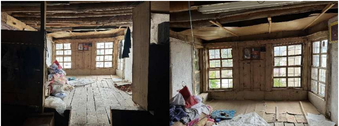
Şekil 4.37. İki modül genişliğinde ve dört modül yüksekliğindeki giyotin pencereli tahtaboş mekânı
