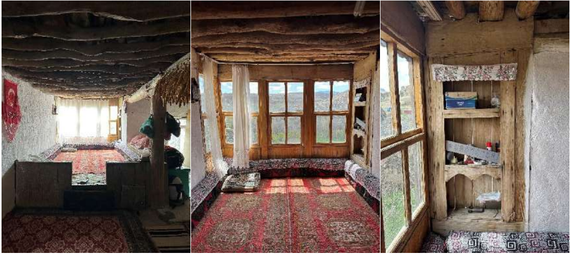
Şekil 4.39. İki modül genişliğinde ve iki modül yüksekliğindeki giyotin pencere, ağzı açık da bulunan tahtaboş mekânı
