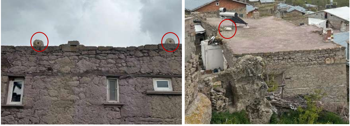
Şekil 4.43. Toprak dam ve kırmızı alan içerisinde loğ taşları
