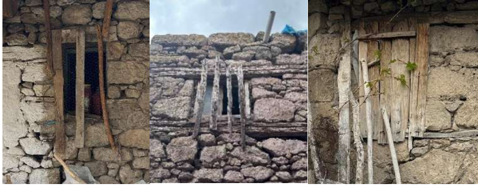
Şekil 4.51. Ahşap ızgaralı pencereler
