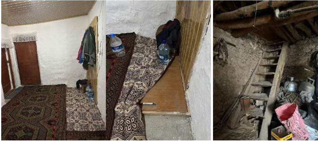
Şekil 4.22. Solda ve ortada sofada bulunan kepenlik, sağda hayata (ahır ve samanlık) bağlayan ahşap merdiven
