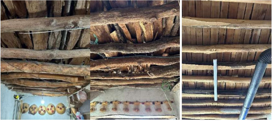
Şekil 4.41. Solda ve ortada ahşap kirişli kaplamasız pardılı tavan, sağda ahşap kirişli kaplamalı tavan
