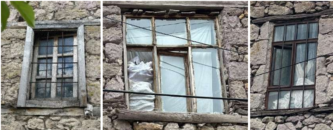
Şekil 4.48. Solda iki modül genişliğinde ve üç modül yüksekliğindeki kanatlı pencere, ortada üç modül genişliğinde ve üç modül yüksekliğindeki kanatlı pencere, sağda metal doğramalı kanatlı pencere
