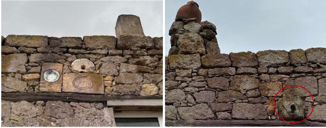
Şekil 4.32. Solda loğ taşı, sağda kırmızı alan içerisinde gargoyle kullanımı
