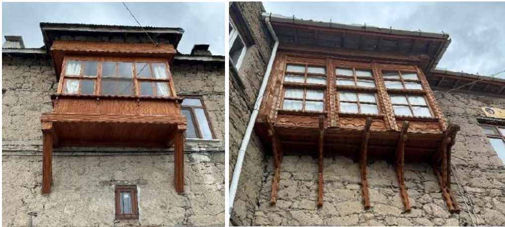
Şekil 4.34. Lambiri ile yapılan tahtaboşlar
