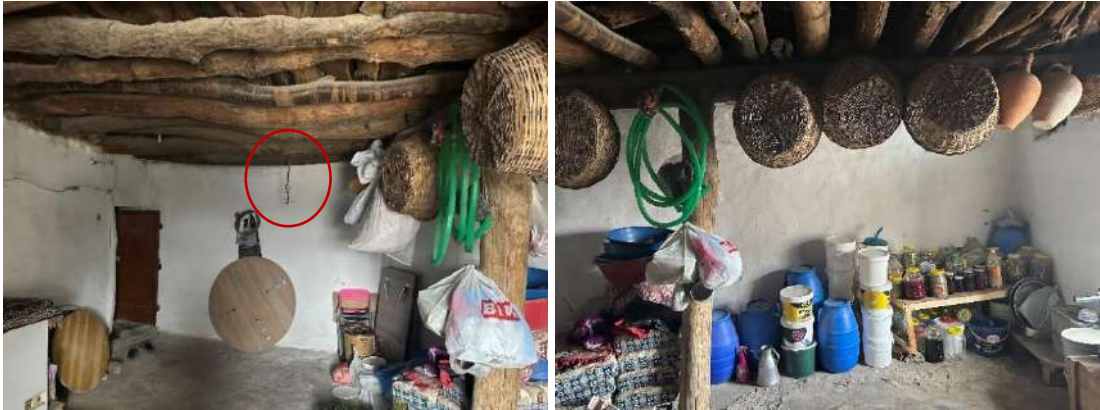
Şekil 4.6 Solda kırmızı alan içerisinde mulak, sağda kirişe asılan testiler ve sepetler
