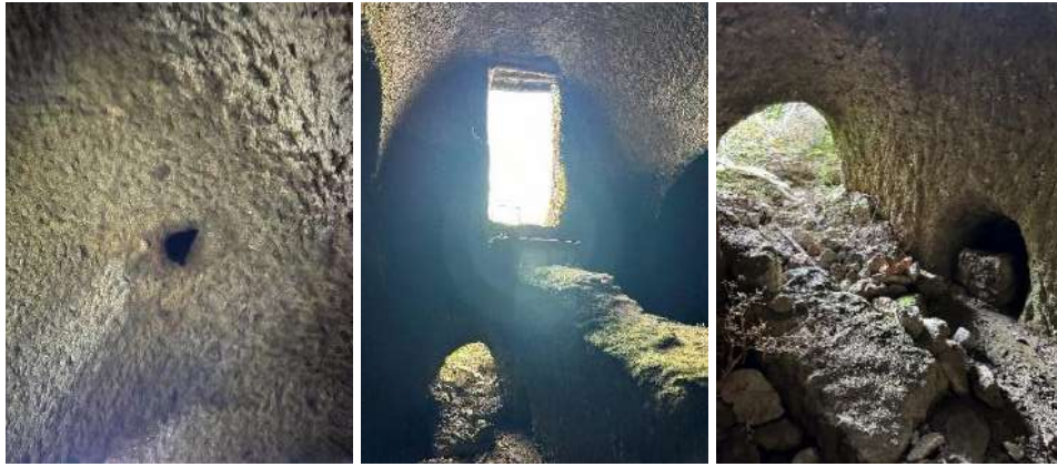
Şekil 4.68. Solda Katrini Sarnıcı su dolum deliği, sağda boşaltım ve temizlik kanalları
