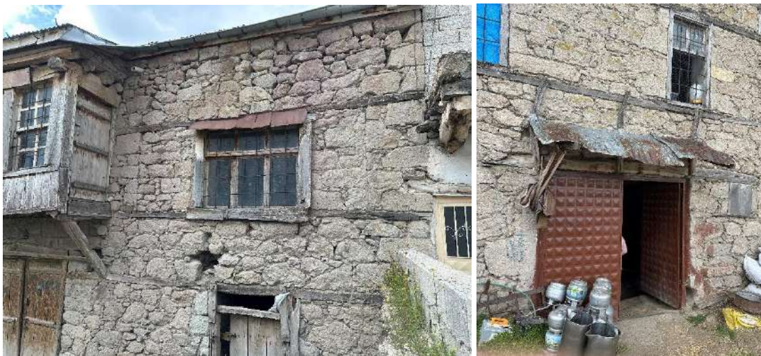
Şekil 4.53. Çinko saç levha gölge elemanları
