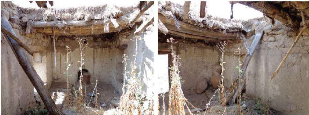
Şekil 4.104. İsmigilin odasında ocak nişi ve çağ/suluk sekisi (Bozkurt, 2016, s. 214)
