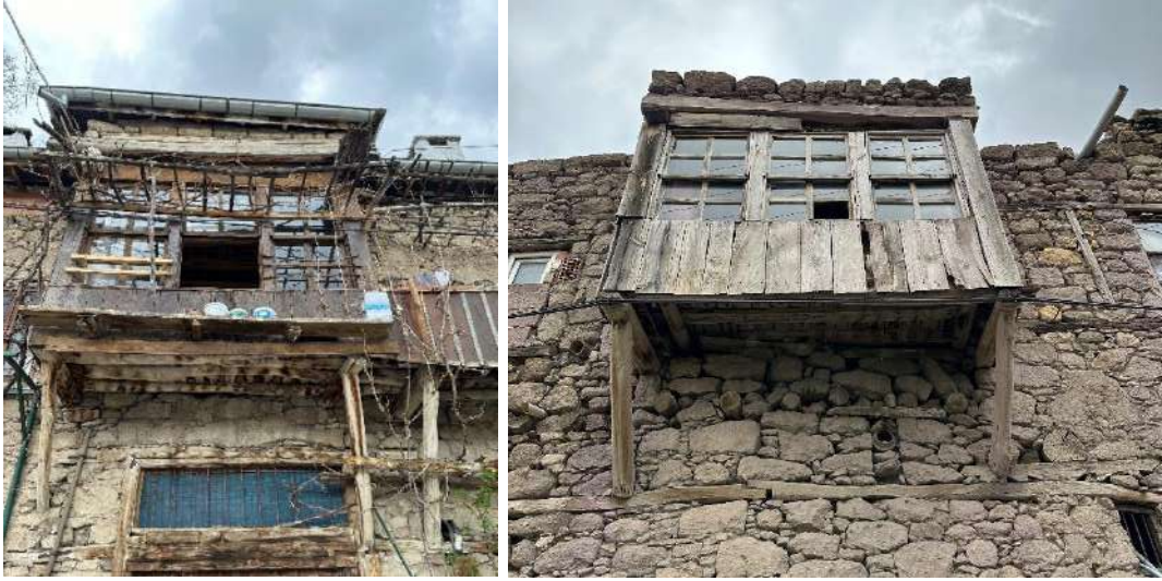
Şekil 4.35. Solda asma yaprak kaplı tahtaboş, sağda üç sıra pencereli sedir altı kaplamasız tahtaboş
