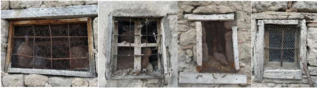
Şekil 4.50. Geçme demir parmaklıklılı ve tel örgülü pencereler
