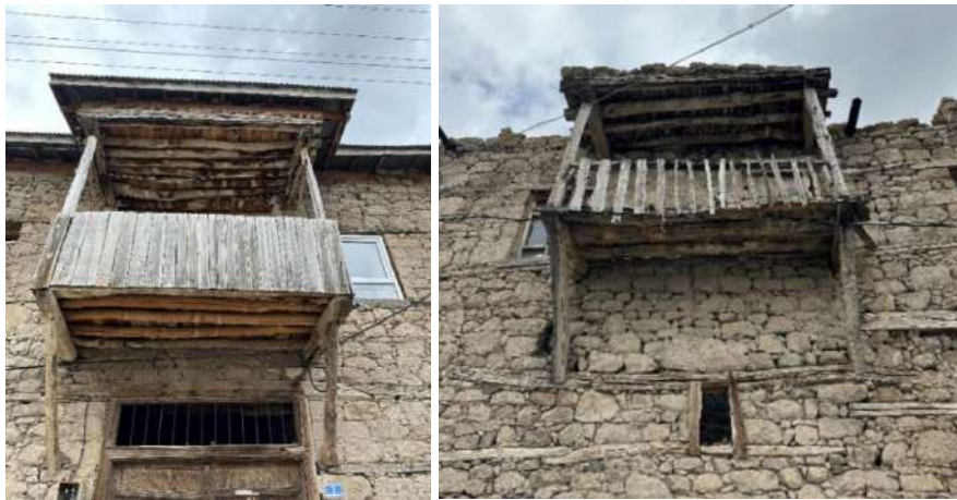
Şekil 4.40. Açık çıkmalar
