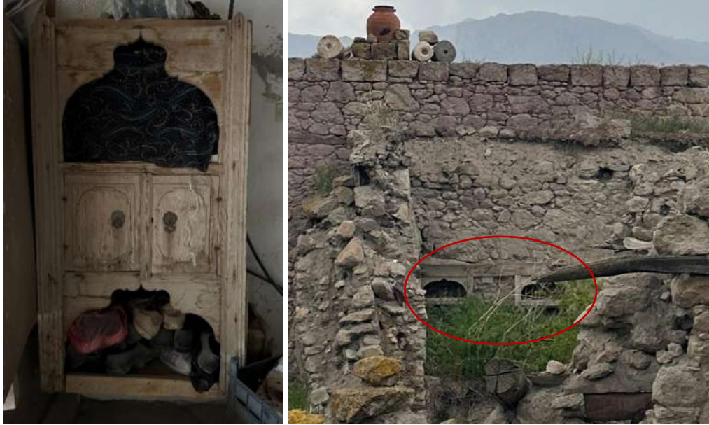
Şekil 4.7. Solda musandralı ve pabuçluklu dolap, sağda kırmızı alan içerisinde ağzı açık (açık dolapçık)
