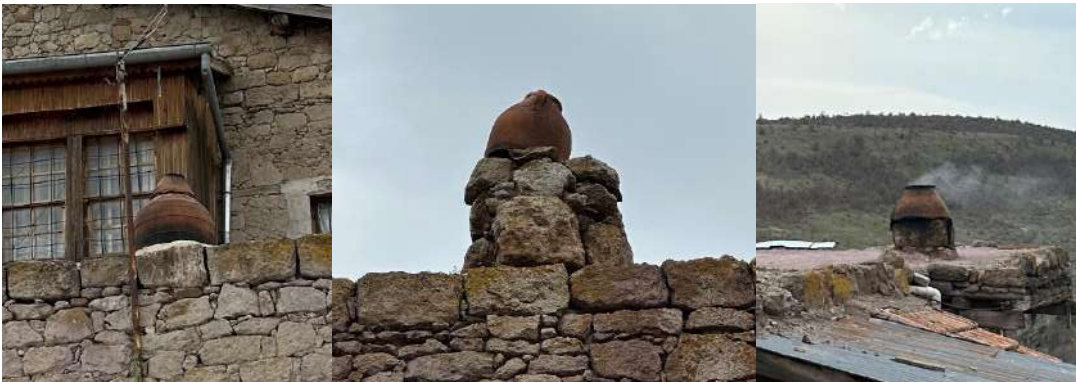
Şekil 4.57. Buhare/Buhari denilen altı delikli sırçalı küp baca
