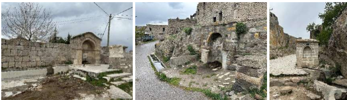
Şekil 4.64. Solda su kemerli Başpınar Çeşmesi, ortada Hatip Pınarı Çeşmesi, sağda Sümbül Çeşmesi
