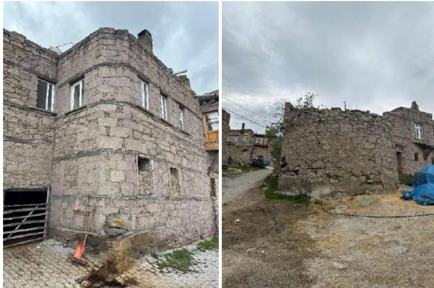
Şekil 4.18. Kilistra’da solda pahlı duvar, sağda eğrisel duvar
