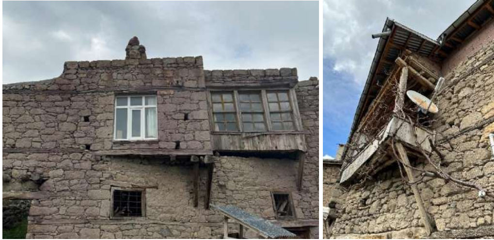
Şekil 4.33. Solda gönye planlı testere şeklinde ahşap ve taş çıkma, sağda gönye planlı ahşap açık çıkma
