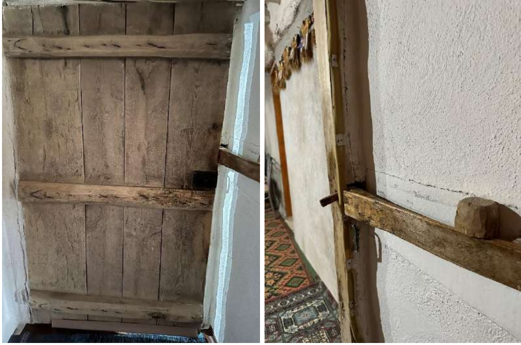
Şekil 4.56. İç kapı ve özgün kilit sistemi
