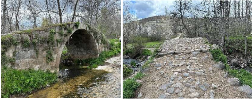
Şekil 4.63. Ciğer Yeri mevkinde bulunan yarım daire kemerli tek gözlü köprü
