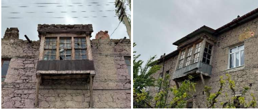
Şekil 4.38. Çinko saç levha kaplı tahtaboşlar
