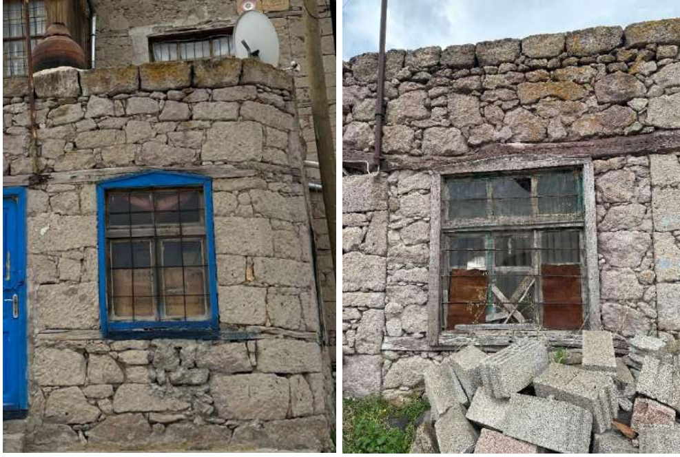
Şekil 4.49. Solda üçgen alınlıklı iki modül genişliğinde ve üç modül yüksekliğindeki kanatlı pencere, sağda üçgen alınlıklı üç modül genişliğinde ve üç modül yüksekliğindeki giyotin pencere
