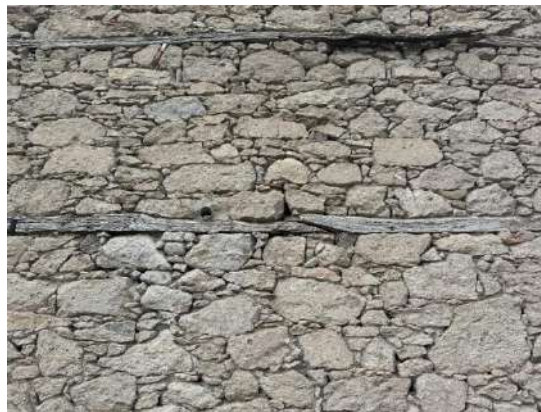
Şekil 4.30. Ahşap hatıllı taş duvarda mısır denilen küçük taşlar ve testi kırıkları
