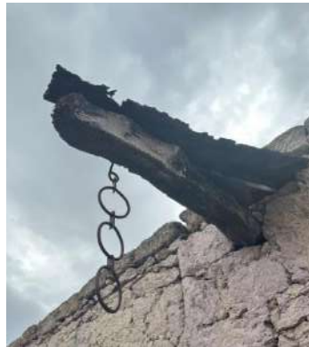
Şekil 4.45. Zincir detaylı ahşap çörten
