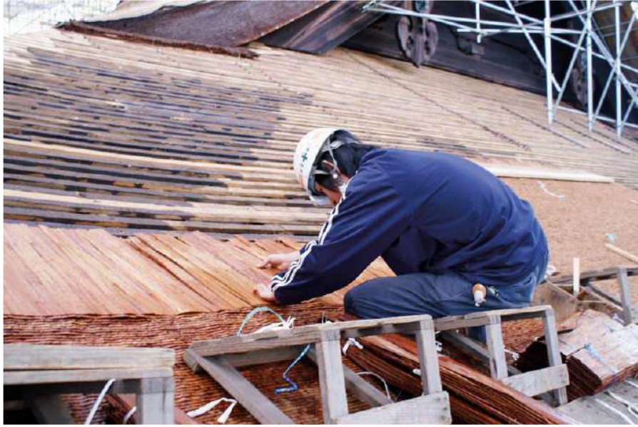
Şekil 3.3. Selvi ağacı kabuğu ile çatı kaplama (ICCRUM, 2020, s. 193)
