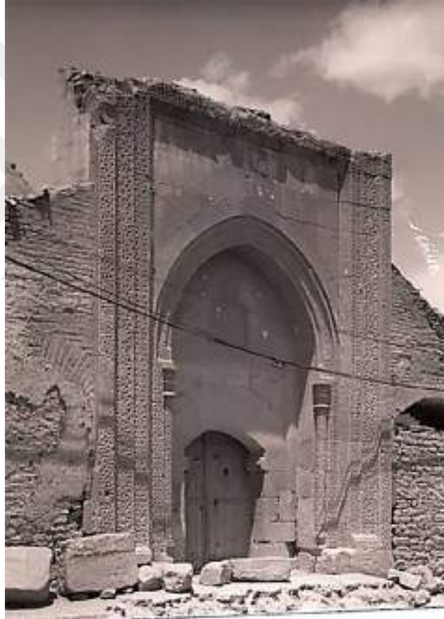
Şekil 4.9. Sahip Ata Hânikâh Taç Kap Restorasyon Öncesi durumu (Yavaş 2015)
