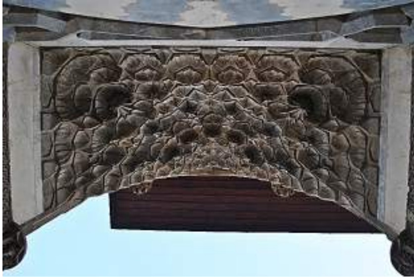
Şekil 3.7. Sahip Ata Camii Taç kapı Alttan Görünüşü (Güler 2020)
