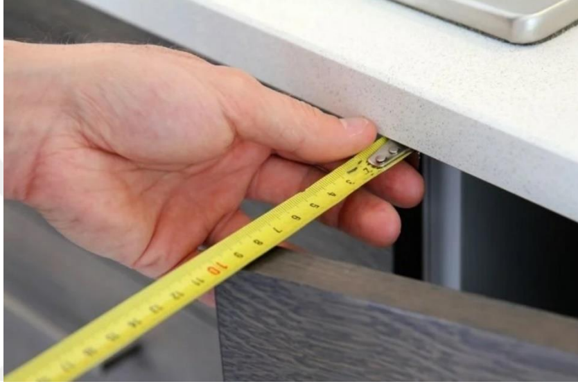
Şekil 2. 15. Sabit donatılarda ölçü alma örnek görsel (URL-10)
