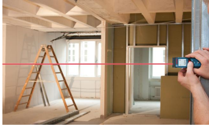
Şekil 2. 14. Lazer metre cihazı ile ölçü alma temsili örnek görsel
