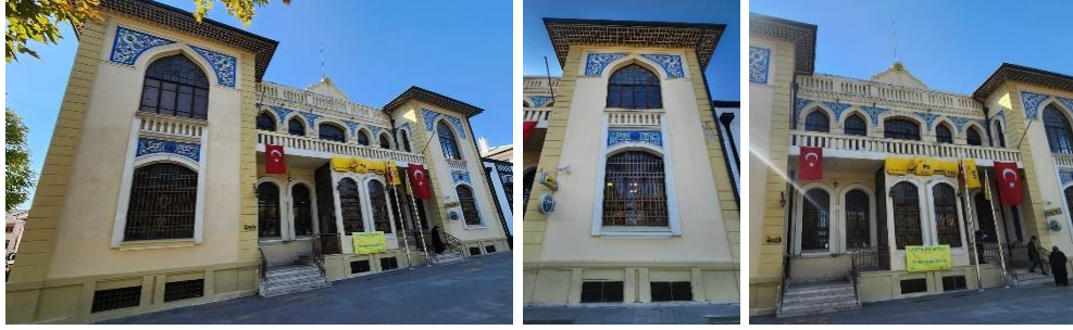
Resim 4.15: PTT Binası kuzeydoğu (ön) cephe
