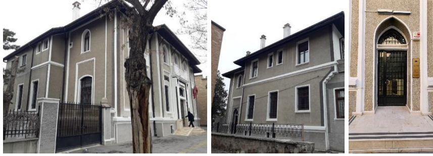
Resim 4.20: Ziraat Bankası güneydoğu ve kuzeybatıya bakan yan cepheleri
