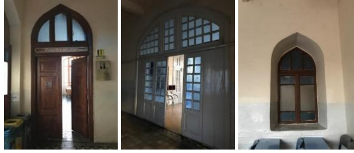
Resim 5.6: Yapının mekânlarından koridorlara açılan, doğal aydınlatma sistemlerine katkı sağlayan kemerli kapıları ve iç pencereleri
