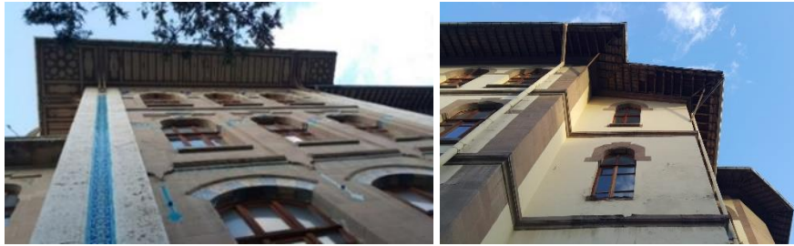
Resim 5.8: Yapının çatı akaçlama sistemi elemanlarından geniş saçakları
