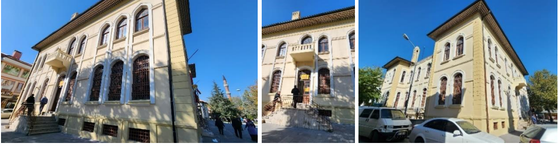
Resim 4.16: PTT Binası güneydoğu (yan) ve güneybatı (arka) cephe
