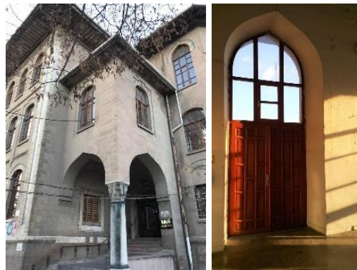
Resim 5.7: Yapının doğal havalandırma sistemlerine katkı sağlayan balkon ve büyük boyutlu balkon kapıları
