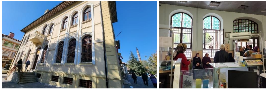
Resim 5.11: Yapının doğal ısıtma sistemi elemanı olan büyük boyutlu, kemerli pencereleri
