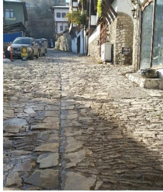
Resim 2.13: Safranbolu'da bir sokakta dere/açık su toplama kanalı örneği
