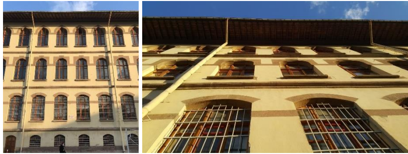
Resim 5.10: Yapının kuzeybatı cephesinin çatı akaçlama sistemi elemanlarından silmeler ve denizlikler
