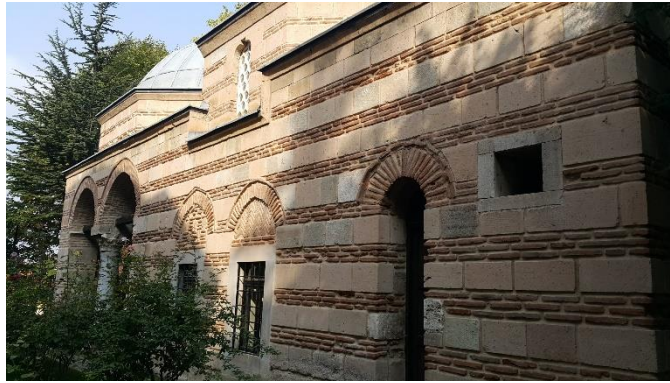
Resim 2.10: Eskişehir Kurşunlu Camii külliyesinden korniş örneği
