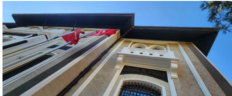
Resim 5.21: Yapının çatı akaçlama sistemi elemanlarından geniş saçakları
