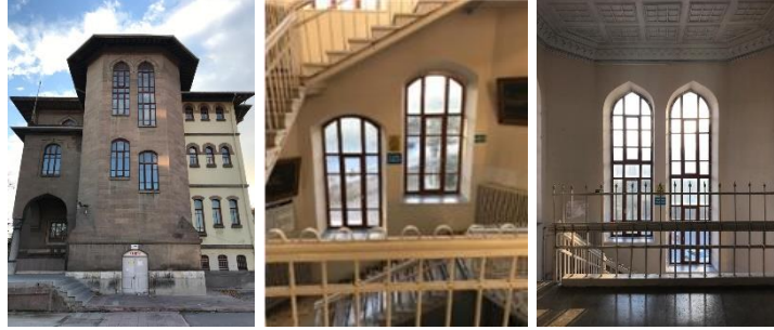
Resim 5.4: Yapının merdiven evlerine yerleştirilmiş, doğal aydınlatma elemanlarından büyük boyutlu pencereler
