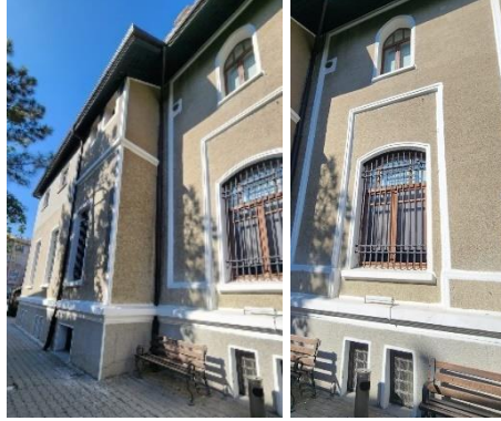
Resim 5.18: Yapının doğal ısıtma sistemi elemanı olan büyük boyutlu pencereleri
