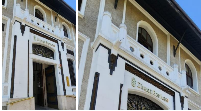
Resim 5.22: Yapının çatı akaçlama sistemi elemanlarından giriş kapısının üstündeki silme ve çörtlenler
