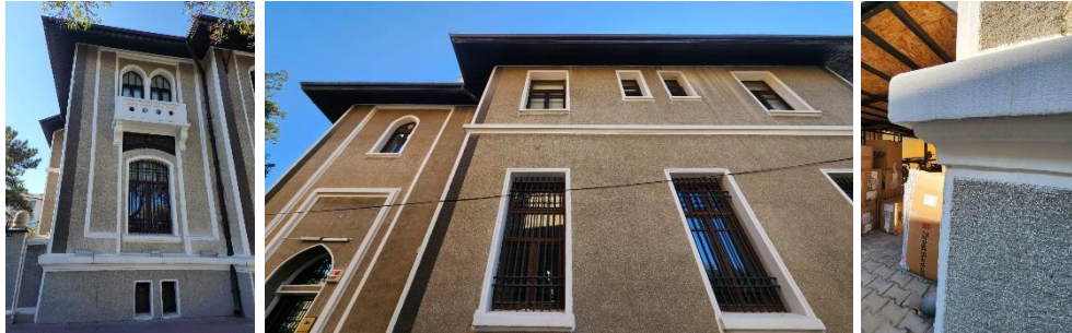
Resim 5.23: Yapının çatı akaçlama sistemi elemanlarından silmeler ve profilli yüzeyler
