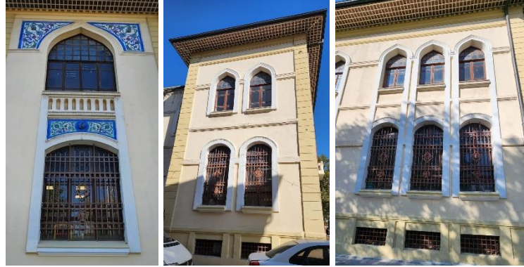
Resim 5.17: Yapının çatı akaçlama sistemi elemanlarından silmeler ve profilli yüzeyleri
