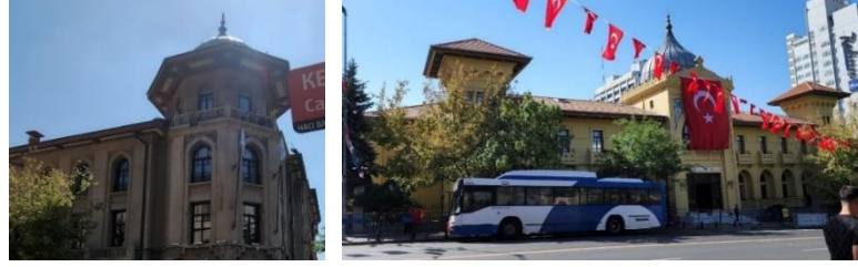
Resim 4.7: Tekel Başmüdürlük Binası girişin üzerine yerleştirilen kubbe, Ankara Palas girişin üzerine yerleştirilen kubbe
