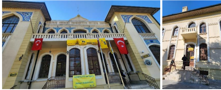
Resim 5.13: Yapının girişlerinin üzerine yerleştirilmiş, doğal soğutma sağlayan balkonları
