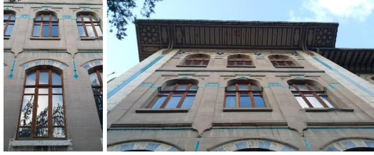
Resim 5.9: Yapının güneydoğu cephesinin çatı akaçlama sistemi elemanlarından silmeler ve profilli yüzeyleri
