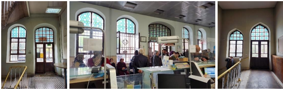
Resim 4.17: PTT Binası zemin kat koridordan yan giriş, müşteri holü ve birinci kat koridordan balkon kapısı
