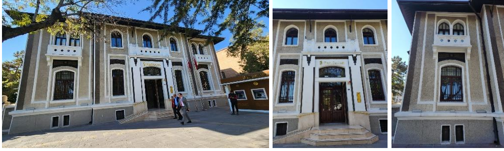
Resim 4.19: Ziraat Bankası kuzeydoğu (ön) cephe
