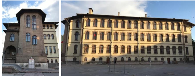
Resim 4.12: Konya Lisesi kuzeydoğu (yan) (solda) ve kuzeybatı cephe (sağda)
