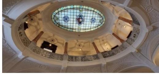
Resim 4.9: İş Bankası Genel Müdürlük Binası müşteri holü mekânında cam tavan
