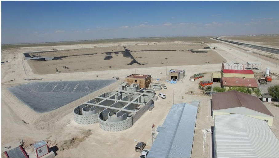
Şekil 2.9. Kaşınhanı Katı Atık Depolama Sahası (ÇŞB, 2009)
