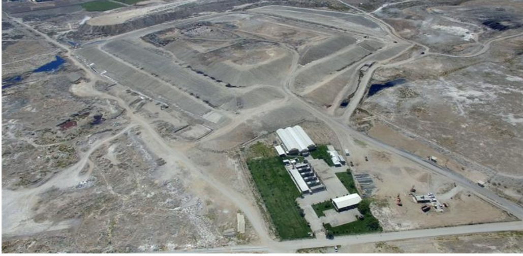
Şekil 2.11. Kaşınhanı Katı Atık Depolama Sahası (ÇŞB, 2009)
