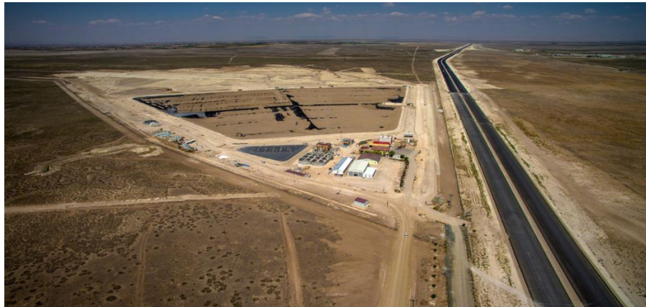
Şekil 2.10. Kaşınhanı Katı Atık Depolama Sahası (ÇŞB, 2009)
