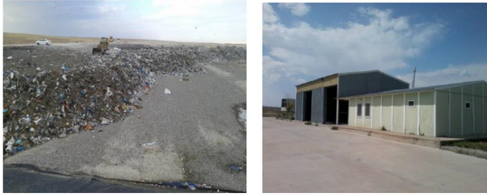
Şekil 2.15. Cihanbeyli Katı Atık Depolama Tesisi (Konya Valiliği, 2020)
