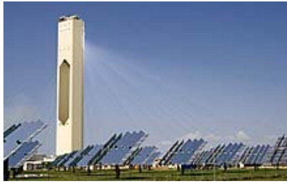
Şekil 1.3. PS10 Solar enerji kulesi, Sevilla (Flickr_photo, 2007)
