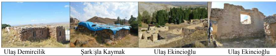
Şekil 4.2.4. 1. Tüteklikli Kırsal Konutların Taş Duvar Biçimlenişleri
