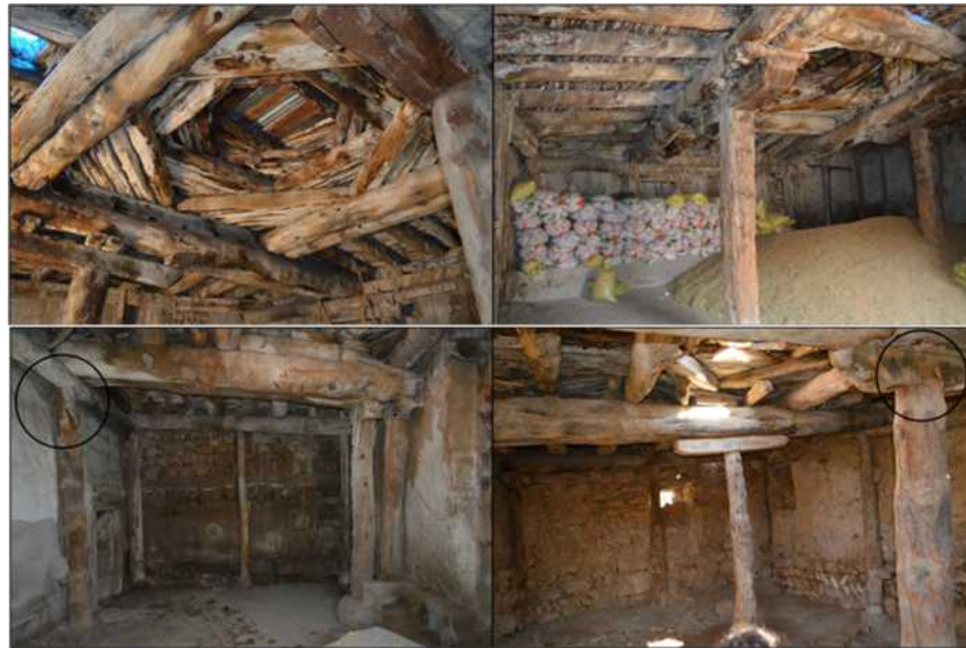
Şekil 4.2.4. 6. Bindirme, Karaboğaz Tekniği
