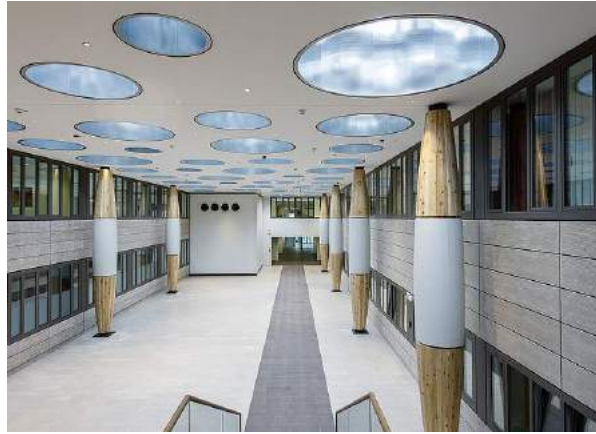
Fotoğraf.39. Almanya Garmisch – Partenkirchen kliniği yapısının fuayesinin üst örtüsündeki ışık tüpleri ( URL – 29).
