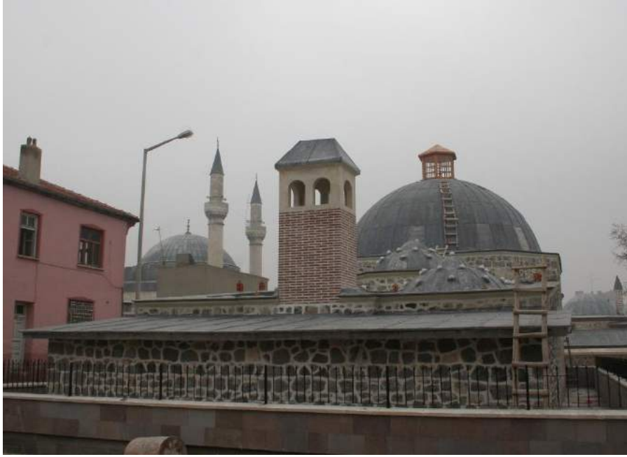
Fotoğraf.27. Karapınar Valide Sultan Hamamı'nın külhan üzerinde yer alan ana bacası. *Fotoğraf yazar tarafından 2019 yılında çekilmiştir.
