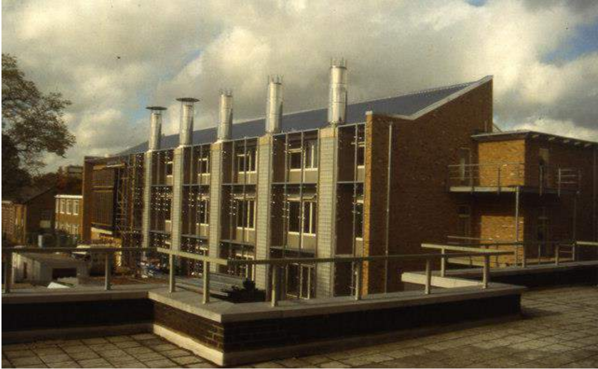
Fotoğraf.54. Building Research Establishment Ofis binası (1996) cephesinde yer alan rüzgâr bacaları (URL – 42).
