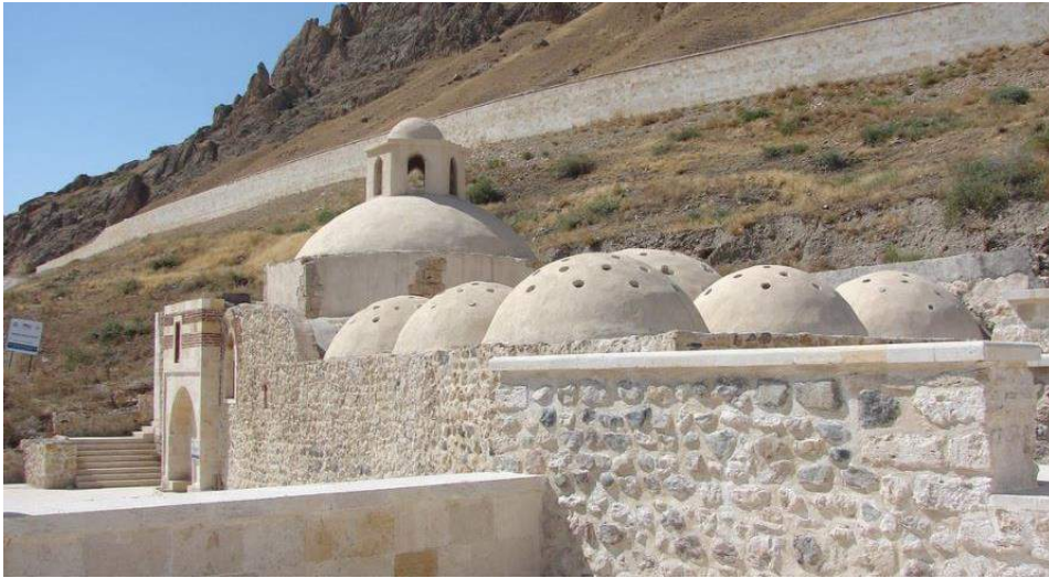
Fotoğraf.14. 1619 yılında yapılan Osmanlı eseri (Palu – Diyarbakır) Çarşıbaşı Hamamı'nın kubbe aydınlık delikleri ve soyunmalık üzerinde yer alan, yanları açık ışıklık feneri. 15
