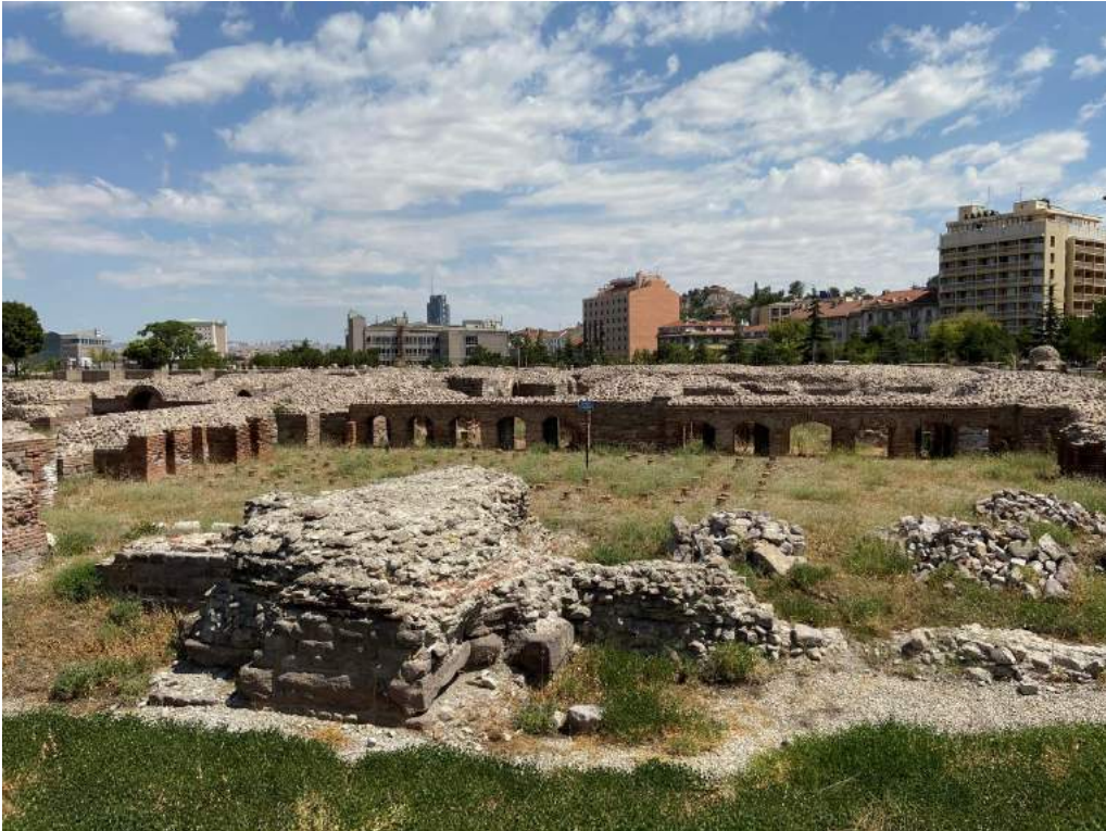
Fotoğraf.16. Ankara Roma Caracalla Hamamı Tepidarium ve Apodyterium arası duvarda yer alan kemerli hypocaust kanalları geçişi. *Fotoğraf yazar tarafından çekilmiştir, 2020.
