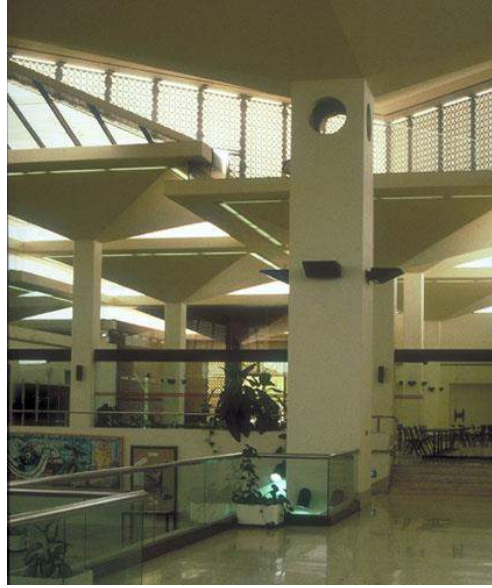
Fotoğraf.53. Katar Üniversite (1992) binaları rüzgâr bacalarının içeriye açılan kısımları (URL – 41).
