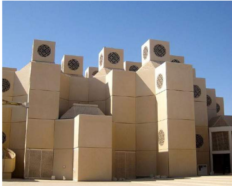
Fotoğraf.52. Katar Üniversite (1992) binalarının çatısında yer alan alışılmışın dışında bir rüzgâr bacası örneği (URL – 40).
