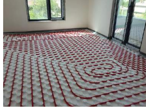
Fotoğraf.33. Roma hamamı caldarium bölümü zemini hypocaust sistemi ayakları. (solda) (URL – 23) Fotoğraf. Yerden ısıtma borularının ısı yalıtım panelindeki boşluklu yapıya yerleşim şekli. (sağda) (URL – 24).
