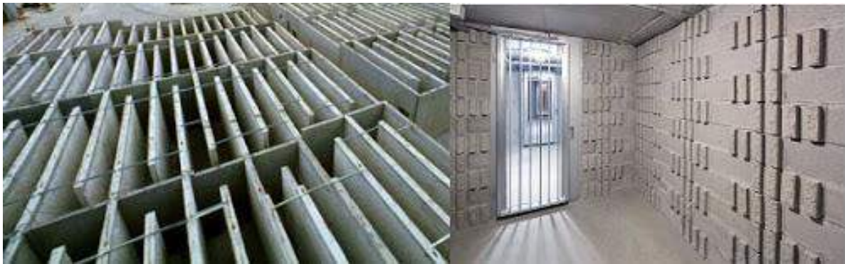
Fotoğraf.32. Ankara Türkiye Mühendisler Birliği Merkez Binasına ait labirent sistem planı (solda) ve labirent koridorları arası boşluklu geçiş kapıları (sağda) (URL – 20).
