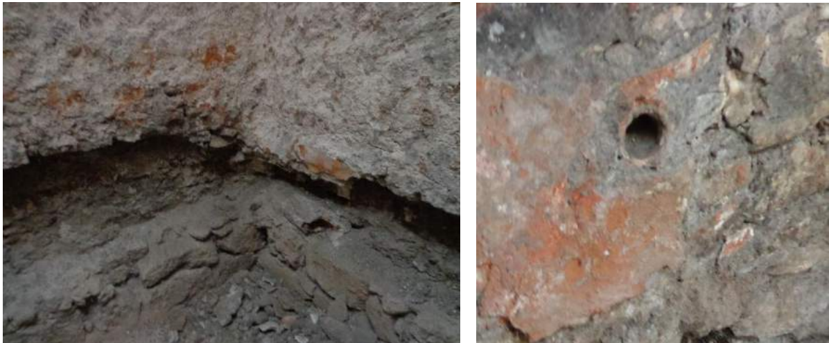
Fotoğraf.24. Karaman Hatun Hamamı eyvan bölümüne ait duvar içerisinde geçen sıcak ve soğuk su künkleri (solda) . Fotoğraf. Künklerden gelen suyun duvardan çıkış noktası ve kurnalara aktığı yer / lüle taşı (sağda). *Fotoğraflar yazar tarafından 2018 yılında çekilmiştir.
