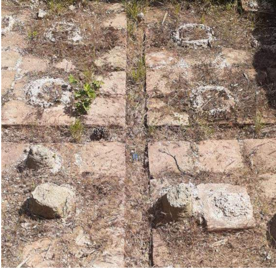
Fotoğraf.22. İstanbul Kartal Bizans Hamamı'nın caldarium zemininde yer alan atık su toplama kanalları. *Fotoğraf yazar tarafından 2021 yılında çekilmiştir.
