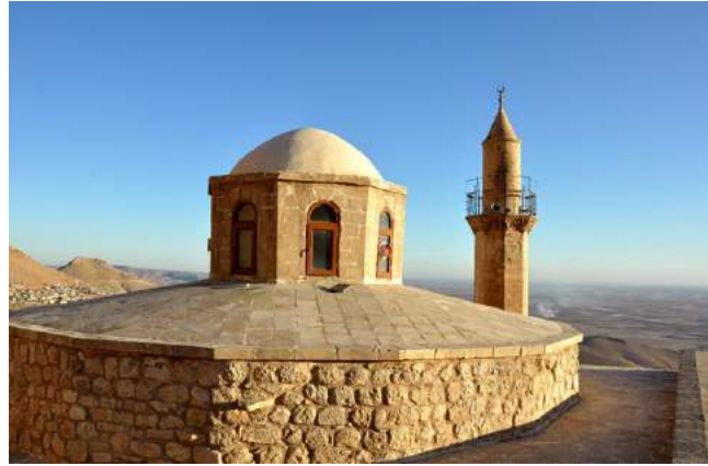
Fotoğraf.46. Mardin Sıhhi Emir Hamamı (12.yy) soyunmalık kubbesi ışıklık / havalandırma feneri (URL – 36).
