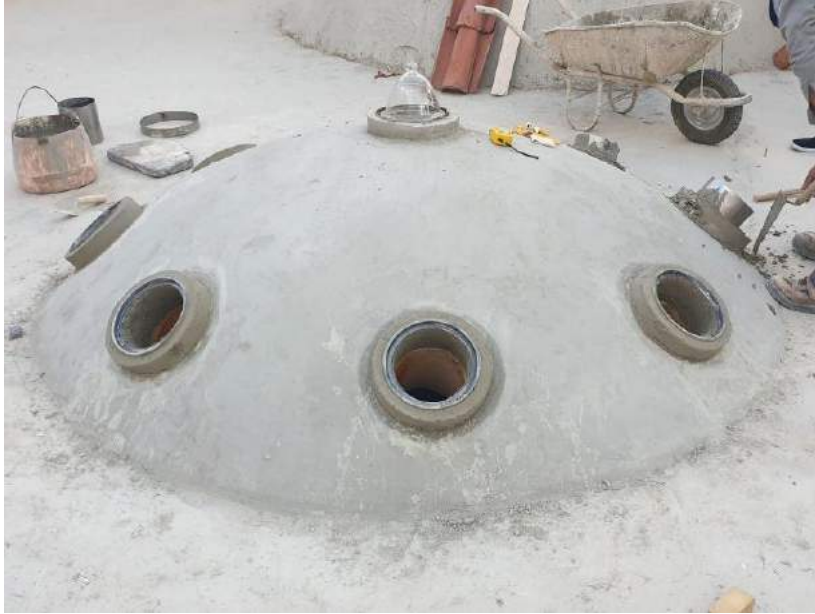
Fotoğraf.38. Karaman Hatun Hamamı halvet kubbelerinde yer alan fil gözlerinin kanal boşlukları ve döküm kasnak üzerine cam fanus ile sonlandırılması.* Yazara ait fotoğraf arşivi, 2020.
