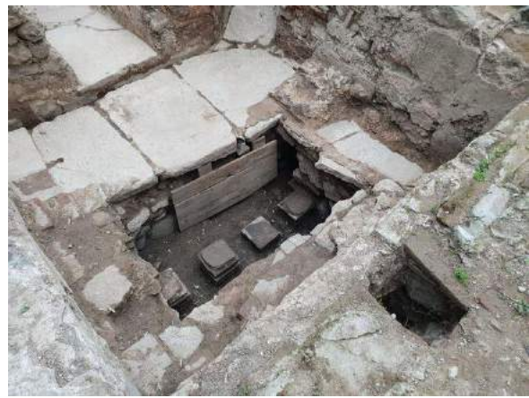
Fotoğraf.12. 14.yy'da İznik'te yapılan ilk Osmanlı dönemi hamam yapılarından Orhan Hamamı'nın cehennemlik kanallarını oluşturan tuğla ayaklar (solda) ve üzerini kapatan sal taşları.(sağda) (URL – 12).
