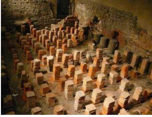
Fotoğraf.33. Roma hamamı caldarium bölümü zemini hypocaust sistemi ayakları. (solda) (URL – 23) Fotoğraf. Yerden ısıtma borularının ısı yalıtım panelindeki boşluklu yapıya yerleşim şekli. (sağda) (URL – 24).
