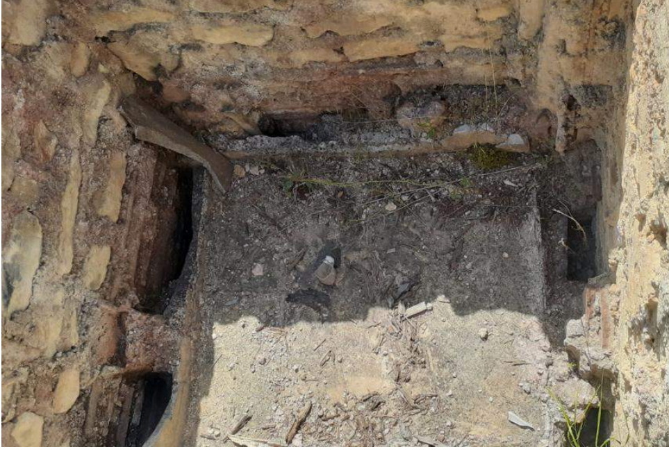
Fotoğraf.21. İstanbul Kartal Bizans Hamamı'nın caldariumunda yer alan havuzun duvarlarındaki, duvar ısıtma amaçlı boşluklar. *Fotoğraf yazar tarafından 2021 yılında çekilmiştir.
