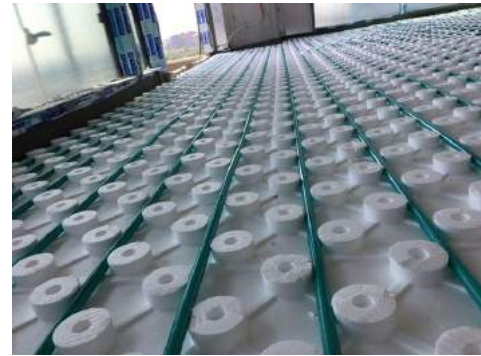
Şekil 4.11. Hypocaust yerden ısıtma sisteminde duman dolaşım kanallarını oluşturan ayaklar ve boşluklu yapısı (Başaran, 1997, 1013). Fotoğraf. Günümüz yerden ısıtma sisteminin ısı yalıtım levhası ve sıcak su dolaşım boruları (URL – 25).
