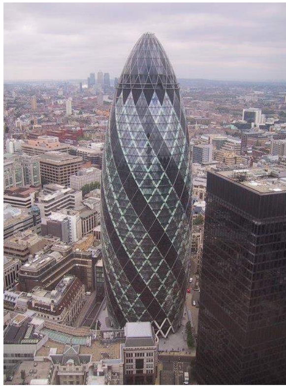
Fotoğraf.49. Swiss Re Genel Merkez Binası Londra – İngiltere (1997-2004) (URL – 37).
