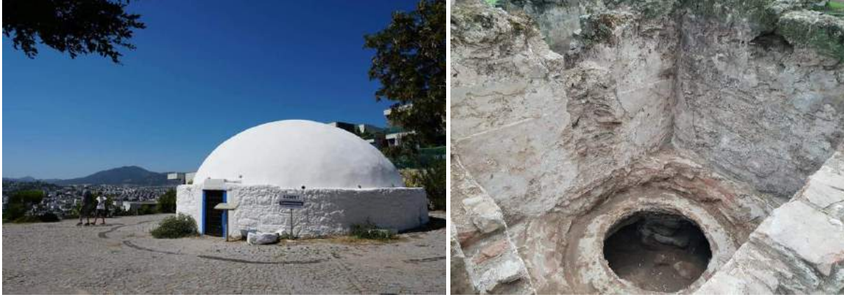
Fotoğraf. 62. Üzeri kubbe örtülü tek mekândan oluşan Bodrumda yer alan bir su sarnıcı (solda) (URL – 53) İznik Orhan Gazi Hamamı (13. yy) su deposu ve su kazanının oturduğu yer (sağda) (URL – 54).
