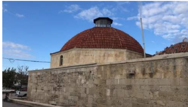
Fotoğraf.47. Karaman Yeni hamam (16.yy) soyunmalık kubbesi ışıklık / havalandırma feneri. *Fotoğraf 2019 yılında yazar tarafından çekilmiştir.
