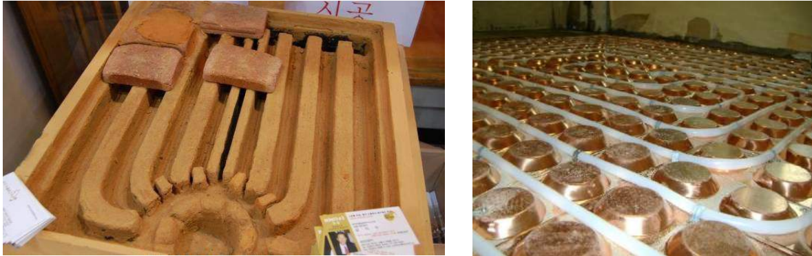
Fotoęraf.34. Ondol sisteminde yer alan Gudul kanallarının modeli. (solda) Fotoęraf. Kore’de uygulanan modern ondol olarak adlandırdıkları yerden ısıtma sistemi (saęda) (URL – 27).
