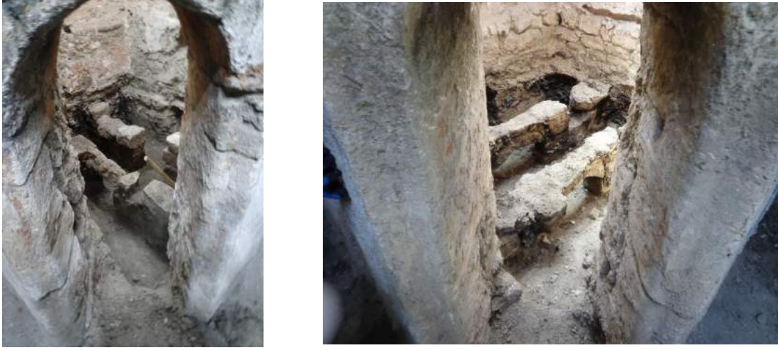
Fotoğraf.23. Karaman Hatun hamamı halvetlerine ait üzeri açık cehennemlik kanalları. *Fotoğraf 2018 yılında yazar tarafından çekilmiştir.
