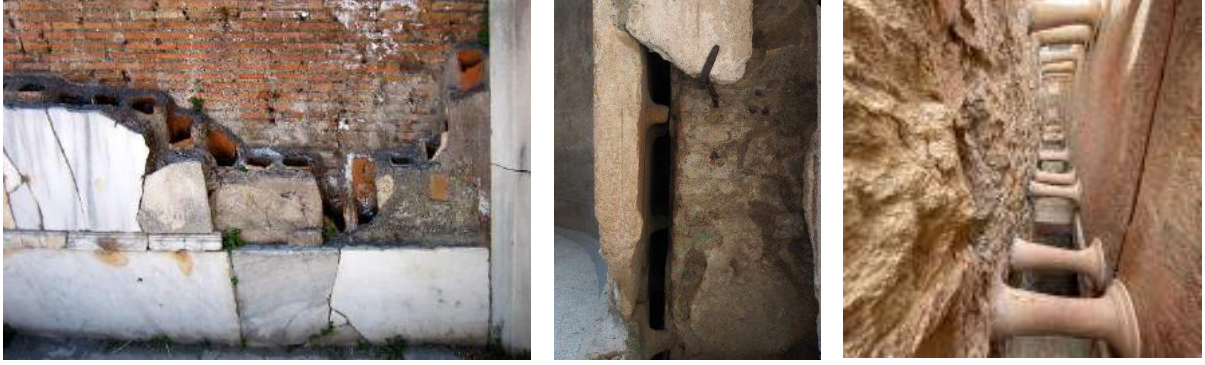
Fotoğraf.31. Tubuli (solda) (URL – 16) Fotoğraf. Tegulae Mammatæ (ortada) (URL – 17) Fotoğraf. Spacer Pins (sağda) (URL – 18).
