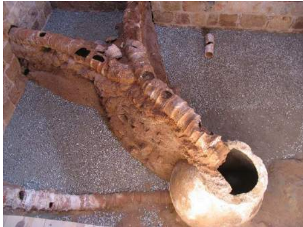
Fotoğraf.59. Ordu-Aybastı Sefalı Köyü Büyük hamam sıcaklık duvarında yer alan sıcak ve soğuk su künkleri,(solda) (URL – 48) Antalya Yivli Minare Camii (1230) zemininde yer alan küp içerisine su taşıyan toprak künkler. (sağda) (URL-49).
