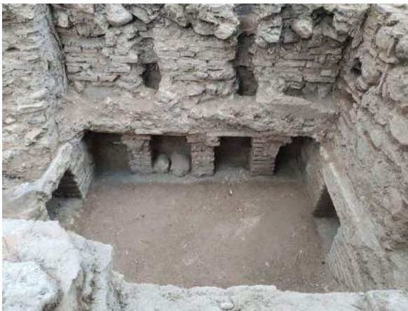
Fotoğraf.12. 14.yy'da İznik'te yapılan ilk Osmanlı dönemi hamam yapılarından Orhan Hamamı'nın cehennemlik kanallarını oluşturan tuğla ayaklar (solda) ve üzerini kapatan sal taşları.(sağda) (URL – 12).
