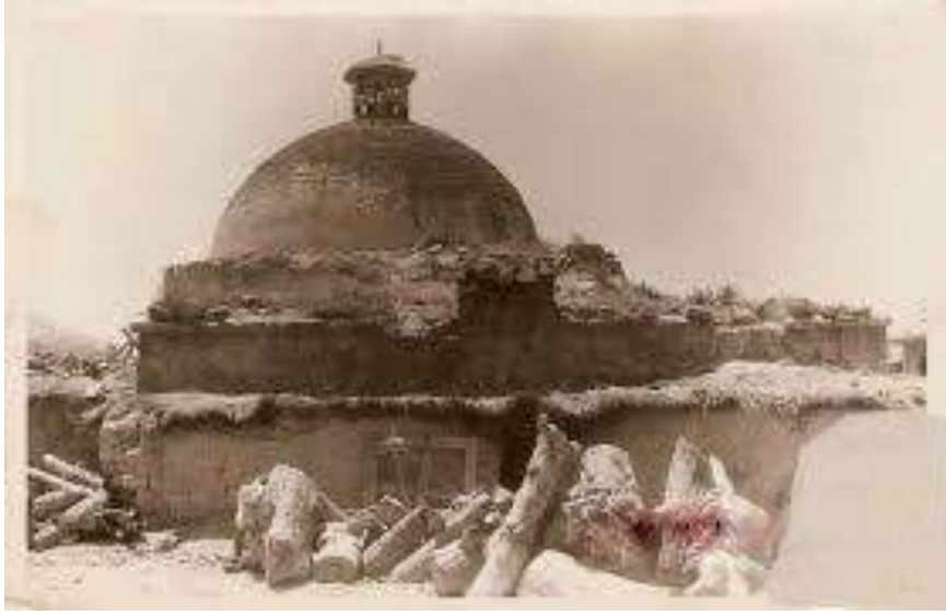
Fotoğraf.29. Valide Sultan Hamamı'nın toprak dam üst örtüsünü ve kamış hasırlarla oluşturulmuş saçak kısmını gösteren bir fotoğraf (URL – 15).
