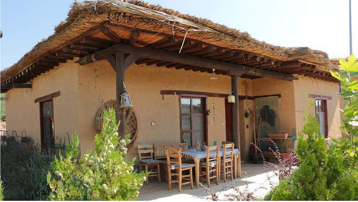
Fotoğraf.67. Konya Sonsuz Şükran Köyünde yer alan bir evi toprak damını oluşturan ahşap hezenler ve kamış hasırlar net bir biçimde görülmektedir (URL – 62).
