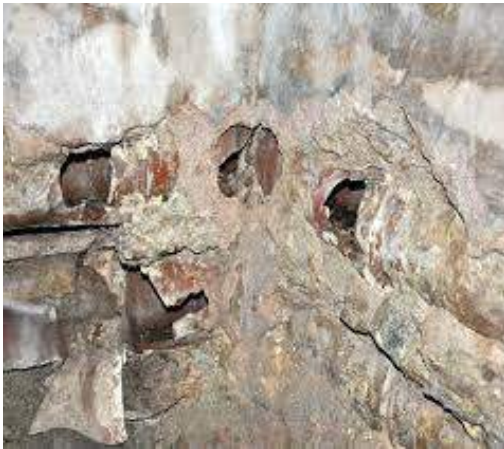
Fotoğraf.59. Ordu-Aybastı Sefalı Köyü Büyük hamam sıcaklık duvarında yer alan sıcak ve soğuk su künkleri,(solda) (URL – 48) Antalya Yivli Minare Camii (1230) zemininde yer alan küp içerisine su taşıyan toprak künkler. (sağda) (URL-49).
