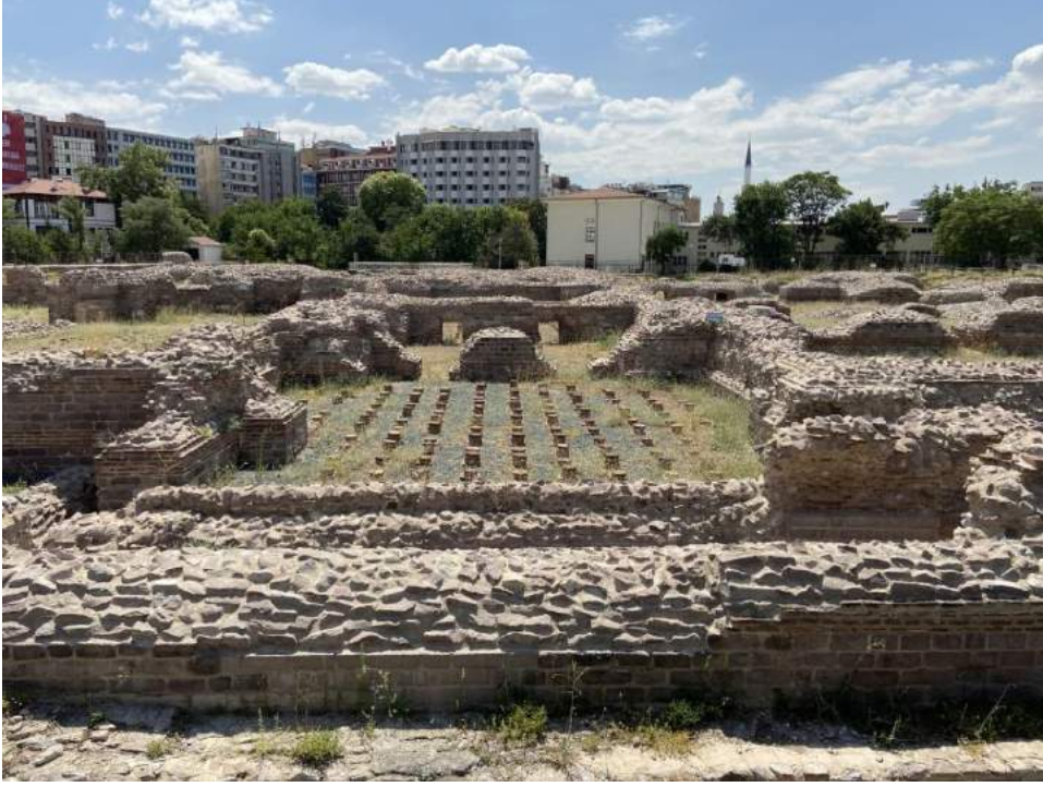
Fotoğraf.15. Ankara Roma Caracalla Hamamı Caldarium bölümüne ait hypocaust kanallarını oluşturan pilae tuğlaları. *Fotoğraf yazar tarafından çekilmiştir, 2020.
