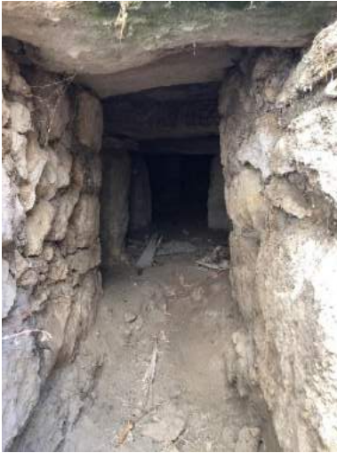
Fotoğraf.10. Cehennemlik kanalı (solda) ve mekânların zeminlerine açılan ağızları (sağda) ) 11
