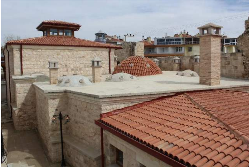
Fotoğraf.25. Karaman Hatun Hamamı fil gözleri, ışıklık feneri ve üst örtü kaplaması. *Fotoğraf yazar tarafından 2021 yılında çekilmiştir.
