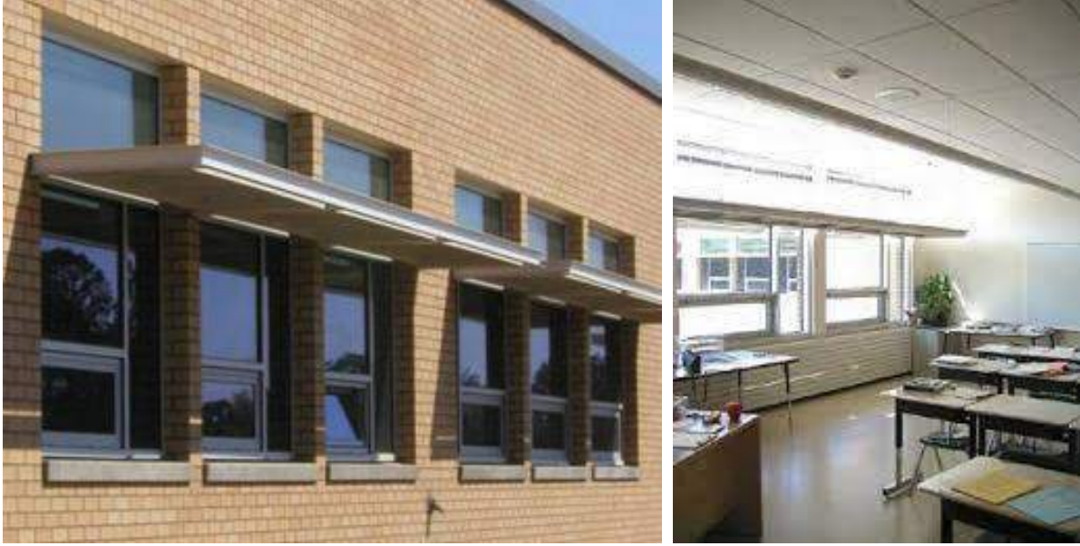
Fotoğraf.45. Ash Creek Intermediate School binası (1998) dış cephe güneş rafları ve içeriden görünümü (URL – 35).
