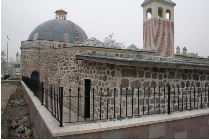
Fotoğraf.30. Valide Sultan Hamamı'nın restorasyon uygulamasından sonra kurşun kaplama üst örtüsü ve kurşun kaplı saçakları. *Fotoğraf yazar tarafından 2019 yılında çekilmiştir.
