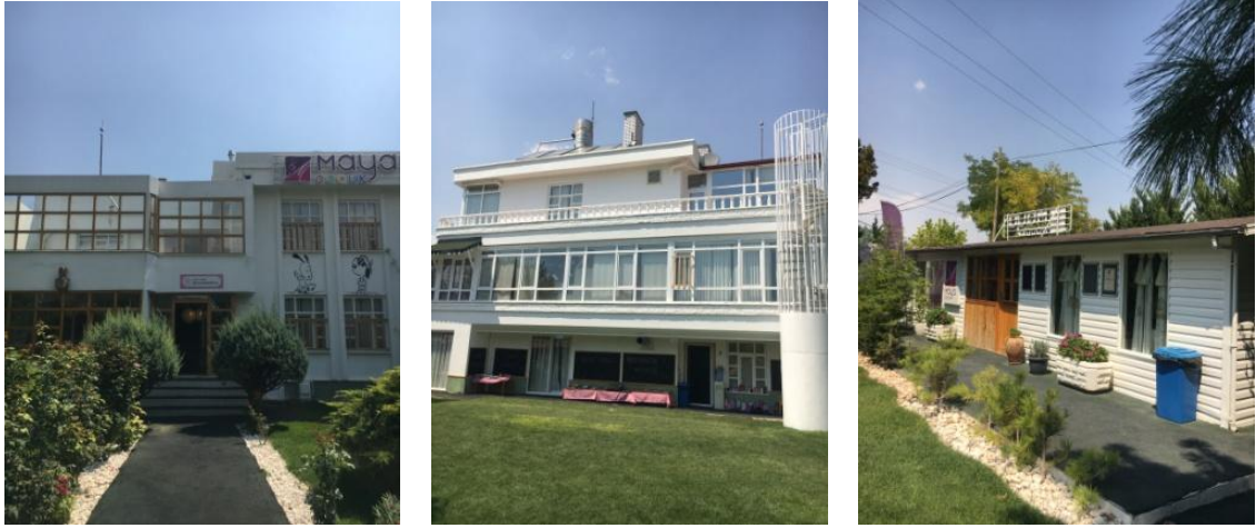
Şekil 4.4. Binanın kuzey cephesi ve güney cephesi ile idari bina
