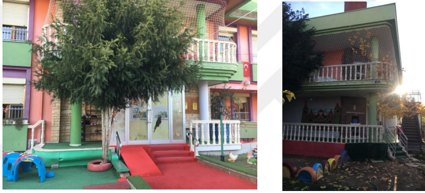
Şekil 4.18. Binanın güney cephesi ve kuzeydoğu cephesi
