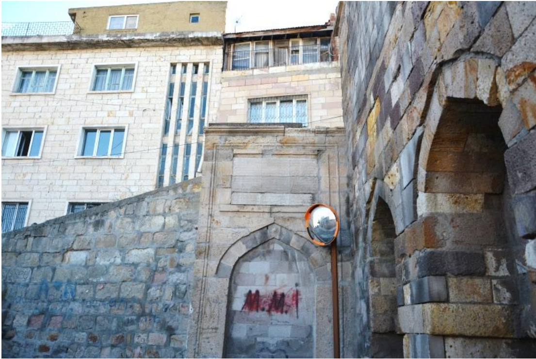
Resim 3.12. İstinad duvarı üzerindeki kitâbeli çeşme
