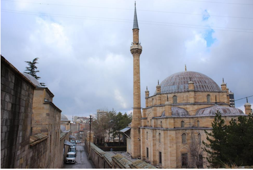
Resim 3.1. Nevşehir Damat İbrahim Paşa Külliyesi'nin güney cephesinden bir görünüm
