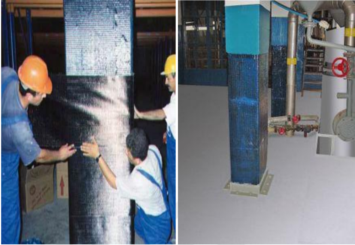
Şekil 3.6. FRP kompozit malzemelerin kolonlarda kullanılması (Anonim, 2019c)
