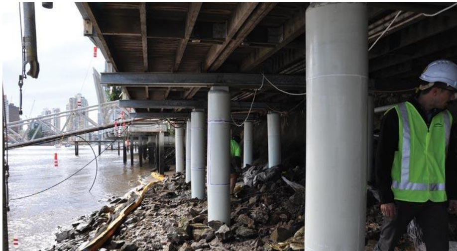
Şekil 3.5. Köprü kolon ve ayaklarının FRP kompozit malzeme ile güçlendirilmesi (Anonim, 2019b)
