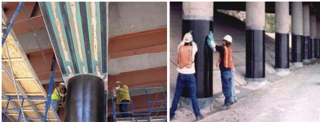
Şekil 3.4. FRP kompozit malzemelerin güçlendirme işleminde kullanılması (Anonim, 2019a)
