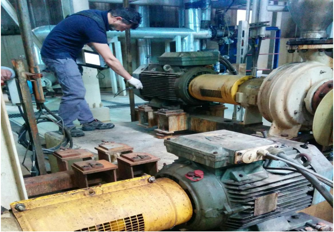
Şekil 5.2. Eksen Kaçıklığına sahip motor ve dıştan yatay eksnel ölçümü
