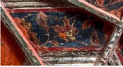
Resim 39: Hünkâr Mahfil Bordür Detayı
