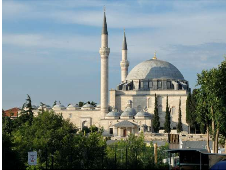
Resim 8: Yavuz Sultan Selim Camii Görünüş (Wikipedia) 74
