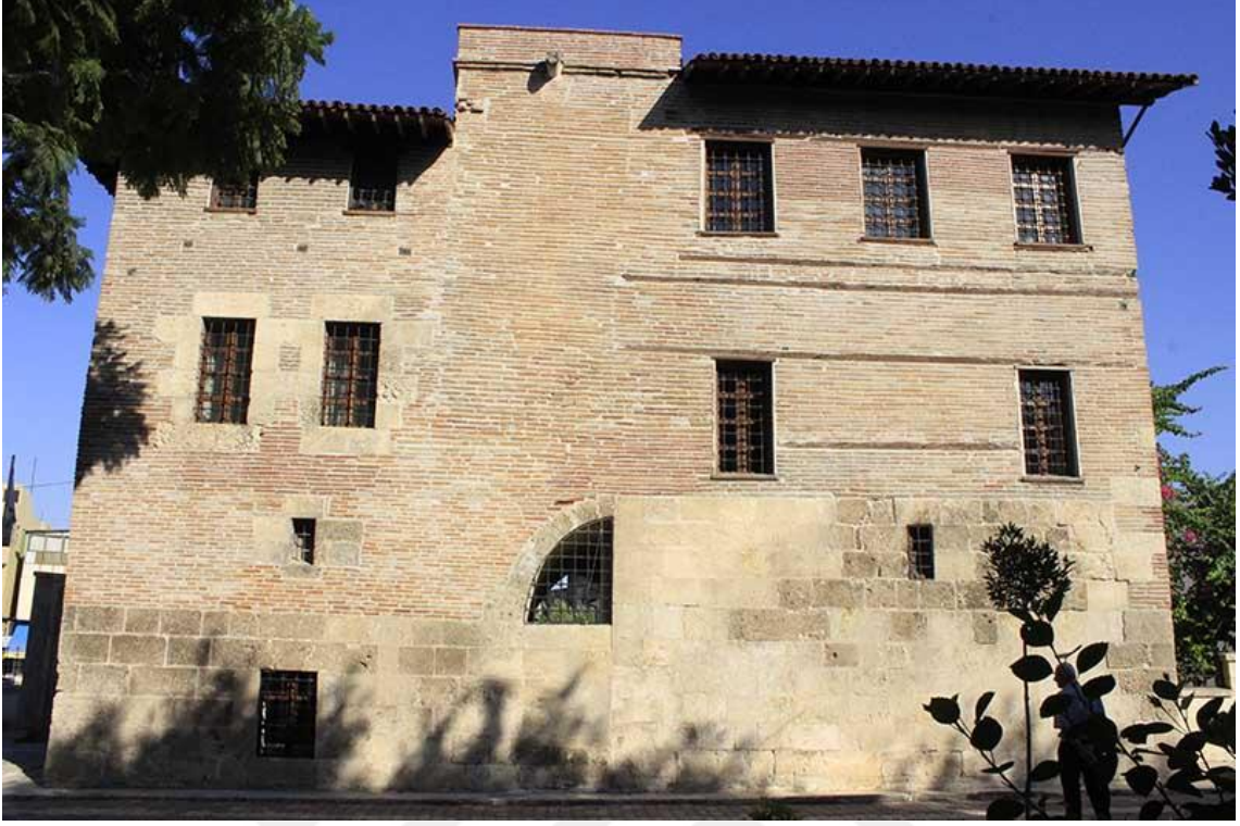
Fotoğraf 53: Ramazanoğlu Konağı doğu cephesi.
