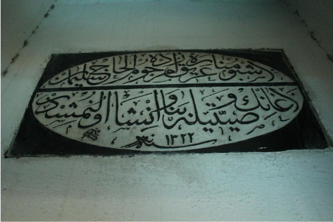
Fotoğraf 126: Arızkade Hacı Ali Efendi Camii minare kitabesi. (Not: Yazıyla minare kapısı arasındaki dar aralıktan dolayı fotoğrafın tam karşıdan çekimi yapılamamıştır.)
