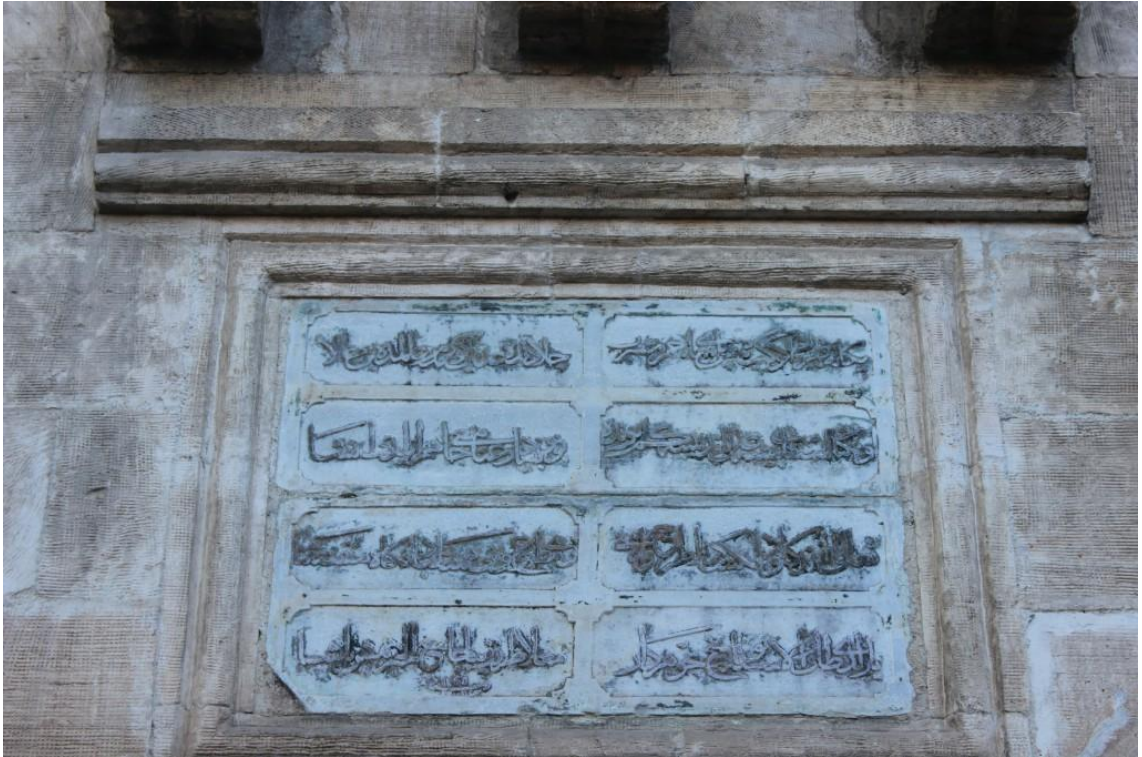
Fotoğraf 139: Memiş Paşa Camii kitabesi.
