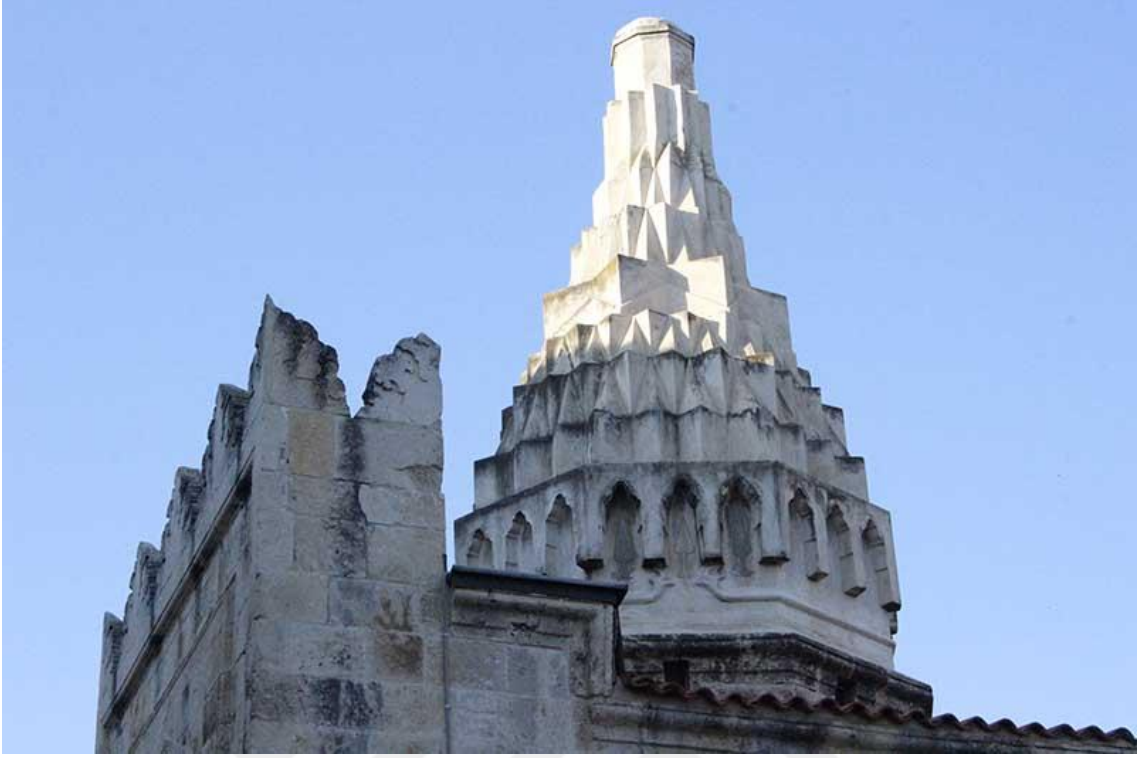
Fotoğraf 12: Ulu Camii batı taç kapısı üzerindeki mukarnas konik örtü.
