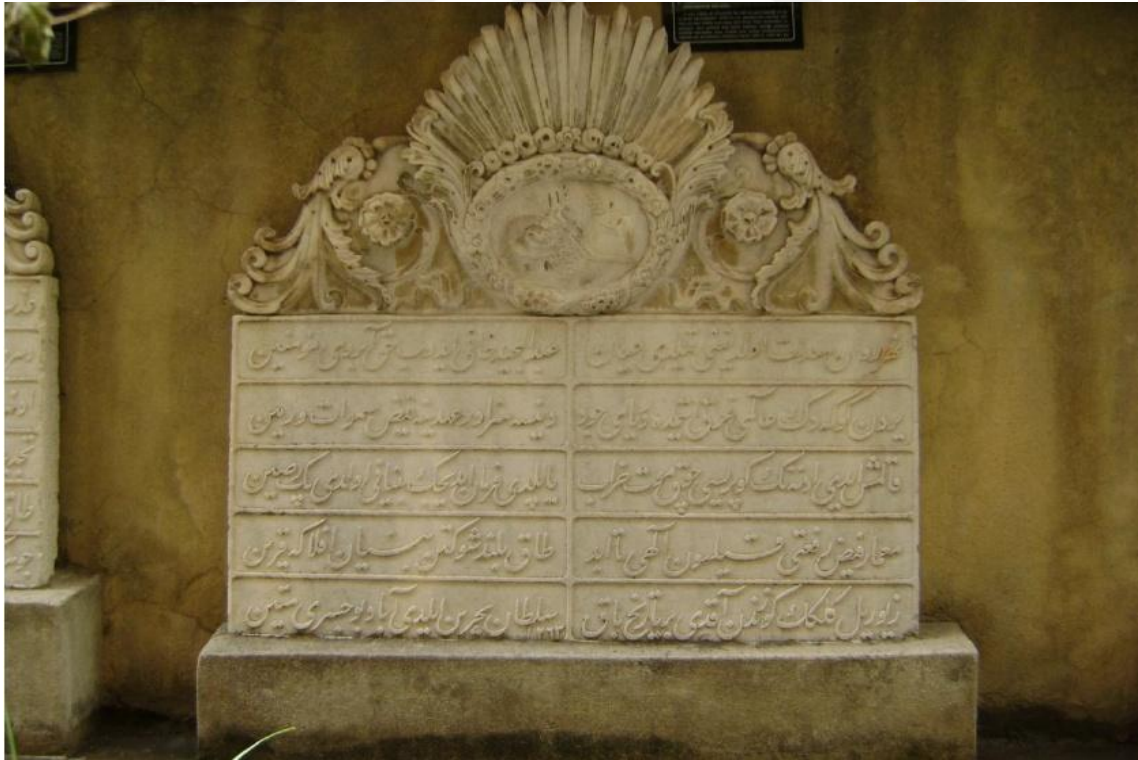
Fotoğraf 118: Taş Köprü Sultan Abdülmecid'in ikinci onarım kitabesi. (Foto: Abdullah Sezer)
