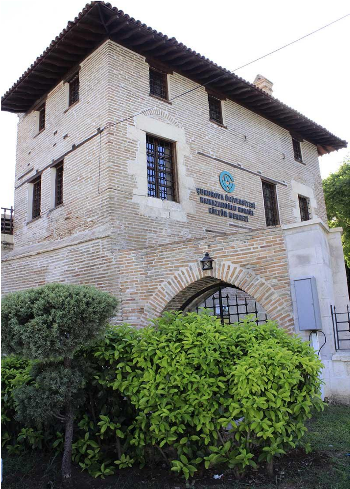
Fotoğraf 52: Ramazanoğlu Konağı kuzeydoğudan görünümü.
