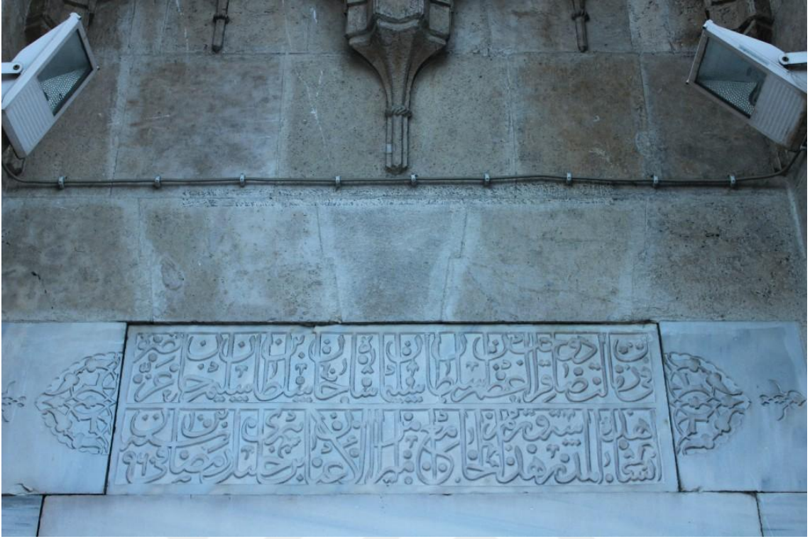
Fotoğraf 71: Yağ Camii medrese taç kapı inşa kitabesi.
