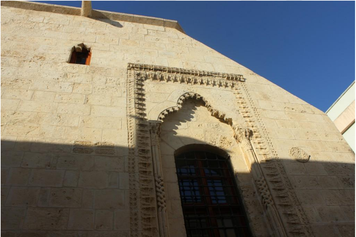
Fotoğraf 104: Yeşil Mescit güney cephe. (Pencerenin sol tarafında kitabe ve sağında kabara)
