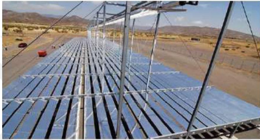
Şekil 1.6. Fresnel mercekli yoğunlaştırıcı sistem (Moukhtar ve ark., 2020)
