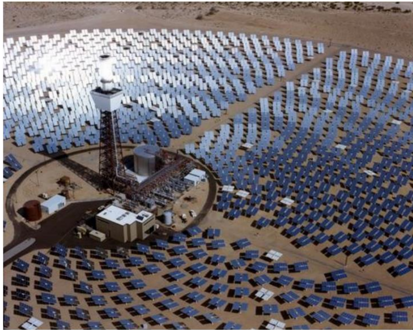
Şekil 1.4. Kalifornia'da tipik bir güneş kulesi tipi yoğunlaştırıcı (Mendelsohn ve ark., 2012)
