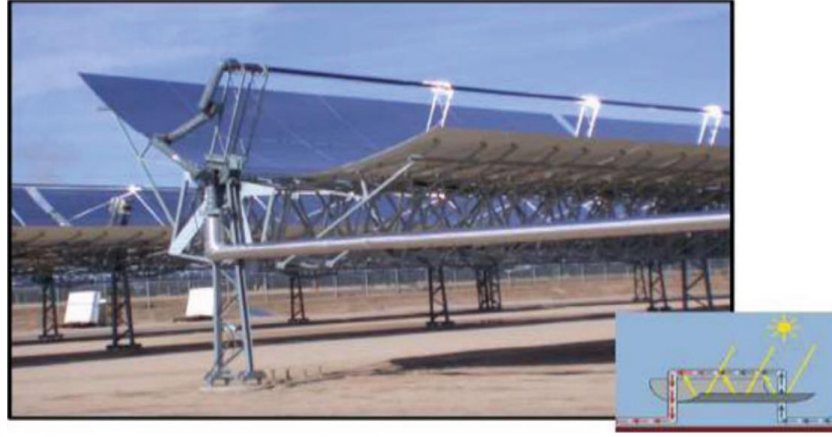
Şekil 1.7. Parabolik oluk tipi yoğunlaştırıcı (Cardozo, 2012)
