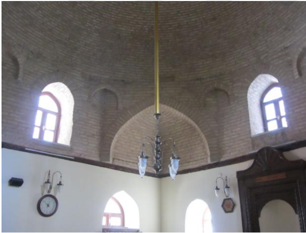
Resim 3.76. Tercüman Mescidi kubbesi ve kubbeye geçiş elemanı
