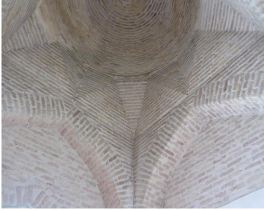
Resim 3.144. Tahir ile Zühre Mescidi türbe bölümü kubbeye geçiş elemanı
