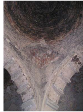
Resim 2.36. Degaron Camii kubbeye geçiş elemanı (Web iletisi 31)
