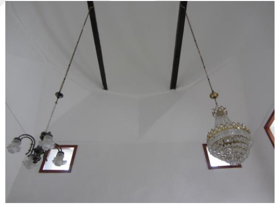
Resim 3.129. Sakahane Mescidi kubbeye geçiş elemanı
