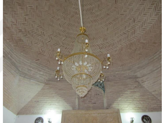
Resim 3.90. Aksinne Mescidi kubbesi ve kubbeye geçiş elemanı
