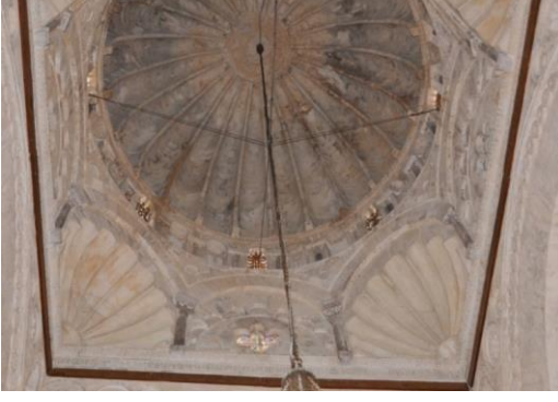
Resim 2.33. Kayravan Camii kubbeye geçiş elemanı (Web iletisi 28)
