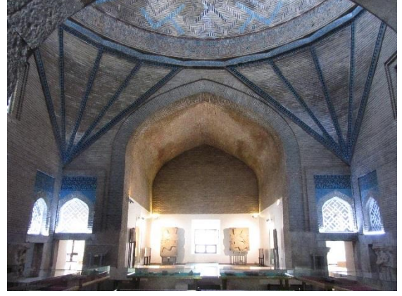
Resim 2.60. İnce Minareli Medrese kubbeye geçiş elemanı, dört üçgenden oluşan düzlem üçgen
