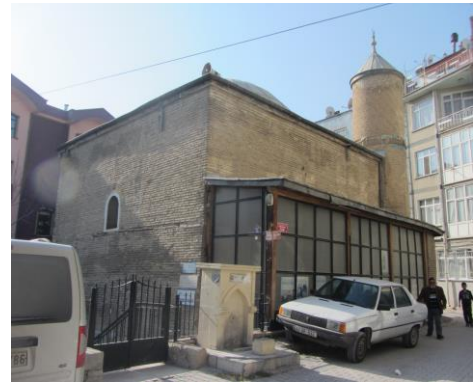
Resim 3.81. Zenburi Mescidi kuzey doğu cephesi
