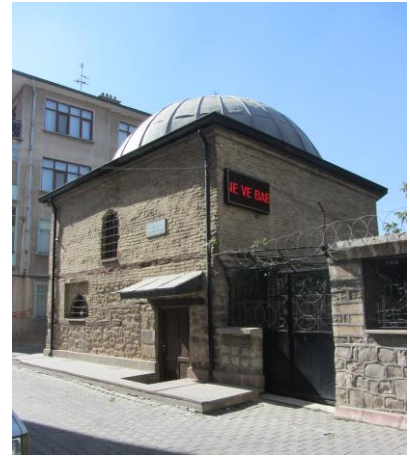
Resim 3.73. Tercüman Mescidi kuzey doğu cephesi
