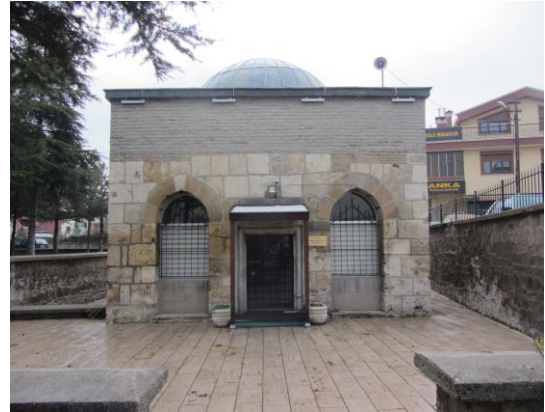
Resim 3.118. Karatay Mescidi kuzey cephesi
