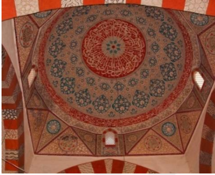
Resim 2.26. Edirne Eski Cami üçgenler kuşağı kullanımı (Web iletisi 21)
