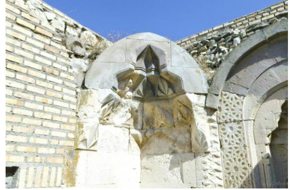
Resim 2.45. Sultan Hanı köşk mescidi kubbeye geçiş elemanı (Web iletisi 40)
