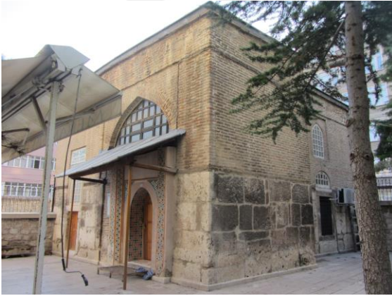
Resim 3.140. Tahir ile Zühre Mescidi kuzey doğu cephesi
