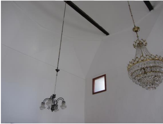
Resim 3.128. Sakahane Mescidi kubbeye geçiş elemanı
