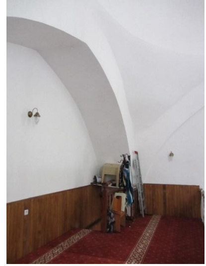
Resim 3.7. Kuzey cephede bulunan sivri kemer
