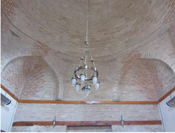
Resim 3.27. Erdemşah Mescidi kubbesi ve kubbeye geçiş elemanı
