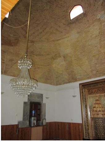
Resim 3.152. Beyhekim Mescidi kubbeye geçiş elemanı
