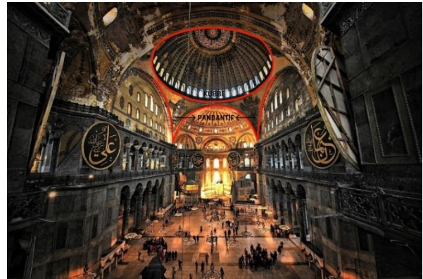
Resim 2.15. Ayasofya kubbeye geçiş elemanı (Web iletisi 13'den şematize edilmiştir)
