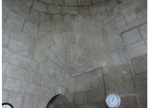
Resim 3.42. Taş Mescit kubbeye geçiş elemanı
