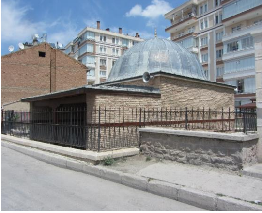
Resim 3.87. Aksinne Mescidi güney-batı cephesi
