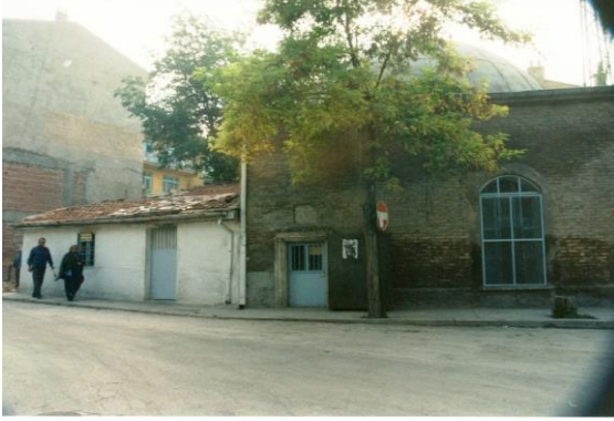
Resim 3.9. Zevle Sultan Mescidi fotoğrafı (Vakıflar Bölge Müdürlüğü arşivinden)
