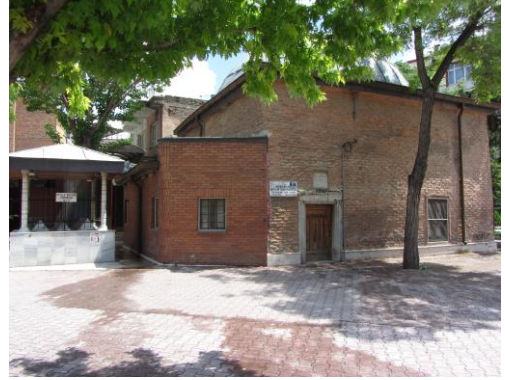
Resim 3.10. Zevle Sultan Mescidi kuzey batı cephesi
