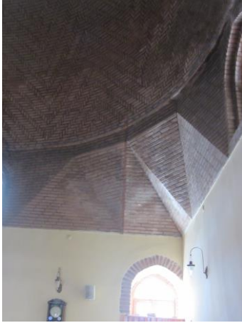
Resim 3.135. Sırçalı Mescit kubbeye geçiş elemanı
