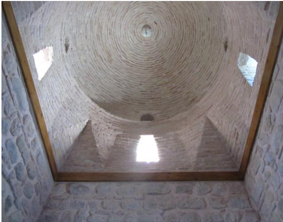
Resim 3.114. Hoca Ahmet Fakih Mescidi kubbesi ve kubbeye geçiş elemanı
