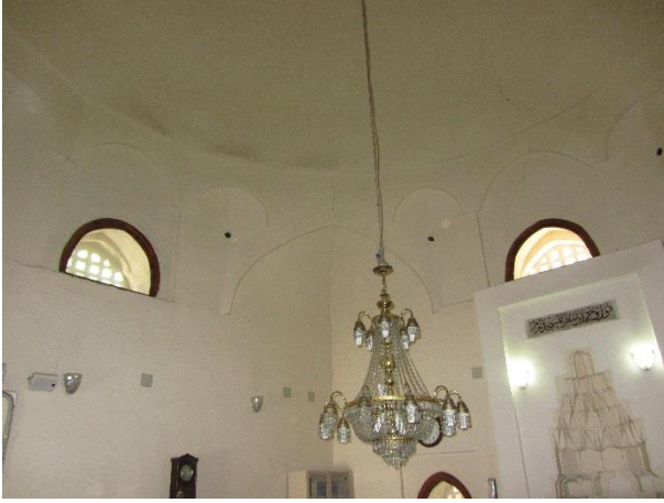
Resim 3.62. Hoca Hasan Mescidi kubbeye geçiş elemanı
