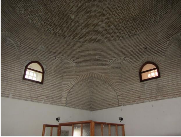
Resim 3.69. İç Karaaslan Mescidi kubbesi ve kubbeye geçiş elemanı
