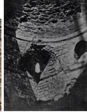
Resim 2.32. Servistan Sarayı kubbeye geçiş elemanı (Web iletisi 27)
