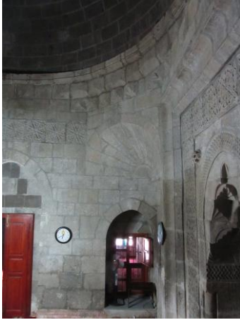
Resim 3.41. Taş Mescit kubbeye geçiş elemanı
