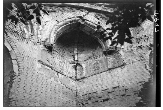
Resim 2.34. Nasr Bin Ali Türbesi kubbeye geçiş elemanı (Web iletisi 29)
