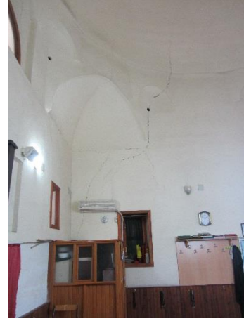
Resim 3.63. Hoca Hasan Mescidi kubbeye geçiş elemanı
