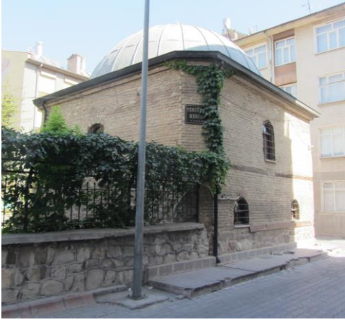
Resim 3.74. Tercüman Mescidi güney batı cephesi
