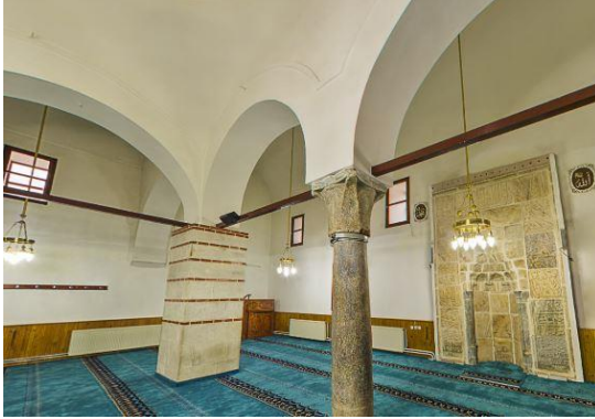
Resim 2.18. Tokat Garipler Cami kubbeye geçiş elemanı (Web iletisi 15)
