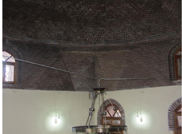
Resim 3.136. Sırçalı Mescit kubbeye geçiş elemanı
