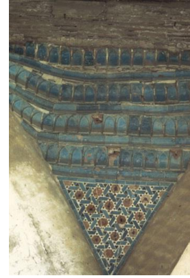
Resim 2.62. Selçuk İsa Bey (Cami kubbeye geçiş elemanı (Web iletisi 53)
