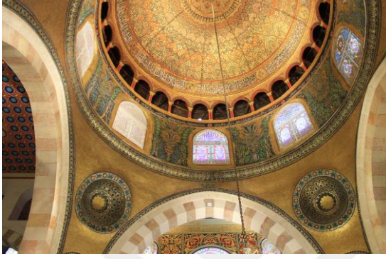
Resim 2.16. Mescid-ül Aksa'nın kubbeye geçiş elemanı (L.Danışık)
