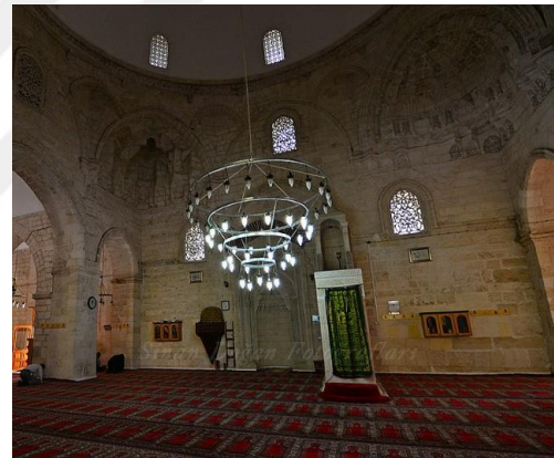
Resim 2.41. Silvan Ulu Cami kubbeye geçiş elemanı (Web iletisi 36)
