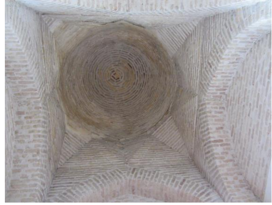
Resim 3.145. Tahir ile Zühre Mescidi türbe bölümü kubbeye geçiş elemanı
