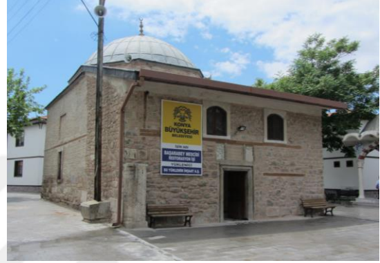
Resim 3.45. Başarabey Mescidi kuzey doğu cephesi
