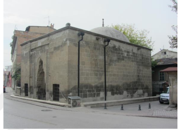
Resim 3.38. Taş Mescit kuzey doğu cephesi
