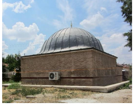
Resim 3.88. Aksinne Mescidi kuzey-doğu cephesi
