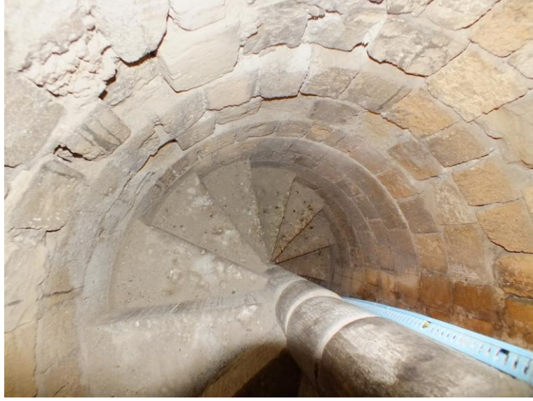
Fotoğraf 261 : İskenderun Kaptanpaşa Cami Minaresi Çekirdek ve Basamaklar
