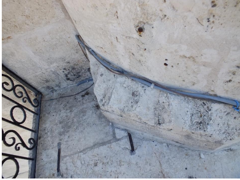
Fotoğraf 55: İhsaniye Cami Minaresi Kuzeybatı Cephe Pabuç Detay
