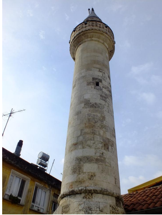
Fotoğraf 176: Affan Cami Minaresi Gövde Güneydoğu Cephe
