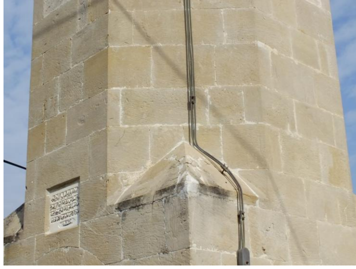
Fotoğraf 265: Altınözü Fadikli Cami Minaresi Pabuç Güneybatı Cephe
