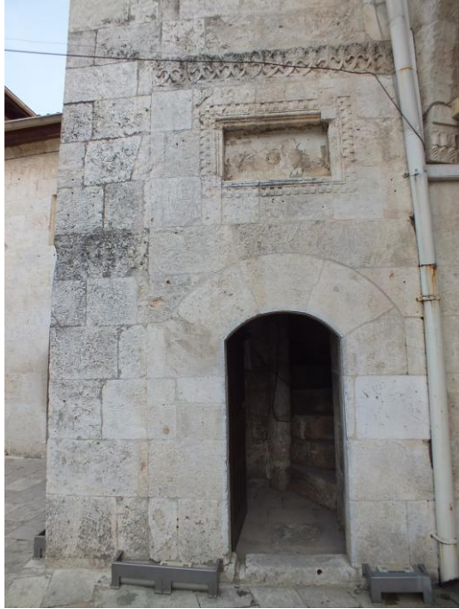
Fotoğraf 140: Habib-i Neccar Cami Minaresi Kaide Batı Cephe
