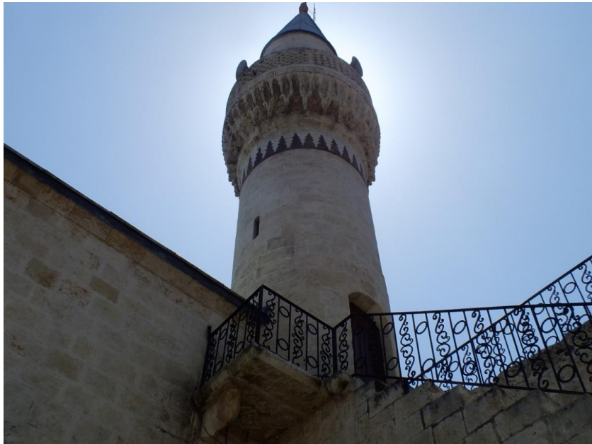
Fotoğraf 56: İhsaniye Cami Minaresi Gövde Kuzeybatı Cephe Görünüşü
