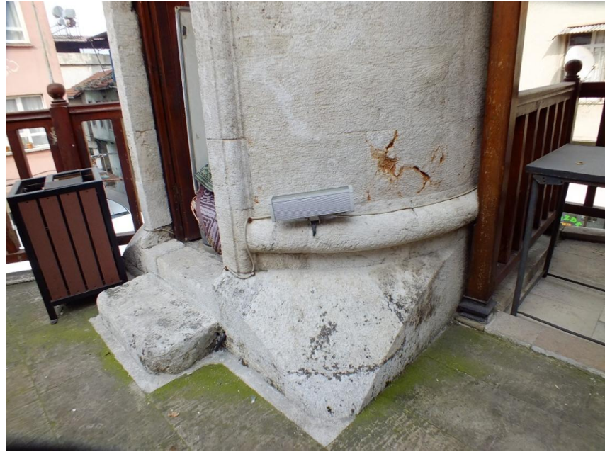
Fotoğraf 84: Şeyh Muhammed Cami Minaresi Pabuç Güneydoğu Cephe
