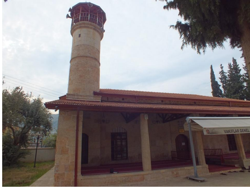
Fotoğraf 276: Reyhanlı Yenişehir Cami Minaresi Kuzey Giriş Cephesi
