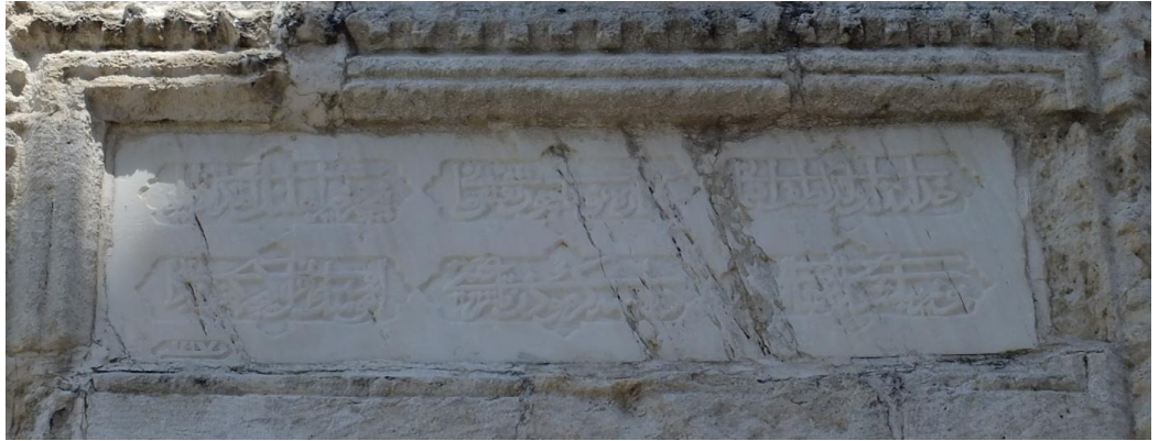
Fotoğraf 110: Ulu Cami Minaresi Kaide Gney Cephe Kitabe
