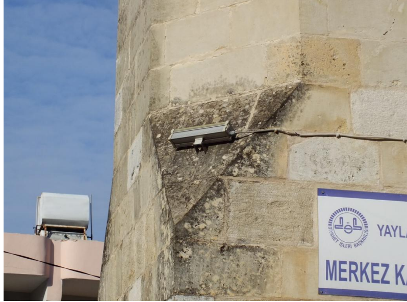
Fotoğraf 222 :Yayladağı Kasım Bey Cami Minaresi Güneybatı Cephe Pabuç Detay
