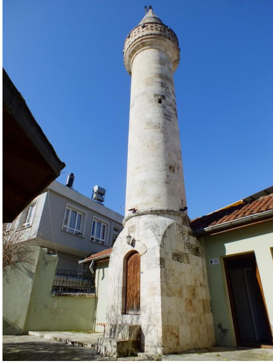
Fotoğraf 173: Affan Cami Minaresi Güneydoğu Cephe Genel Görünüm
