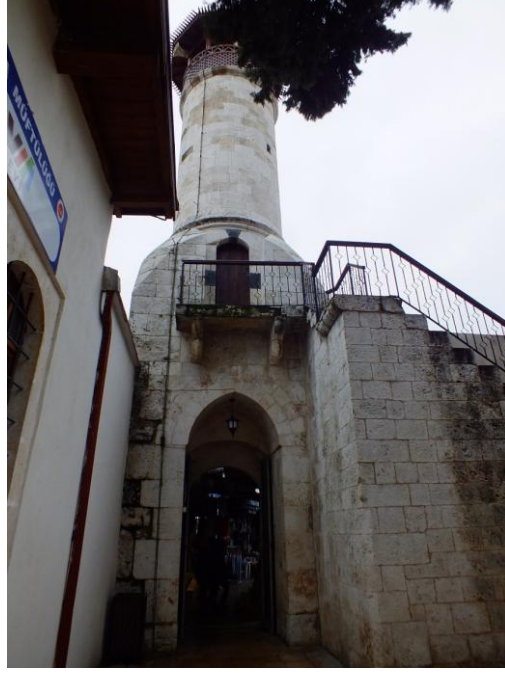
Fotoğraf 161 : Meydan Cami Minaresi Batı Cephe Genel Görünüm
