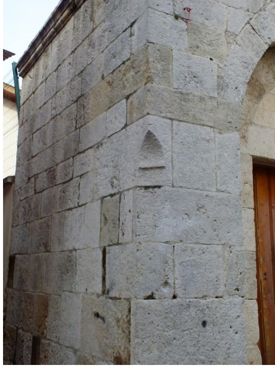
Fotoğraf 151: Şekercik Cami Minaresi Kaide Kuzeydoğu Cephe Süsleme Detayı
