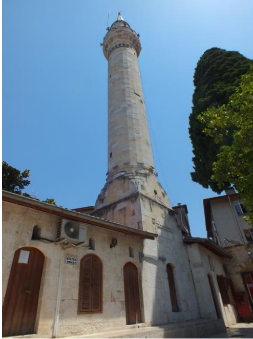
Fotoğraf 112: Ulu Cami Minaresi Güneybatı Cephe Genel Görünüm
