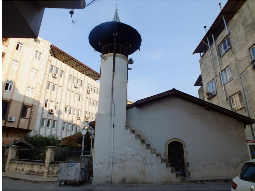
Fotoğraf 270: Samandağ Ebu'l Fütuh Cami Minaresi Batı Cephe Genel Görünüm
