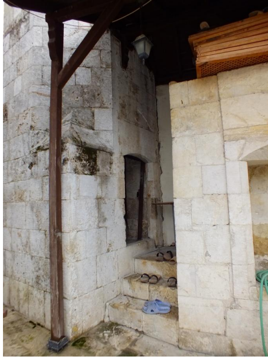
Fotoğraf 34 : Kiremitli Cami Minaresi Kuzey Cephe Minare Giriş Kapısı
