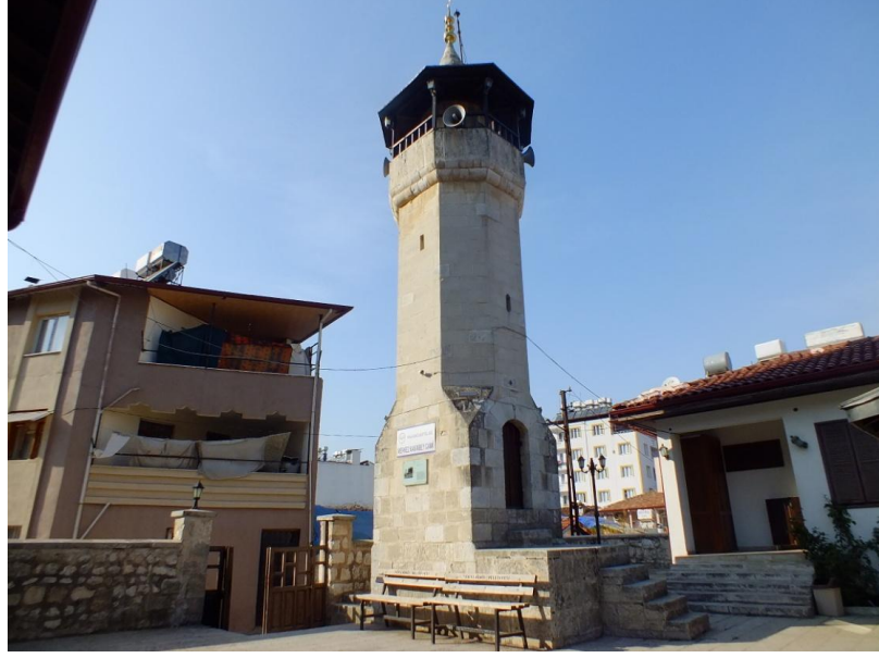
Fotoğraf 221: Yayladağı Kasım Bey Cami Minaresi Güneydoğu Cephe Genel Görünüm
