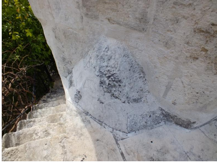
Fotoėraf 129: Sofular Cami Minaresi Papu Kuzeydoėu Cephe
