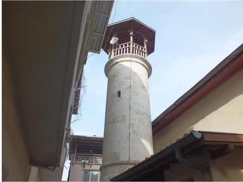
Fotoğraf 196: Osmaniye Cami Minaresi Güneybatı Cephe Gövde Görünüşü
