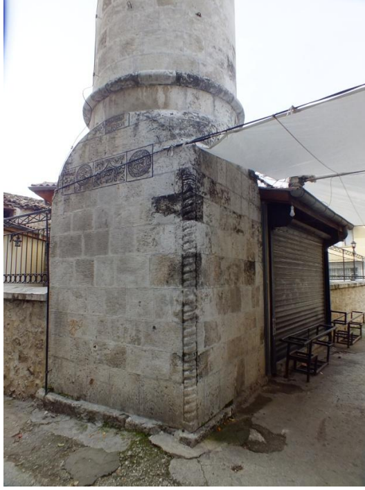
Fotoğraf 187: Orhanlı Cami Minaresi Kaide Kuzeydoğu Cephe
