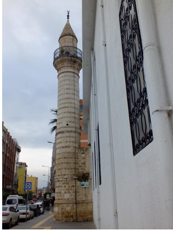
Fotoğraf 255: İskenderun Kaptanpaşa Cami Minaresi Kuzey Cephe Genel görünüm
