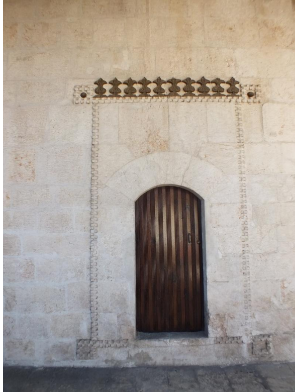
Fotoğraf 48: Yeni Cami Minaresi Kuzey Cephe Giriş Kapısı
