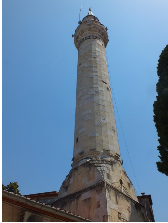
Fotoğraf 118: Ulu Cami Minaresi Gövde Güneydoğu Cephe Genel Görünü
