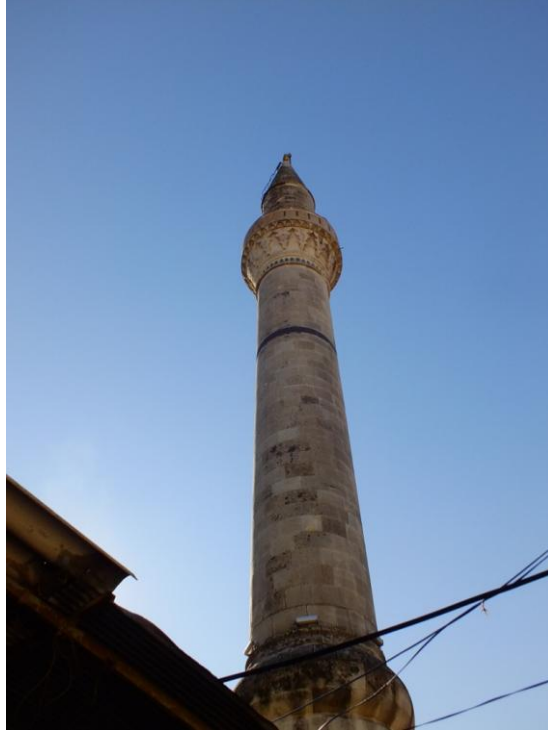
Fotoğraf 214: Halil Ağa Cami Minaresi Gövde Güneydoğu Cephe
