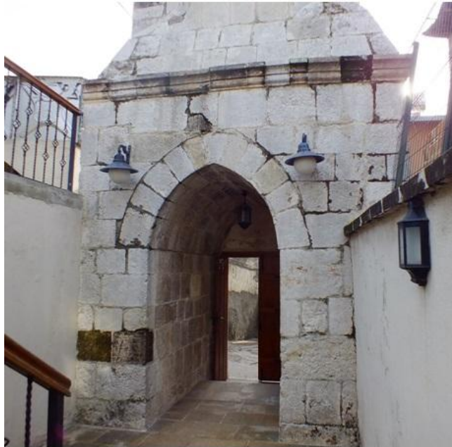
Fotoğraf 152: Şekercik Cami Minaresi Kaide Güney Cephesi ve Tonz Detayı
