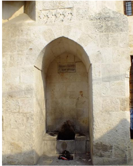
Fotoğraf 14: Kantara Cami Minaresi Kaide Batı Cephe
