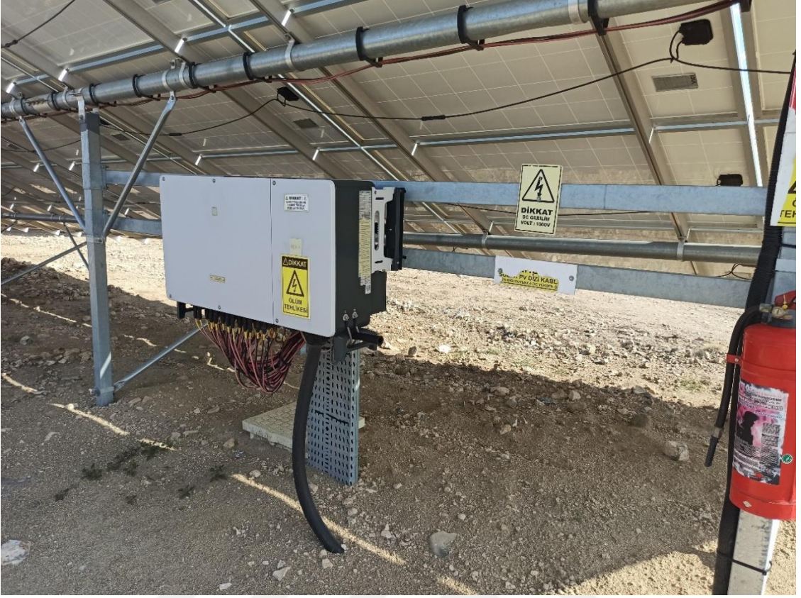
Şekil 4.11. Santral inverter konumlandırılması.
