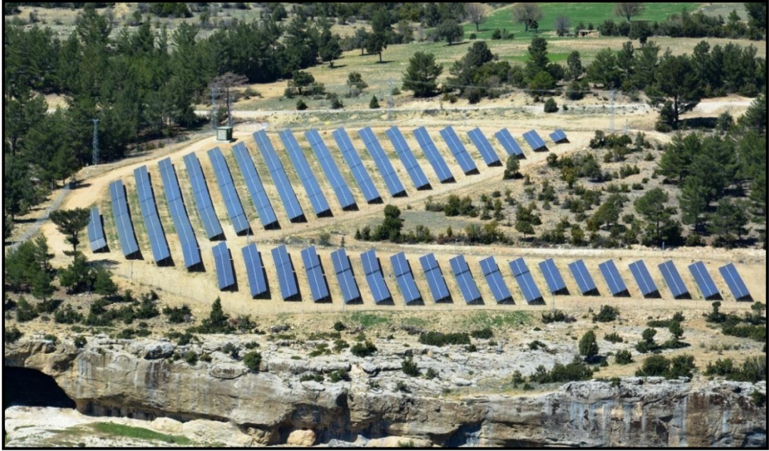
Fotoğraf-84: Çömelek Mahallesi Sınırları İçerisindeki Güneş Enerjisi Panelleri
