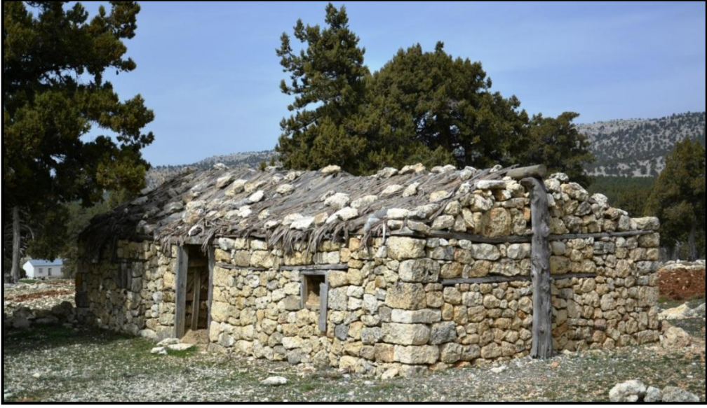
Fotoğraf-62: Örtü Gereci Olarak Ardıç Kabuğu Kullanılan Yayla Evi
