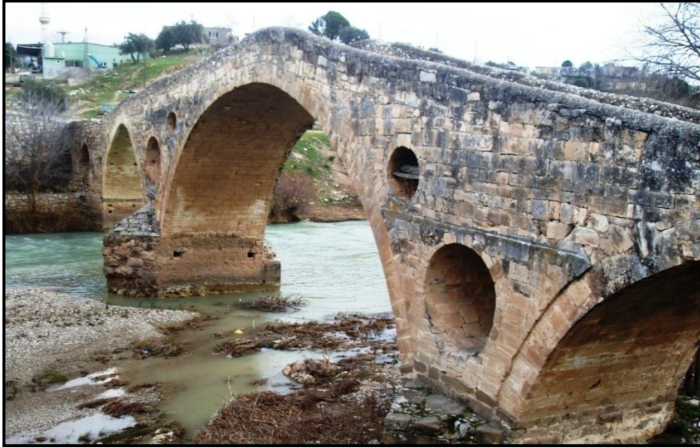
Fotoğraf-23: Göksu Mahallesi'nde Yer Alan Kıravga Köprüsü
