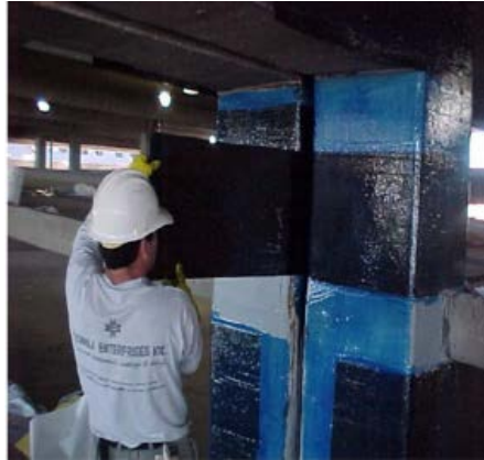
Şekil 3.16. Kolonun LP ile Mantolanması Uygulaması
