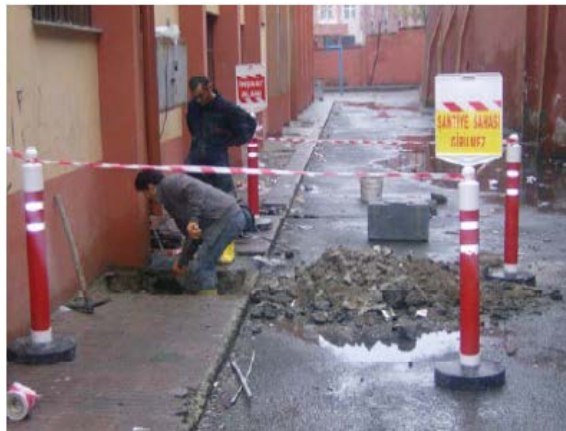
Şekil 3.1. Bina Temelinde İnceleme Çukuru Açılması
