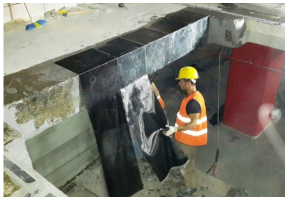
Şekil 3.18.Kirişlerin LP Sarılarak Güçlendirilmesi (Web İletisi 4)
