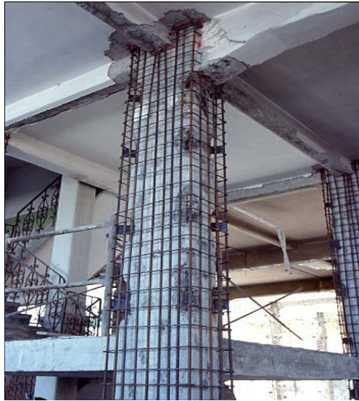
Şekil 3.12. Kolonun Betonarme ile Mantolanması Uygulaması
