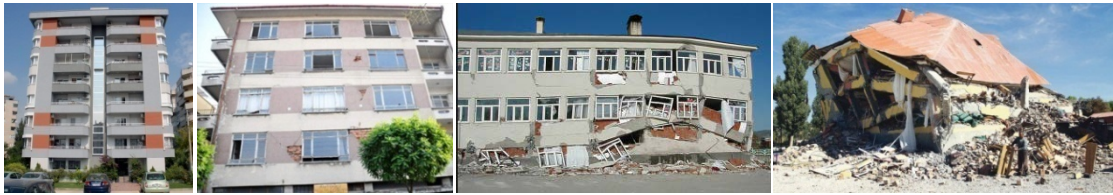
Hemen Kullanım (HK) Göçme Öncesi (GÖ) Göçme Durumu (G) Can Güvenliği (CG)
