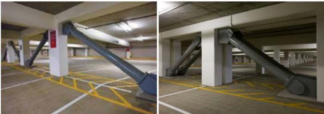
Şekil 3.20. Çelik Diyagonal Elemanlarla Güçlendirme (Balık, 2012)
