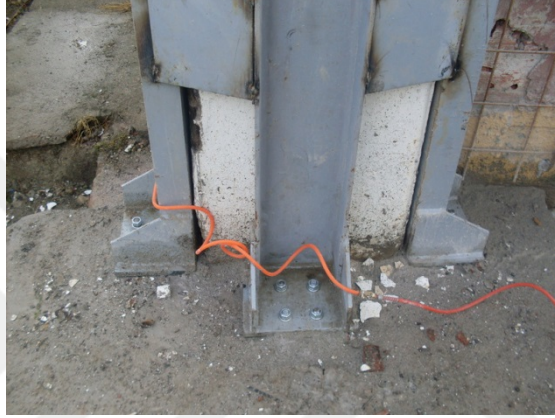
Şekil 3.15. Kolonun Çelik Mantolanması Uygulaması (Web İletisi 3)
