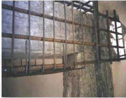
Şekil 3.17.Kirişin Betonarme ile Mantolanması Uygulaması(Yıldırım, 2008)
