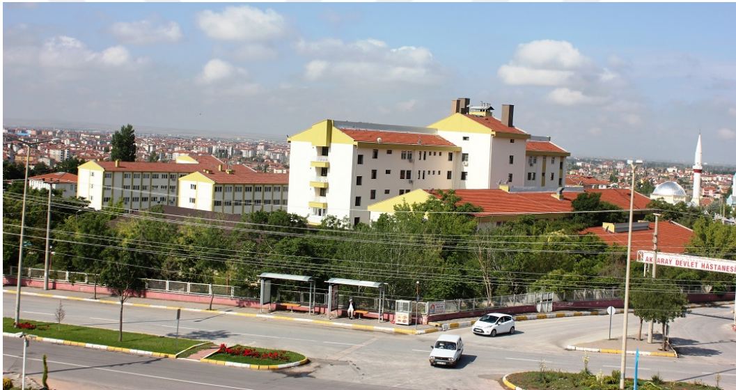
Şekil 5.31. Aksaray Devlet Hastanesi Genel Görünüşü
