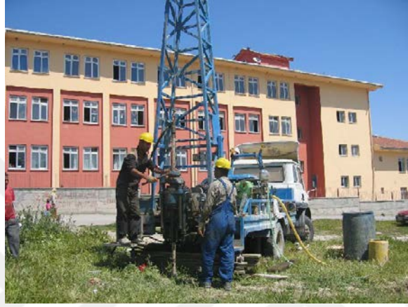
Şekil 3.2.Zemin Özelliklerinin Belirlenmesi İçin Geoteknik Etüt Yapılması (Web İletisi 1)
