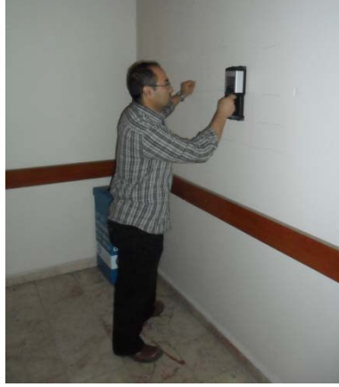
Şekil 3.3. Ferroskan Cihazı ile Betonarme Duvar Yüzeyinde Tarama Yapılması (Köken., A. Arşivi)
