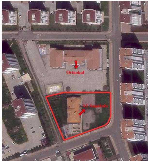
Şekil 3.2. A1 anaokulu binasının yakın uydu fotoğrafı (URL-1, 2025)
