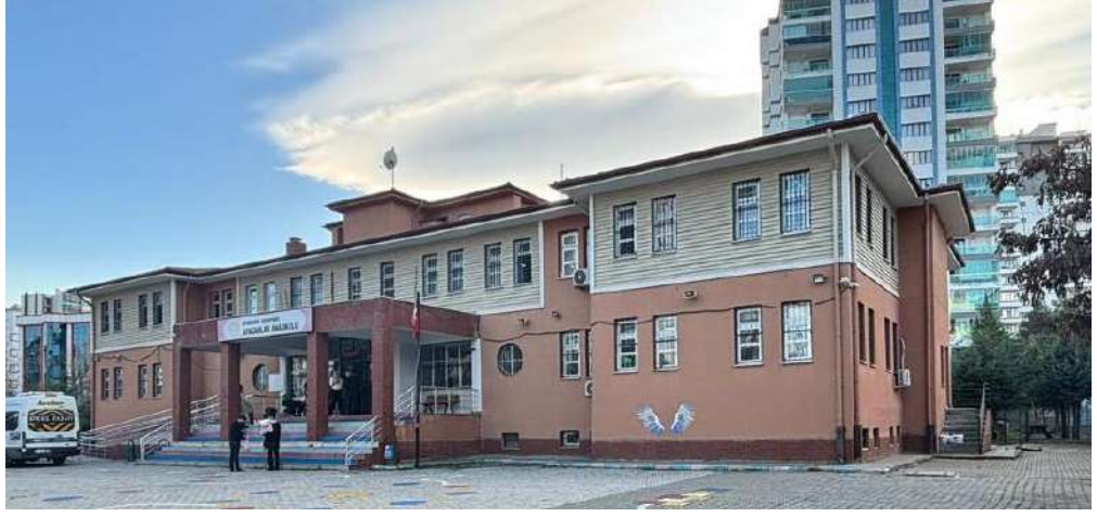
Şekil 3.3. A1 anaokulu binasının dış görünüşü
