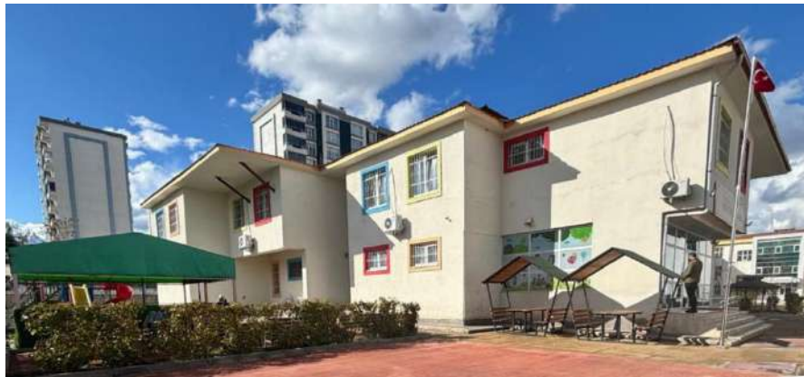
Şekil 3.14. A3 Anaokulu binasının dış görünüşü
