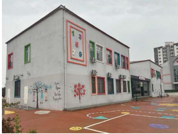
Şekil 3.9. A2 anaokulu binasının dış görünüşü
