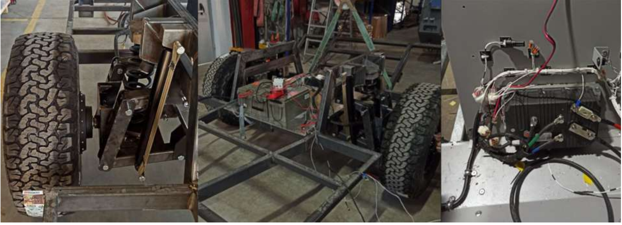
Şekil 4.3. Elektrikli Karavan HUB Motor Ve Elektrik Motor Sürücüsü Montajı
