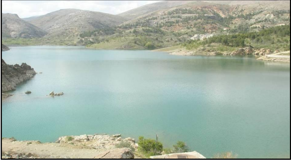
Fotoğraf 5. Sille Barajı'nın güneyden görünüşü
