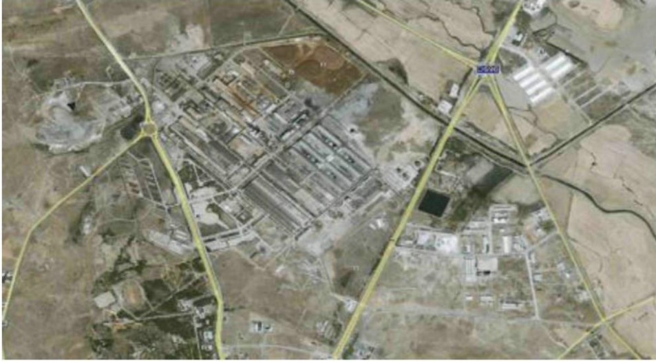
Şekil 4.1. Seydişehir ETİ Alüminyum Tesisleri
