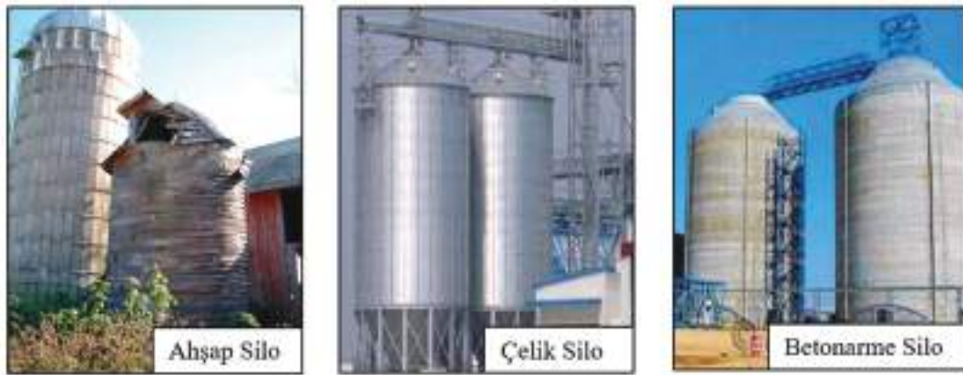
Şekil 3.7 Farklı malzemeler kullanılarak imal edilmiş silolar (Kibar, 2011)
