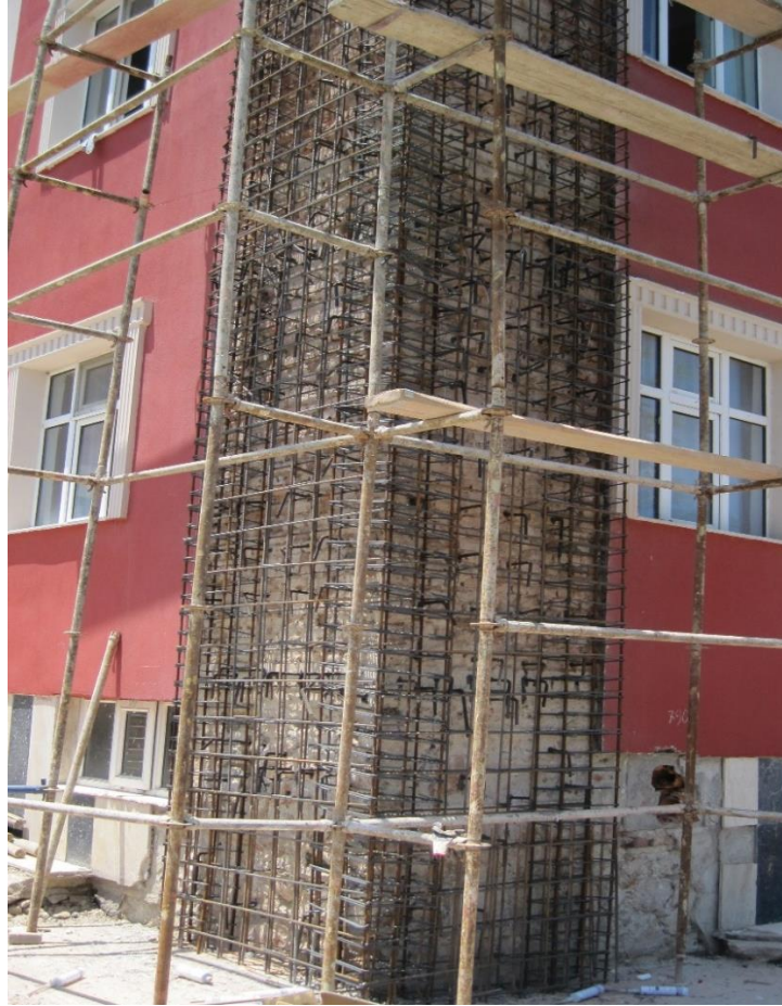
Şekil 4.6 Perde duvarın donatı ve ankrajlarının görüntüsü
