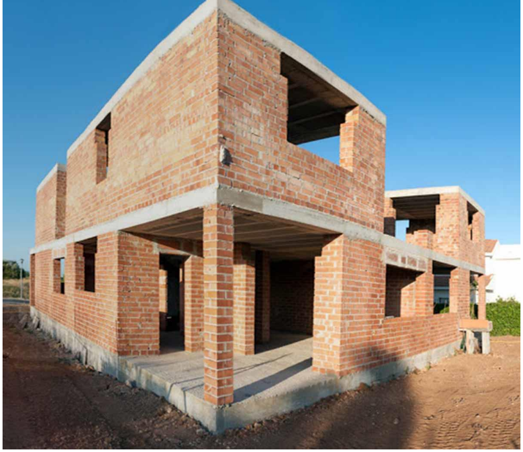
Şekil 3.4 Donatısız yığma yapı örneği (Web İletisi- Yığma Yapı Nedir? Yığma Bina Çeşitleri ve Özellikleri (insapedia.com) )
