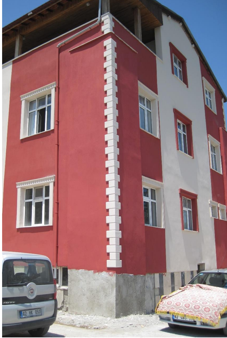
Şekil 4.7 Yapıya güçlendirme aşamasında eklenmiş perde duvarın son hali
