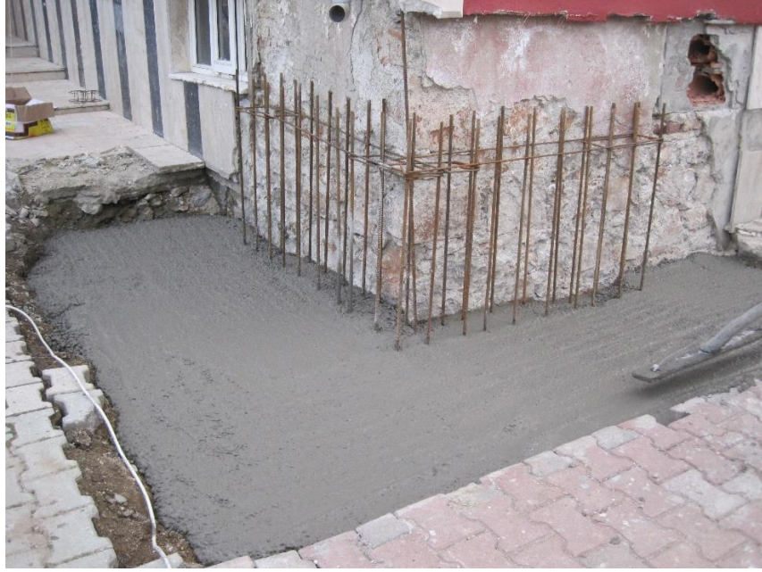
Şekil 4.2 Perde temel beton dökümü
