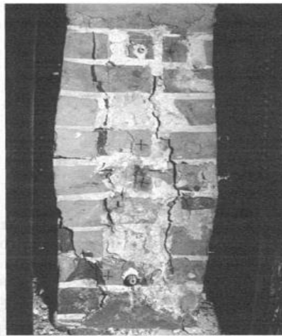
Şekil 3.18 Yığma bir yapıdaki basınç kırılması (Carbone, Fiore, Pistone, 2001)
