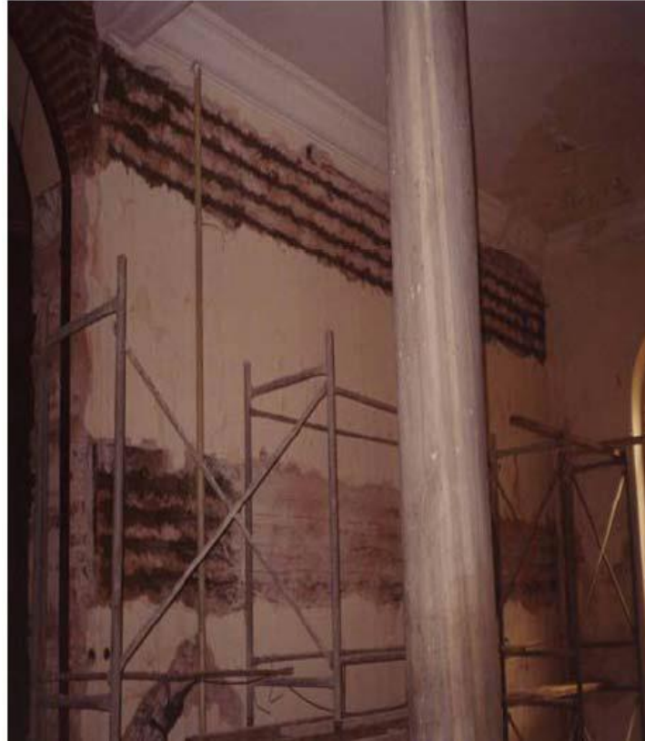
Şekil 3.41 Duvar hatıl bölgesinde FRP uygulaması (Bayraktar,2005)
