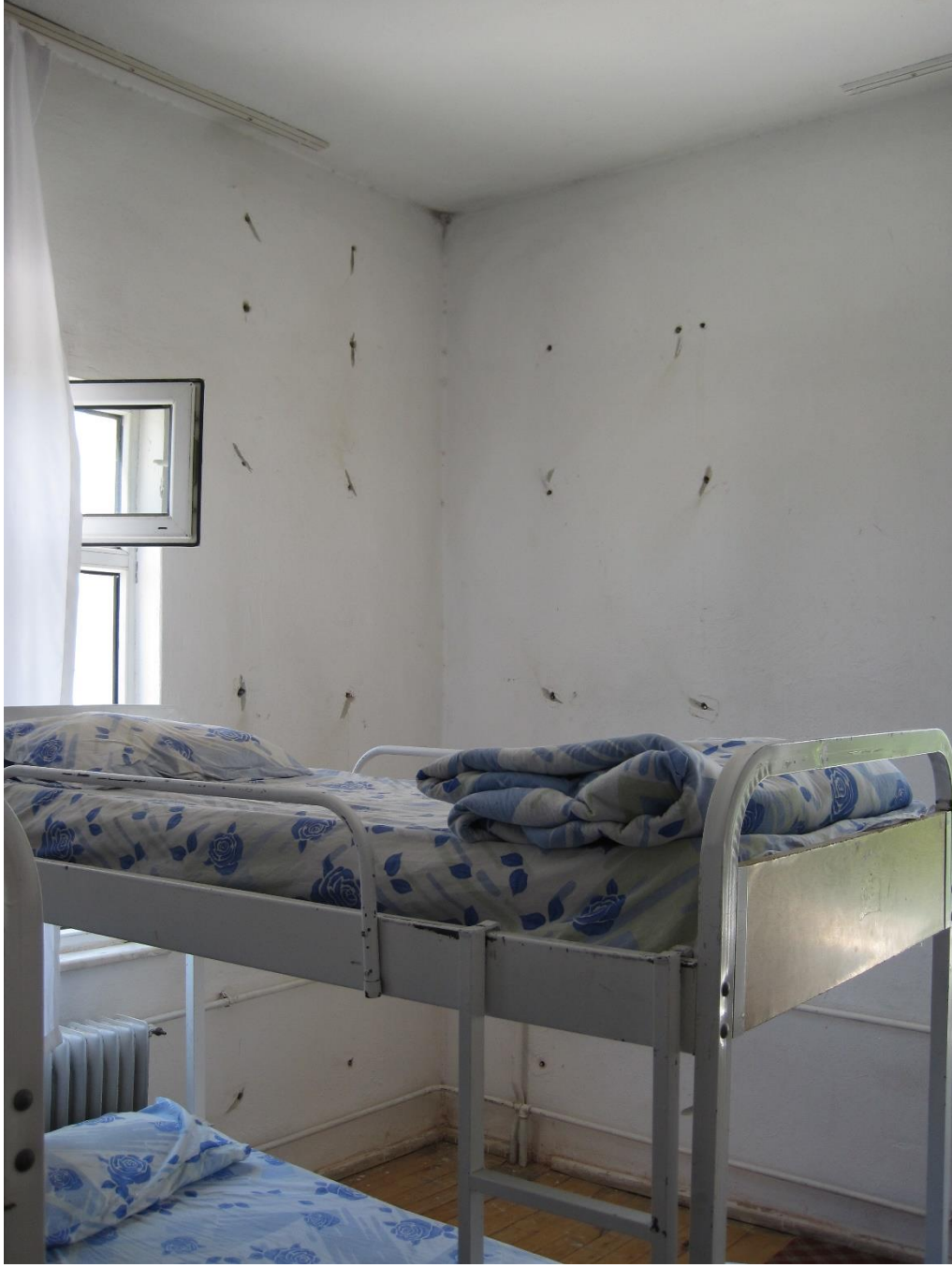
b) Köşe duvarda açılan örnek ankraj delikleri Şekil 4.4 Yapıda açılan ankraj delikleri örnekleri
