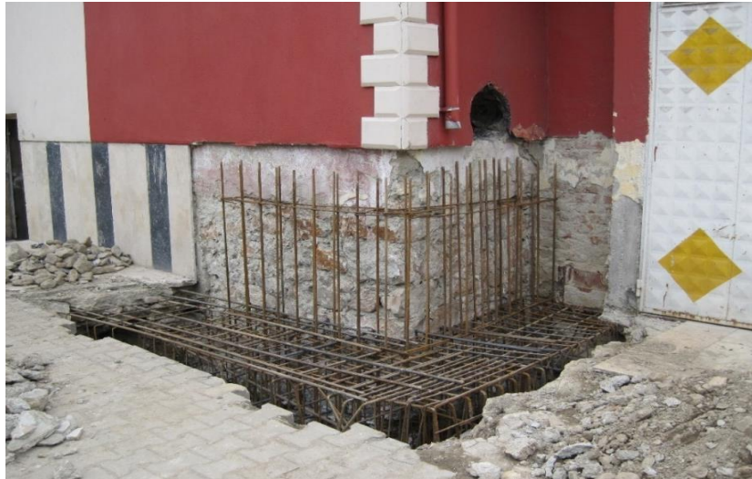
a) Perde duvar donatılarının görüntüsü
