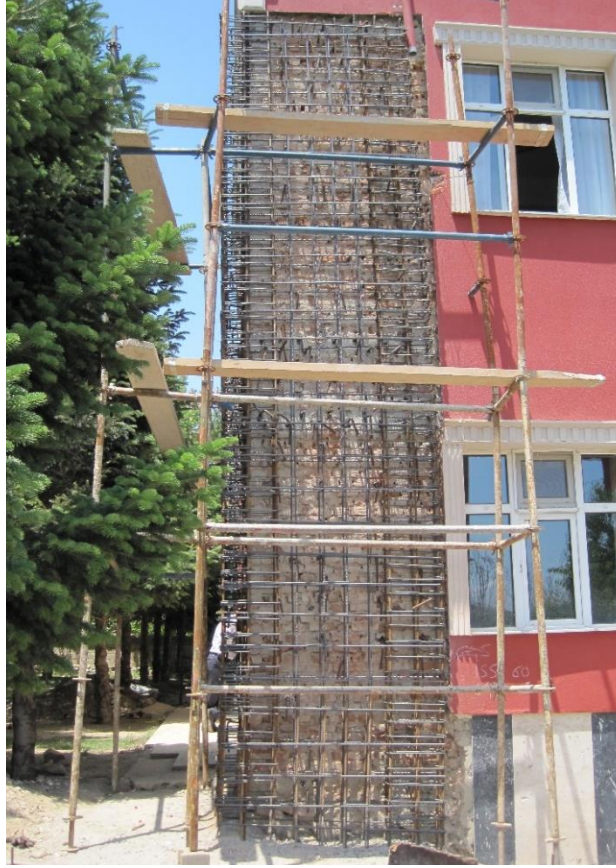
Şekil 4.63 Perde duvarın mevcuttaki durumu
