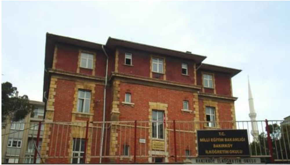
Şekil 3.1 Örnek yığma yapı ( Öztaş,2009)
