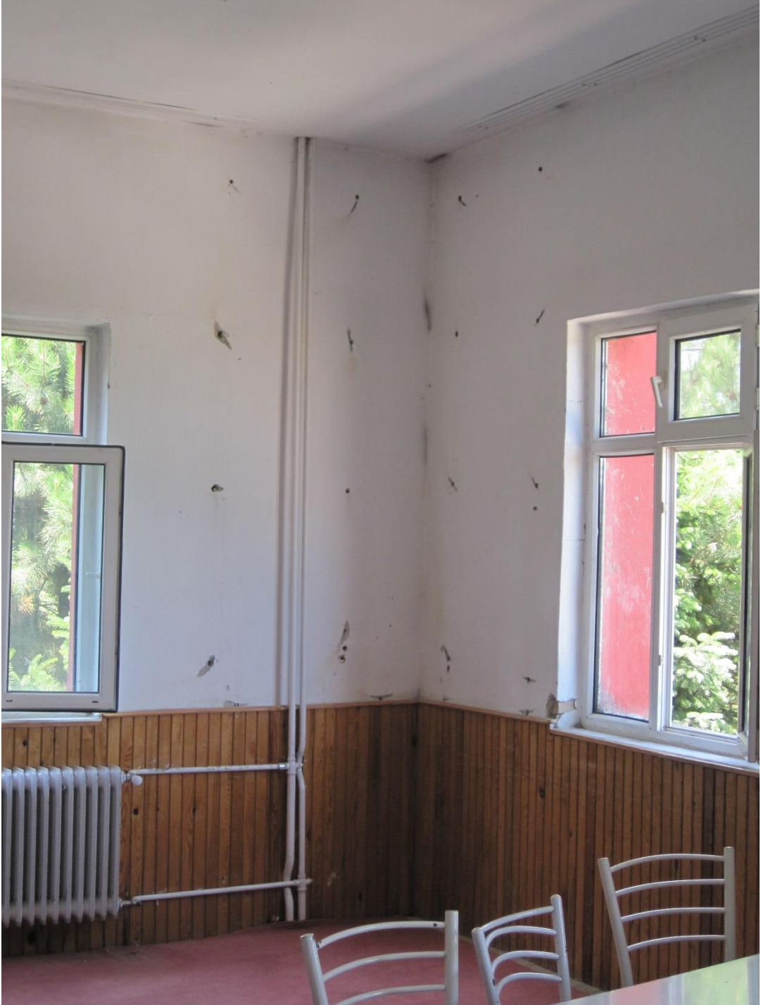
a) Köşe duvarda açılan örnek ankraj delikleri
