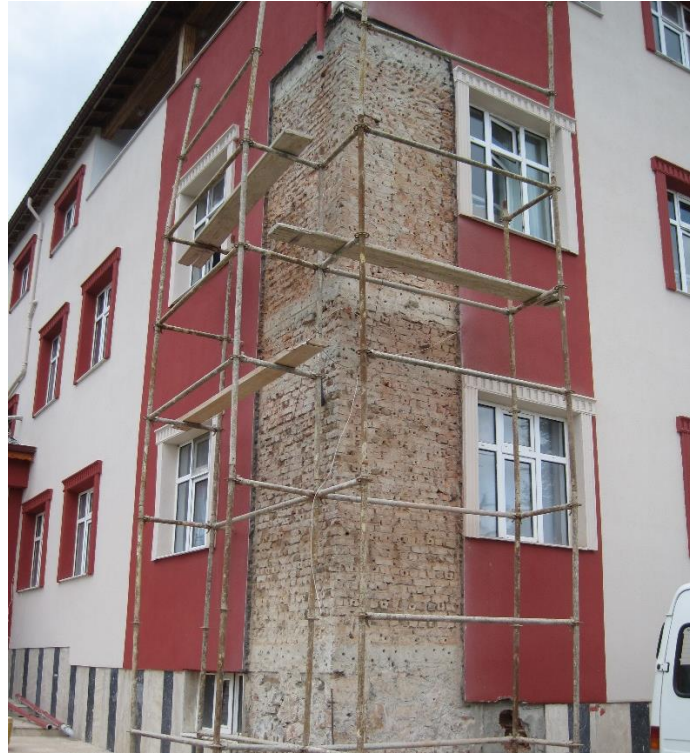
Şekil 4.3 Mevcutta sıvanın kaldırılması
