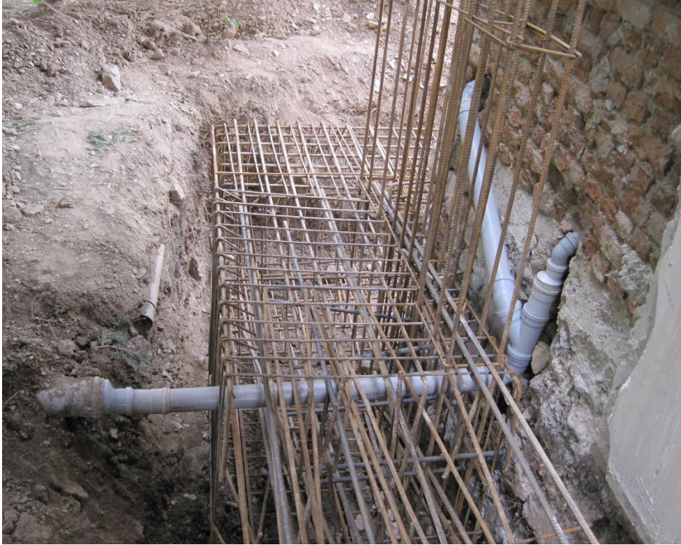
c) Perde duvar donatılarının bağlantısı
