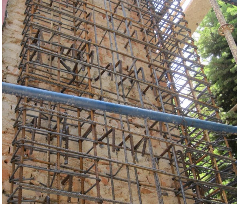
Şekil 4.5 Ankrajların ve donatıların yerleştirilmiş görüntüsü
