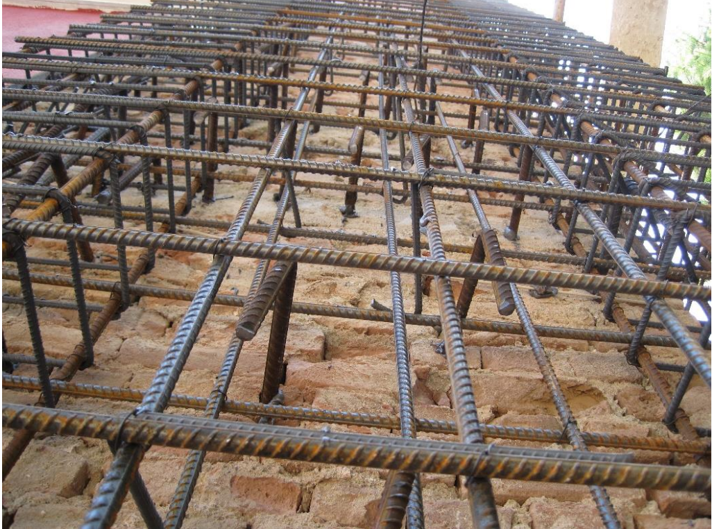
b) Ankraj ve perde duvar bağlantısı
