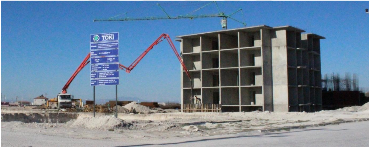
Fotoğraf 31. Sultanhanı İlçesinde TOKİ 1. Etap Konutları İnşaat Aşamasından Bir Görünüm
