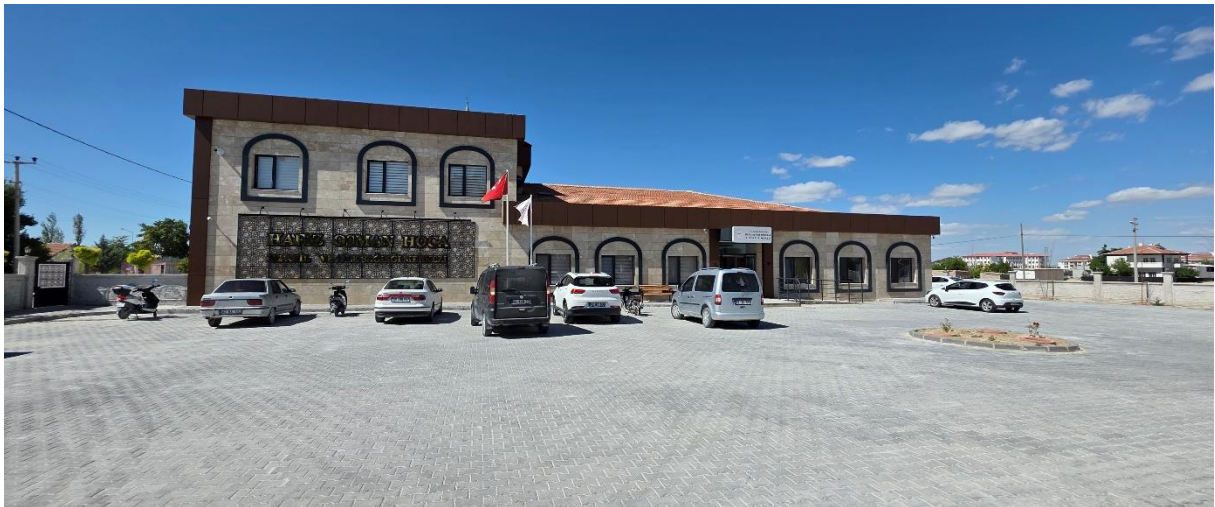
Fotoğraf 41. Sultanhanı Hafız Osman Yumuşak Aile Sağlığı Merkezi
