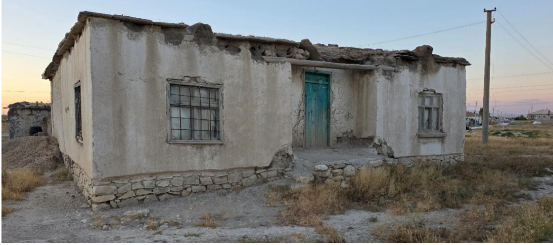
Fotoğraf 30. Sultanhanı İlçesi Kırsalında Geleneksel Mimariye Sahip Kerpiç Mesken Örneği
