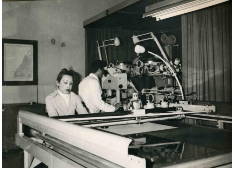
Şekil 3.15 1970 Yılında Zeiss C-8 Aletiyle Fotogrametrik Kıymetlendirme Yapılırken (URL 2).
