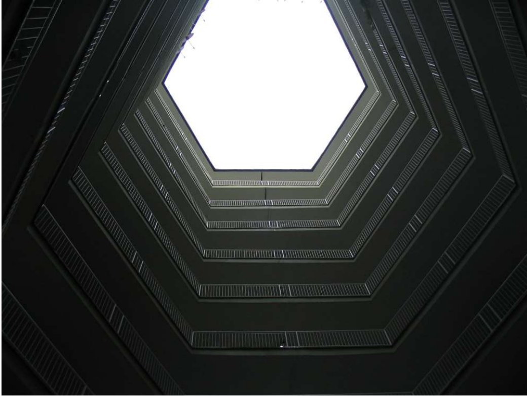
Şekil 44. Yeşiltepe Yapı Kooperatifi galeri boşluğu
