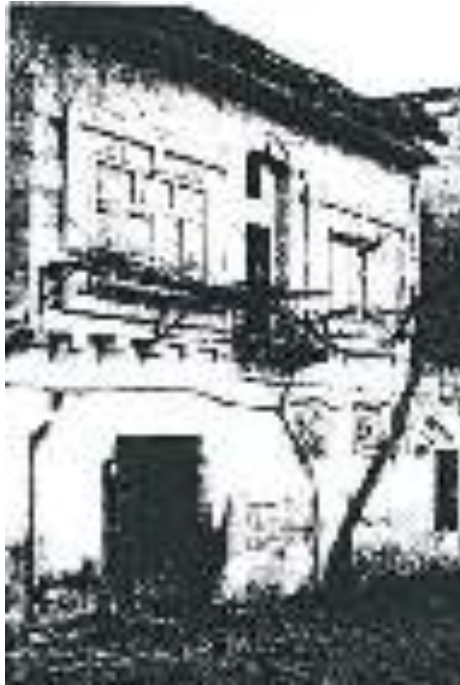
Resim 440. Geleneksel Nevşehir-Uçhisar Evlerinden Bir Evin Cephesi (Gonca Büyükmihçi'dan)
