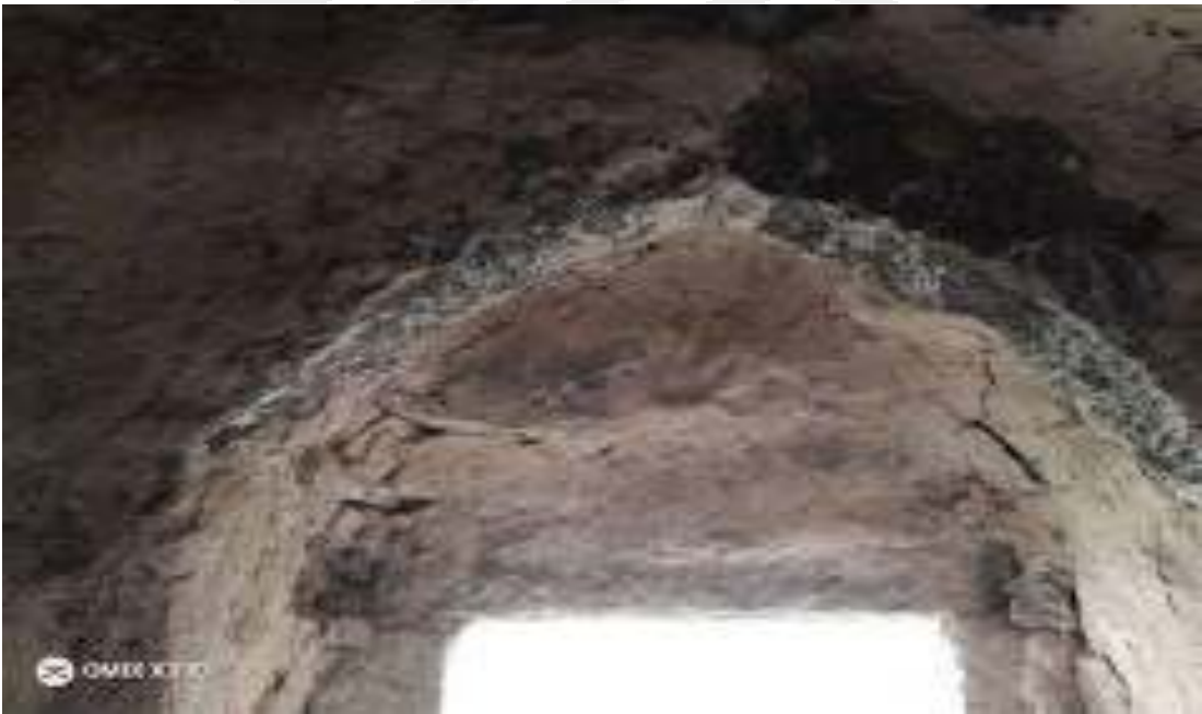
Resim 67.-68. 8 No.lu Ev Sivri Kemerli Pencere (Ömer İçirgin)
