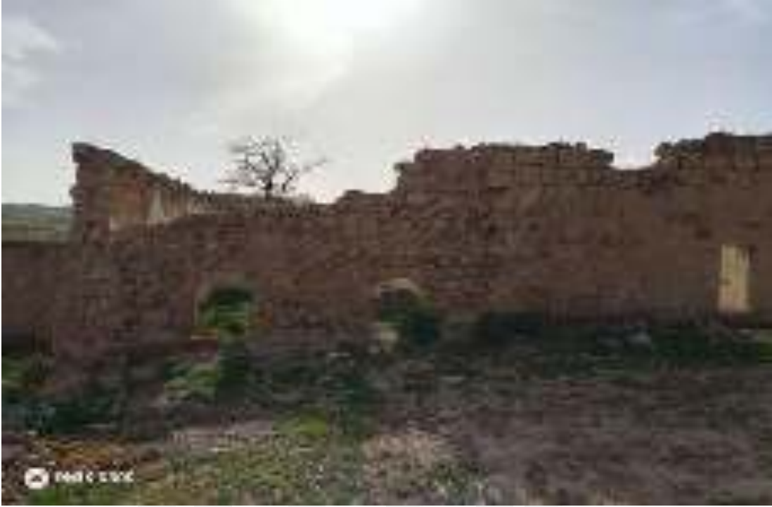
Resim 147. Kızılkaya Köyü Eski Camii Doğu Cephesi Görünümü (Ömer İçirgin)
