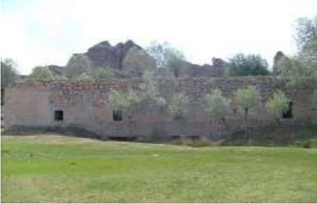
Resim 163. 1 No.lu Deęirmen Dış Cephe Görünüm (Ömer İçirgin)
