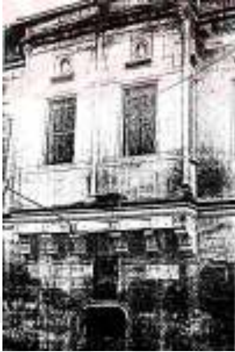
Resim 457. Aksaray Perekzadeler Konağı Çörteneri (Zekai Erdal'dan)
