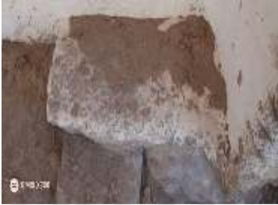
Resim 21. 1 No.lu Ev Üst Katının Sökülmüş Pabuçluk Bölümü (Ömer İçirgin)
