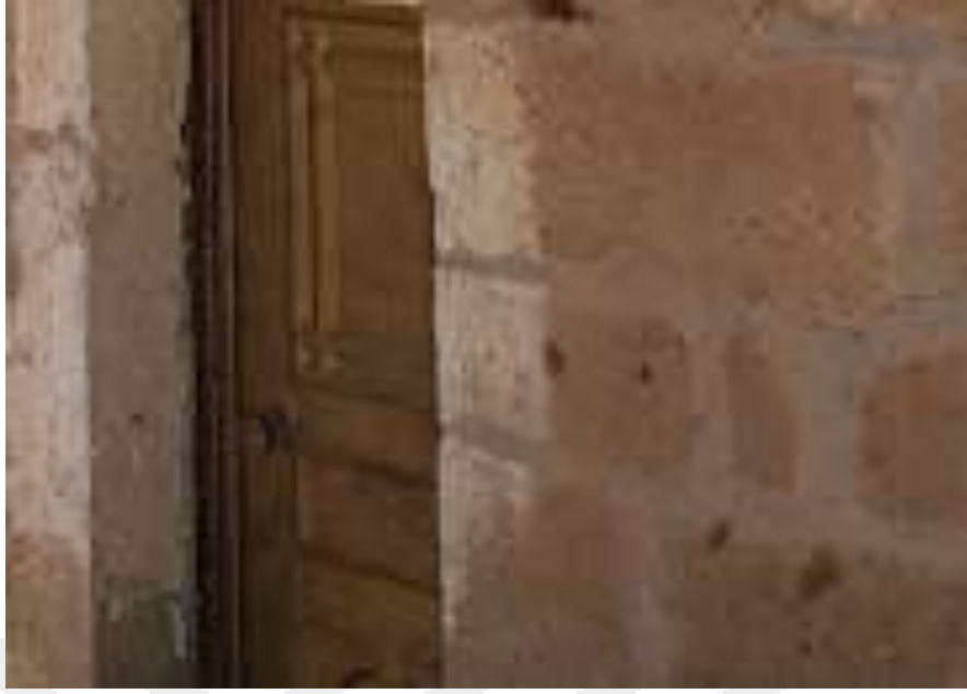
Resim 39. 4 No.lu Ev Dış Kapı (Ömer İçirgin)
