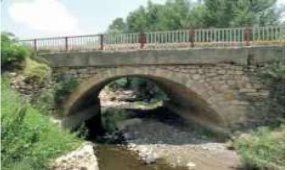
Resim 554. Konya Meram Güneydere Köyü Boğaz Köprüsü (Remzi Duran, Ali Baş ve Ruhi Özcan'dan)
