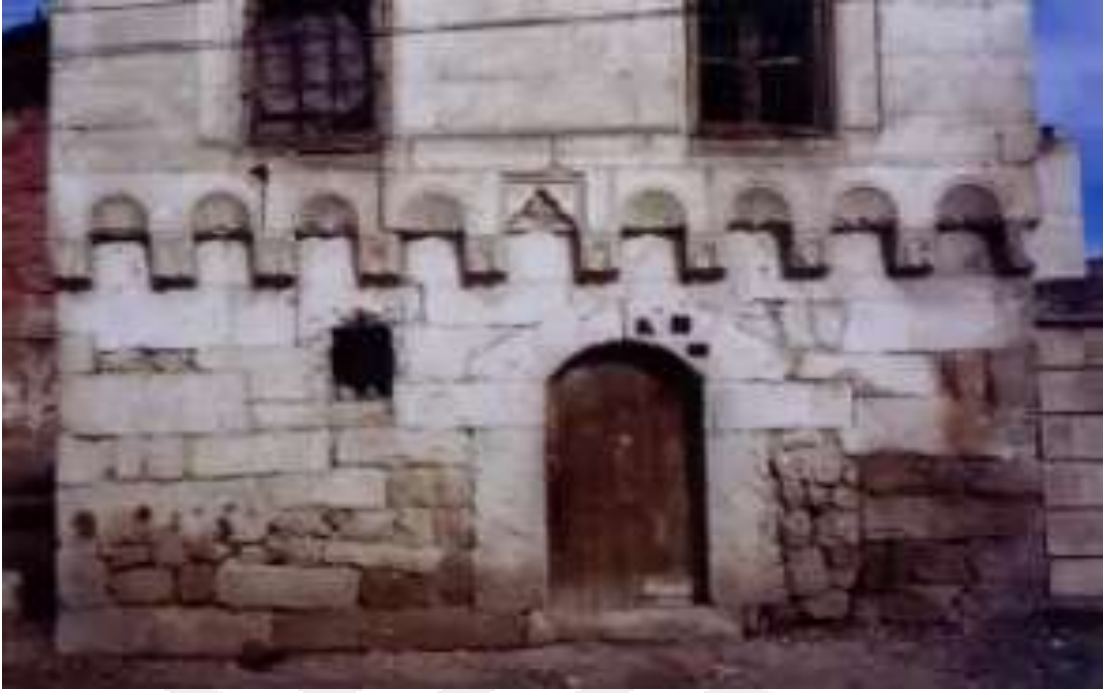
Resim 427. Avanos Alaaddin Mahallesi Sanayi Caddesi Üzerindeki 18 No.lu Ev Cephe Görünümü (Mehmet Ali Esmer'den)
