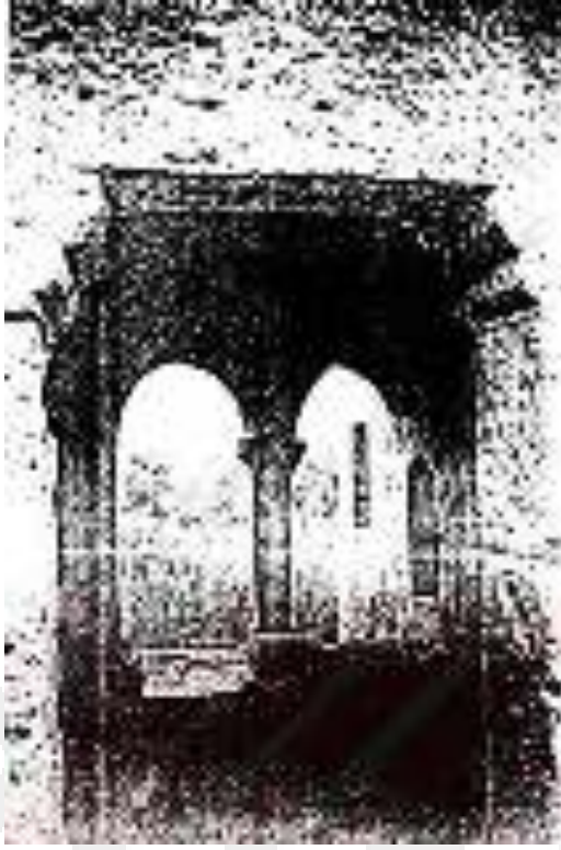
Resim 95. Bahattin Altın Evi I. Kat Divanhaneye Açılan Kuzeydeki Kapı Eski Hali (Zekai Erdal'dan)
