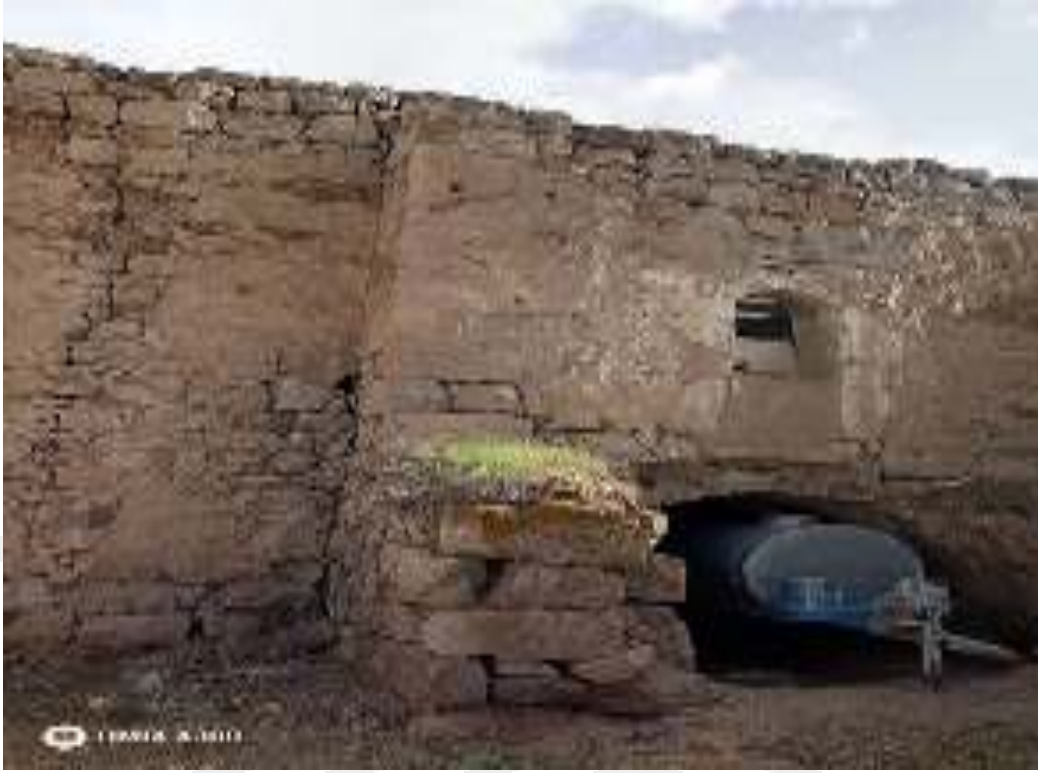
Resim 49. 5 No.lu Ev Tandır Evi Dış Cephe (Ömer İçirgin)
