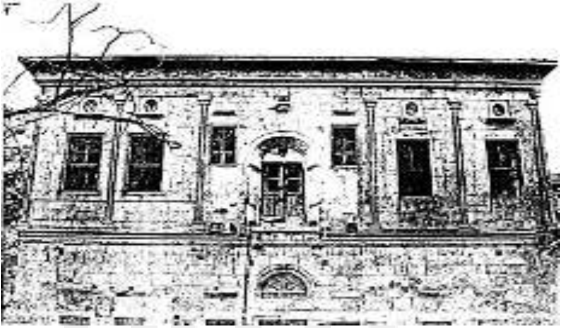
Resim 351. Aksaray Perekzadeler Konağı I.Kat Avlu Cephesi (Zekai Erdal'dan)
