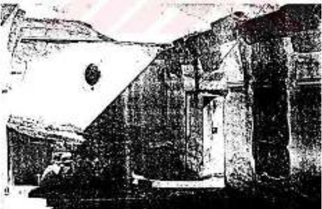
Resim 356. Güzelyurt Hamit Çak Evi I. Kat Sofasının Batıdan Görünüşü (Zekai Erdal'dan)
