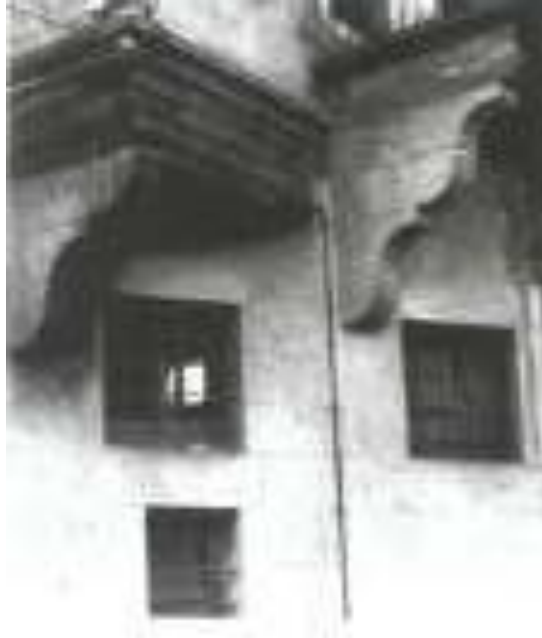
Resim 488. Kayseri Tavukçu Mahallesi'ndeki Bir Evin Üçgen Çıkmalarla Bir Köşe Çözümü (Vahit İmamoğlu'ndan)
