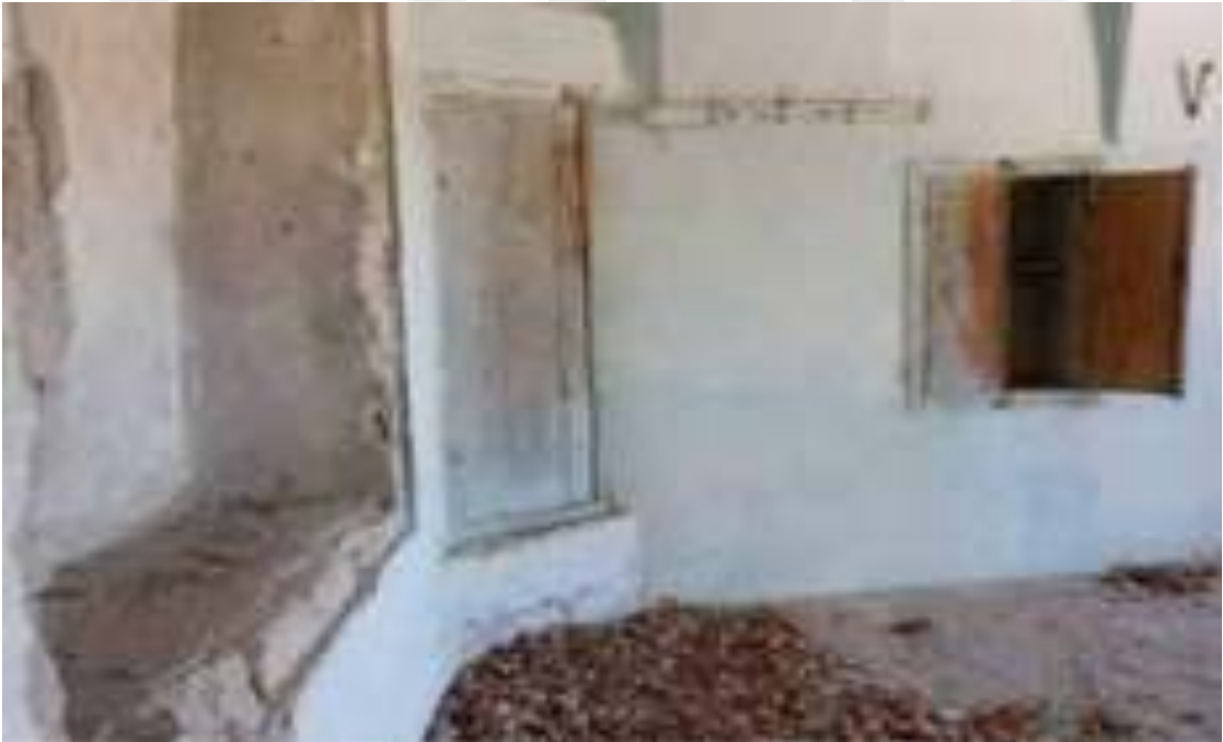
Resim 400. Demirci Osman Sarı Evi Batı Oda Gusülhane ve Gömme Dolaplar (Erkan Aygör'den)
