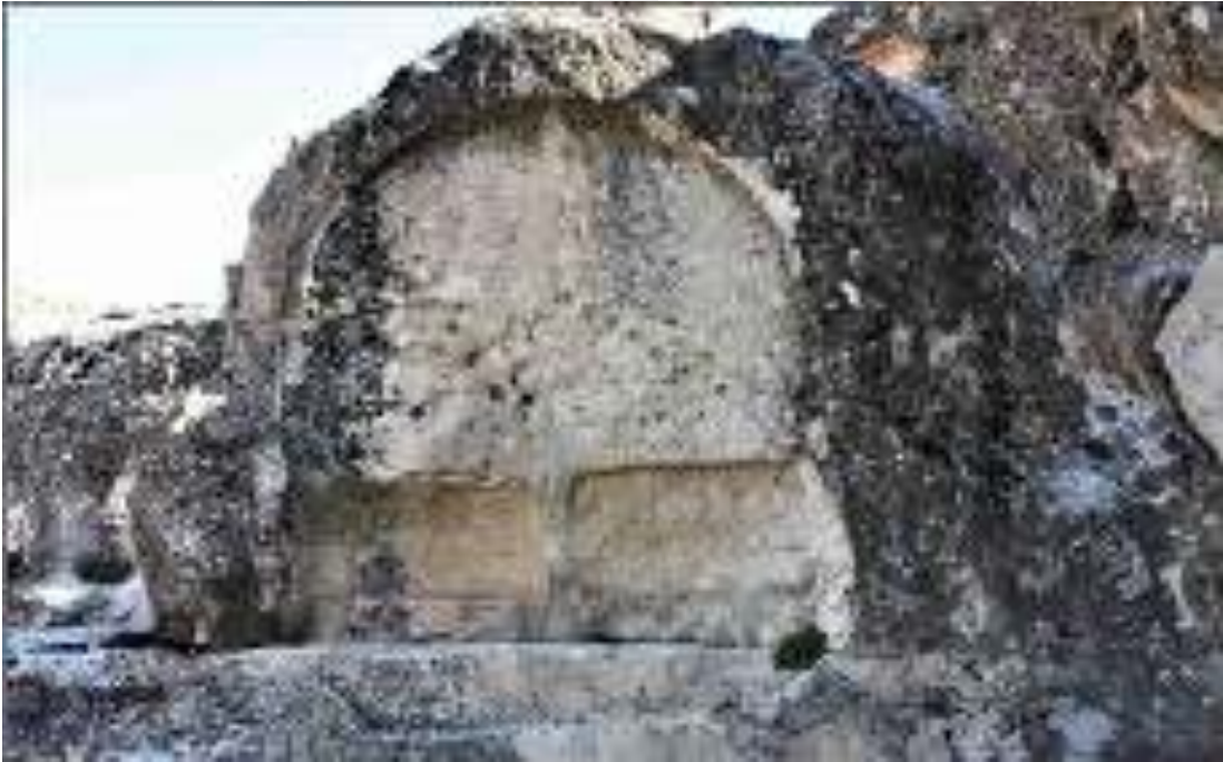
Resim 582. Hasankeyf İncirli Köyü Kaya Oyma Mekânı Tahrip Olmuş Nişi (İbrahim Çakmak'tan)
