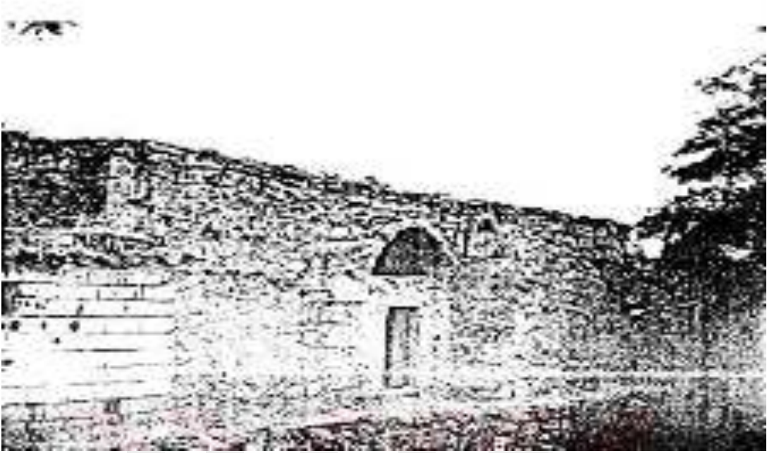
Resim 133. Ali Vurgun Evi I. Kat Odaların Bağlandığı Sofa-Yol Eski Hali (Zekai Erdal'dan)
