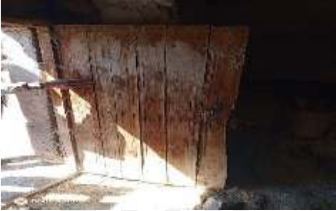
Resim 5. 1 No.lu Ev Alt Kat Samanlık ve Tandır Evi'nin Ahşap Kapısı (Ömer İçirgin)
