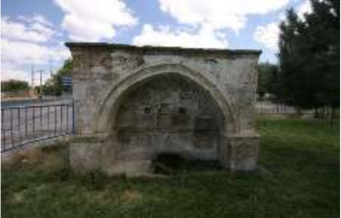
Resim 536. Aksaray Karkın Kasabası Eski Çeşme (Zekai Erdal'dan)
