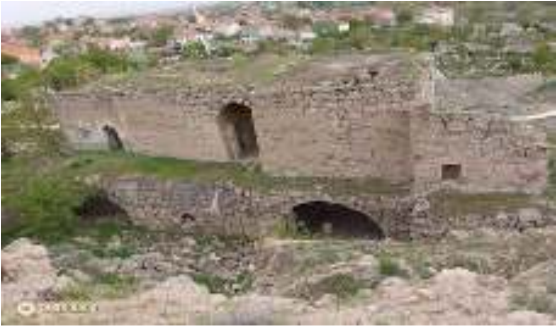
Resim 132. Ali Vurgun Evi Kuzey Cephesi'nden Görünümü (Ömer İçirgin)
