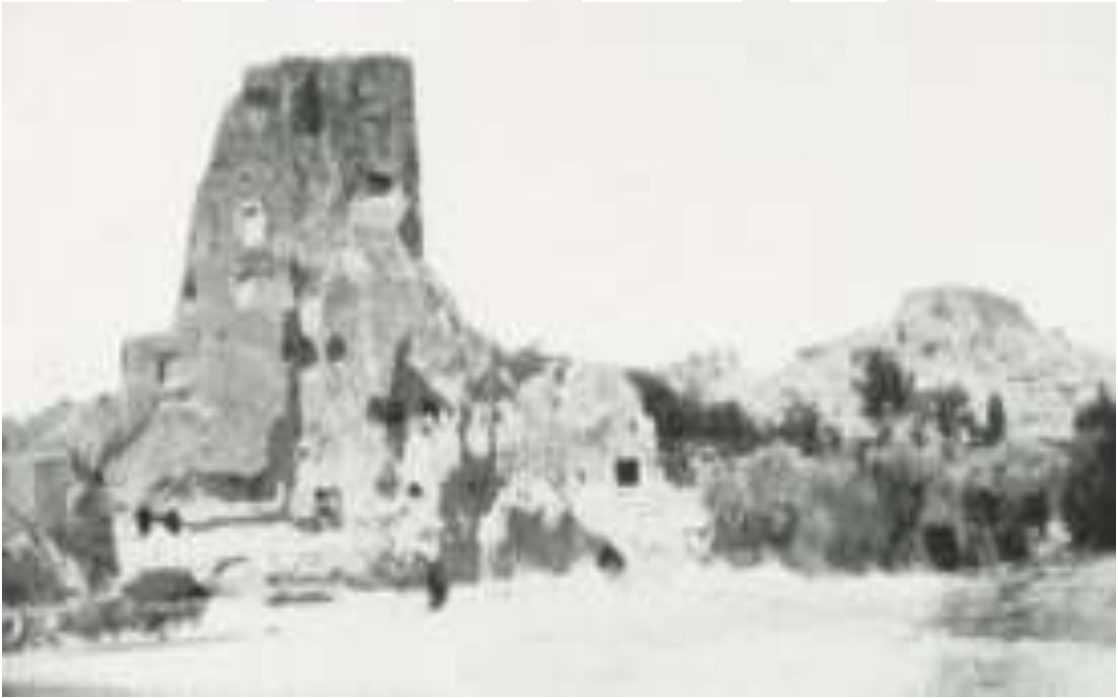
Resim 304. Ürgüp'te Kaya Oyma Tekniğiyle Yapılmış Mekânlar (H. Schweinitz'den)
