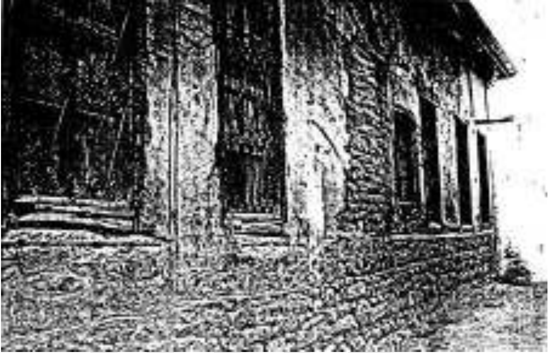
Resim 503. Aksaray Emin Bilgiç Evi Güney Cephesi (Zekai Erdal'dan)
