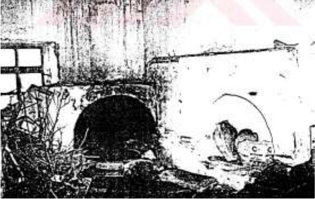
Resim 417. Aksaray Emin Bilgiç Evi Mutfağındaki Ocaklar (Zekai Erdal'dan)
