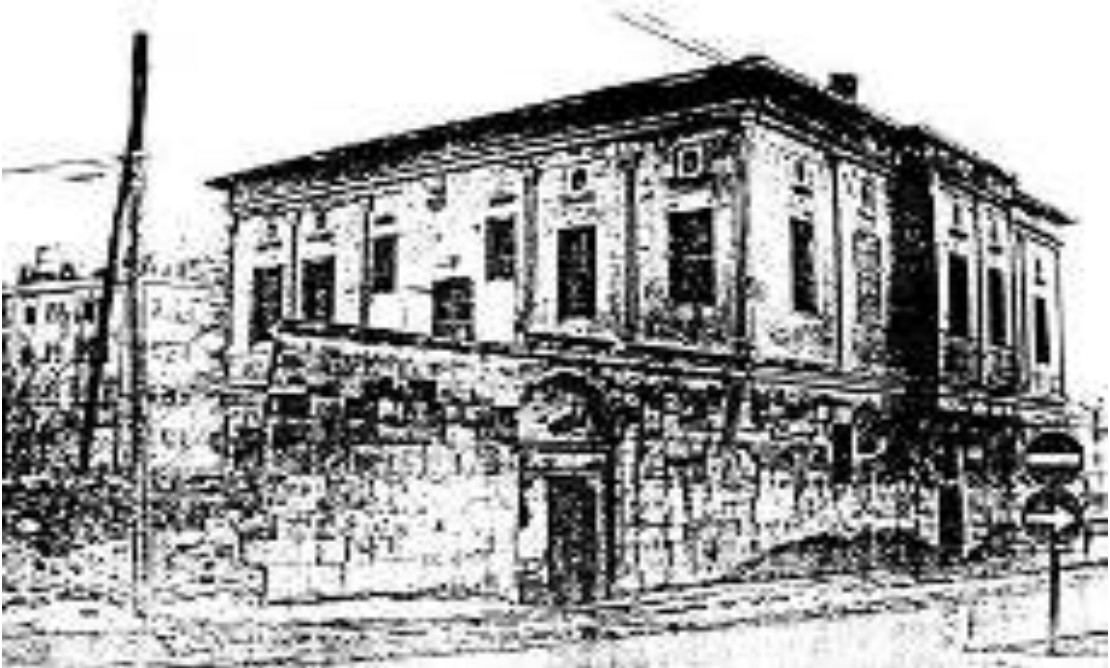
Resim 374. Aksaray Perekzadeler Konağı Genel Görünümü (Zekai Erdal'dan)
