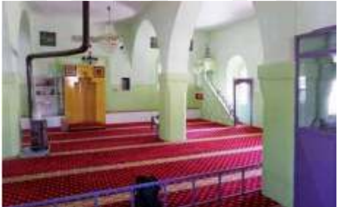
Resim 332. Demirci Bahçeli (Aşağı) Camii Düz Betonarme Tavan (Erkan Aygör'den)
