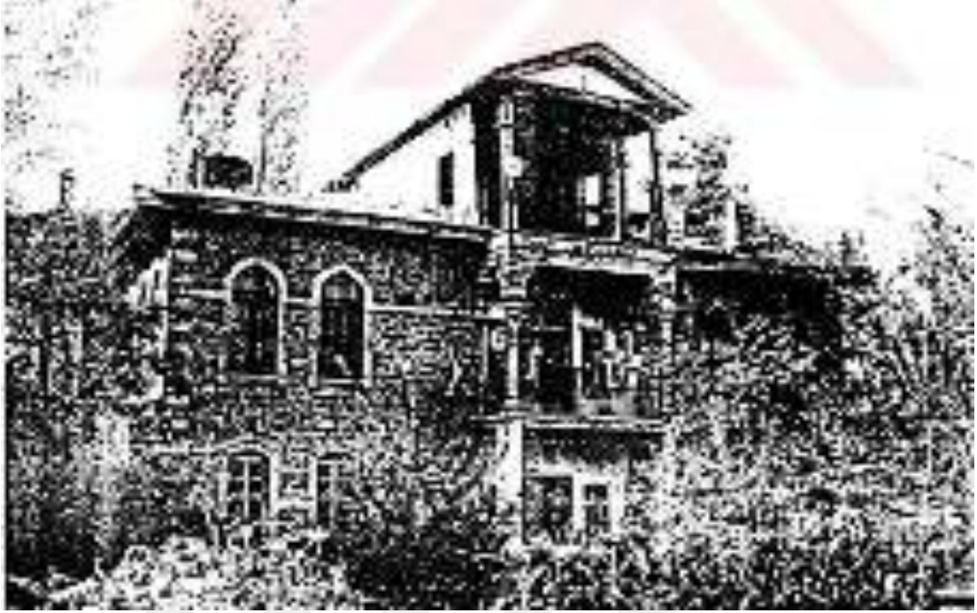
Resim 369. Aksaray Ahmet İleri Evi Doğu Cephesi (Zekai Erdal'dan)
