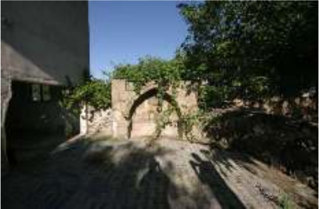
Resim 540. Aksaray Karataş Köyü Hacı Mehmed Çeşmesi (Zekai Erdal'dan)
