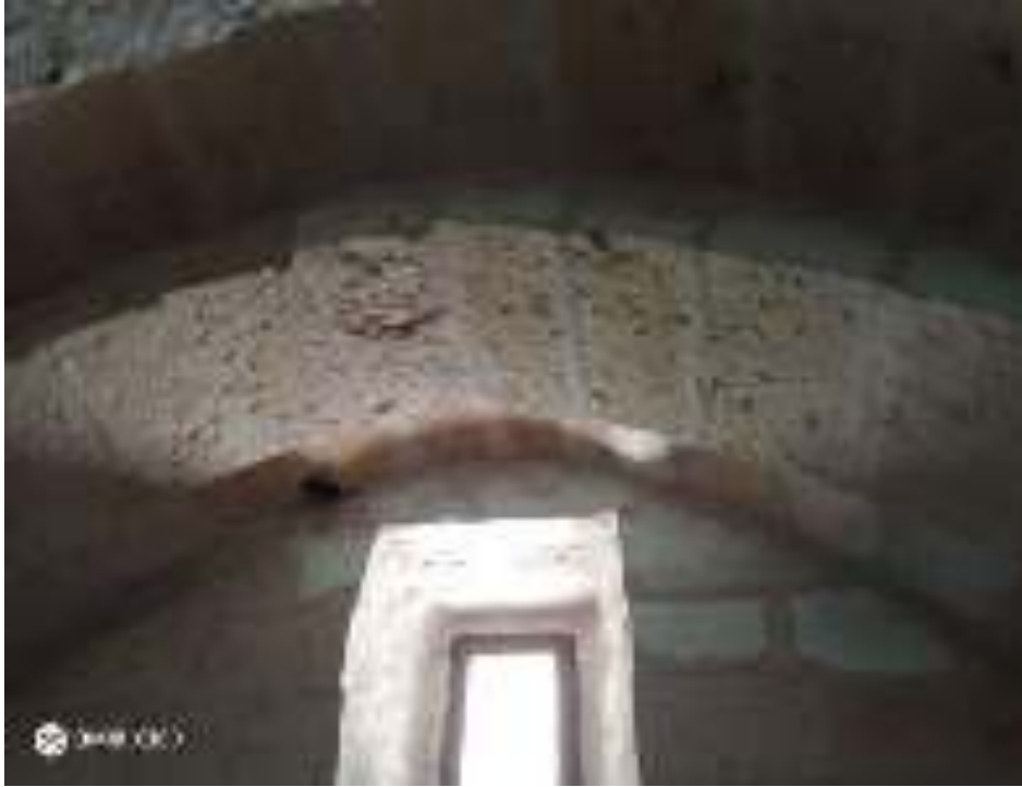
Resim 45.-46. 4 No.lu Ev İ Görünümden Pencereler (Ömer İirgin)
