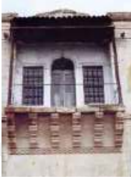
Resim 429. Avanos Alaaddin Mahallesi Harput Sokak 22 No.lu Evin (Mustafa Güven Evi) Balkonu (Mehmet Ali Esmer'den)
