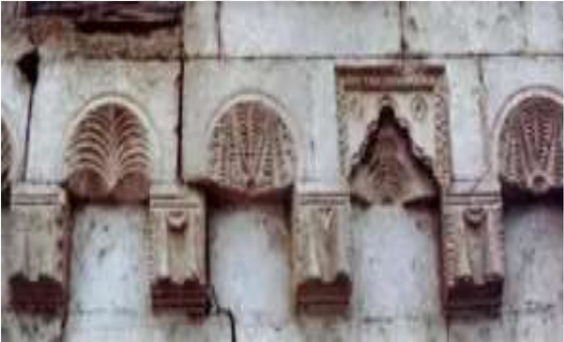
Resim 428. Avanos Alaaddin Mahallesi Sanayi Caddesi Üzerindeki 18 No.lu Evin Cephesindeki Korniş Detayları (Mehmet Ali Esmer'den)
