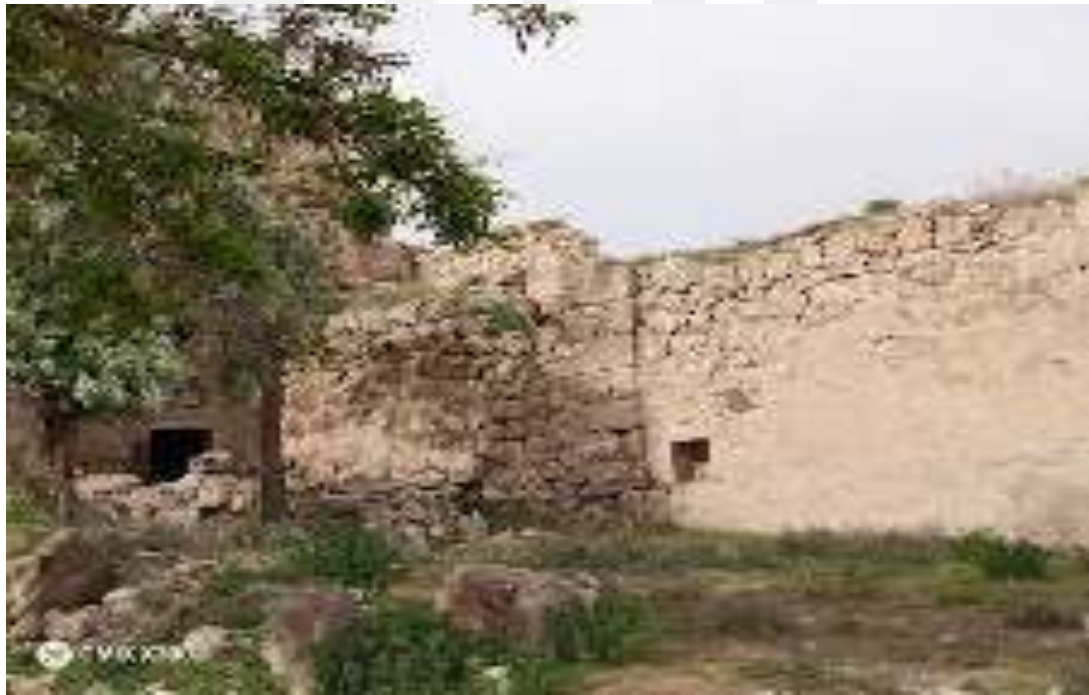
Resim 113.-114. Bahattin Altın Evi Avluya Çıkan Kuzey Cephesi (Ömer İçirgin)
