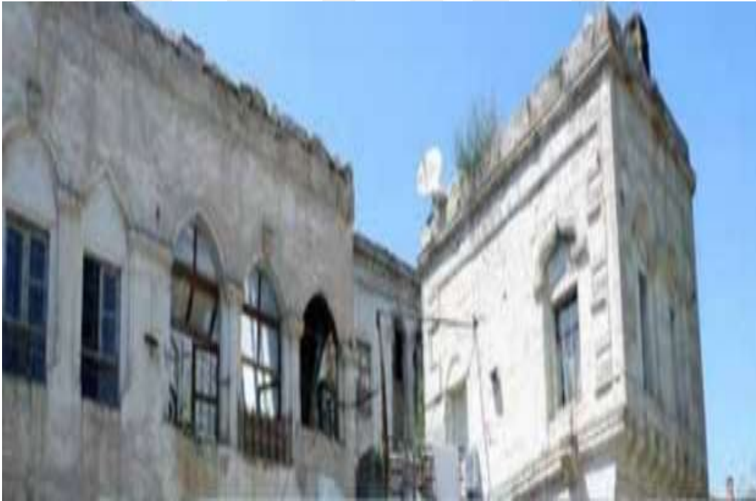
Resim 458.-459.-460.-461.-462.-463.-464. Demirci Evlerinden Saçak ve Çıkma Görünümleri (Erkan Aygör'den)
