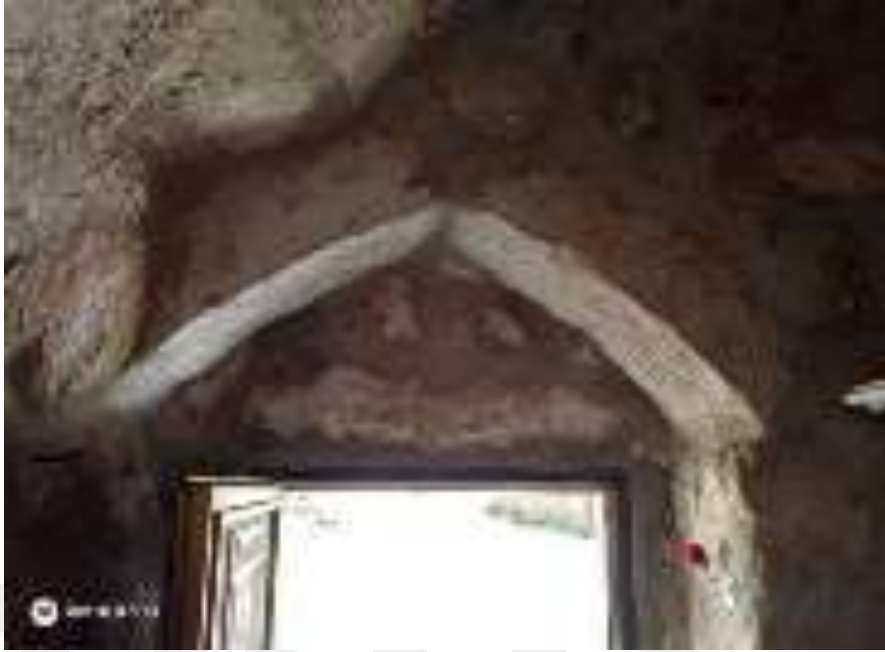
Resim 41. 4 No.lu Ev Giriş Bölümündeki Kemer Detayı (Ömer İçirgin)
