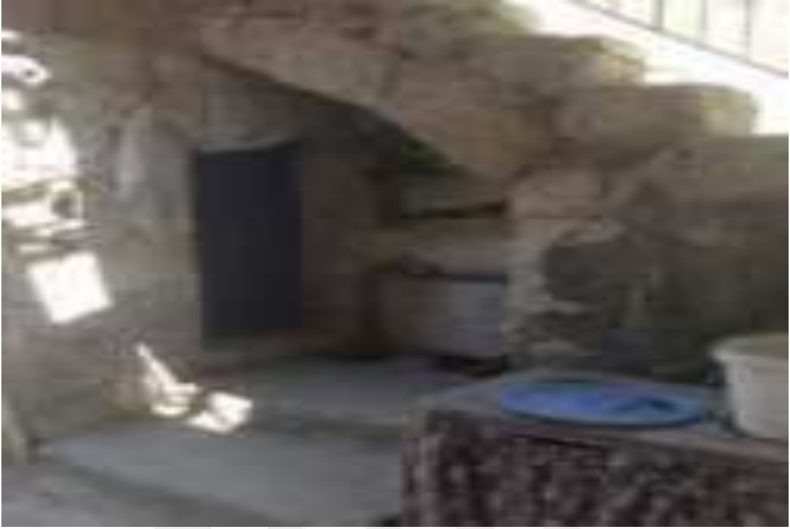
Resim 359. Derviş Koç Evi Alt Kat Mutfak Girişi (Erkan Aygör'den)
