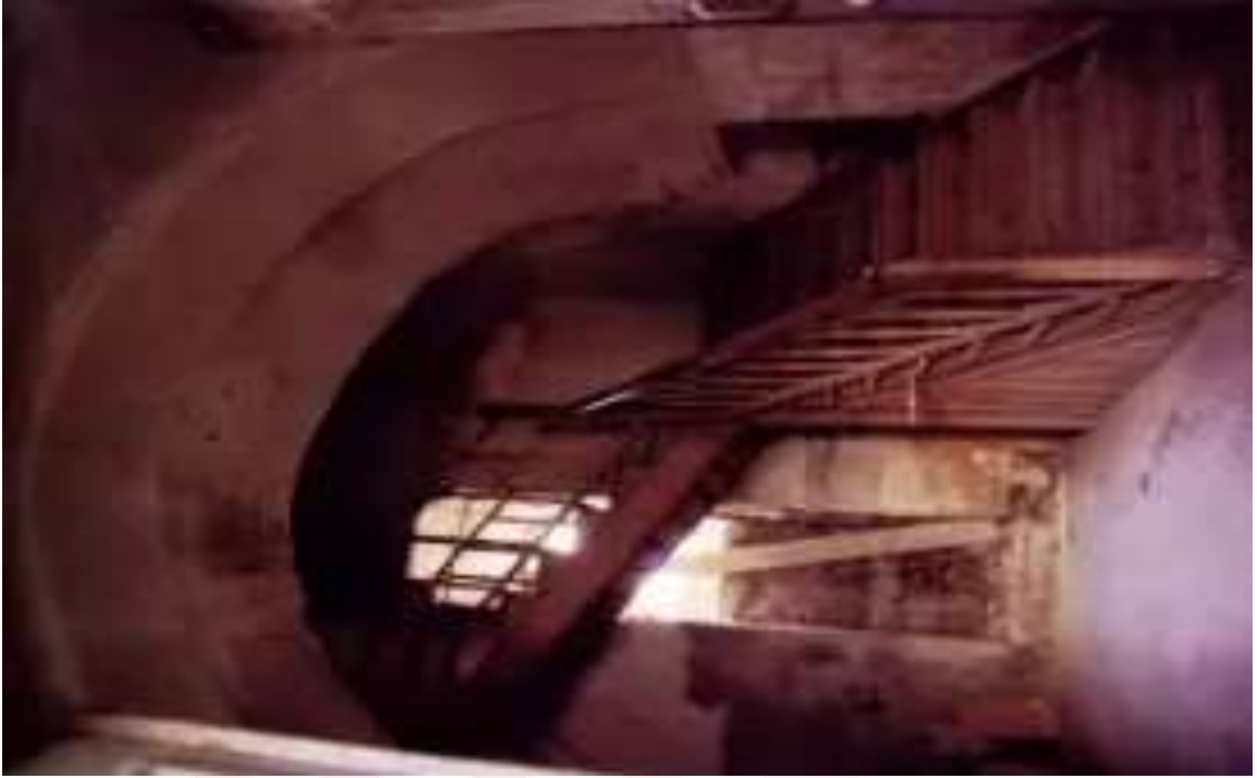
Resim 329. Avanos Doktor Konađı Ahşap Merdiven Aralıđındaki Tonoz (Mehmet Ali Esmer'den)
