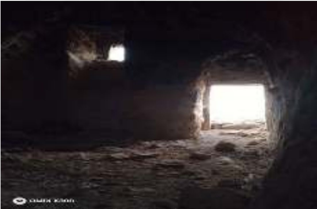
Resim 236. 4 No.lu Kaya Oyma Mekân Güneydoğu Mekânı Tonozu (Ömer İçirgin)
