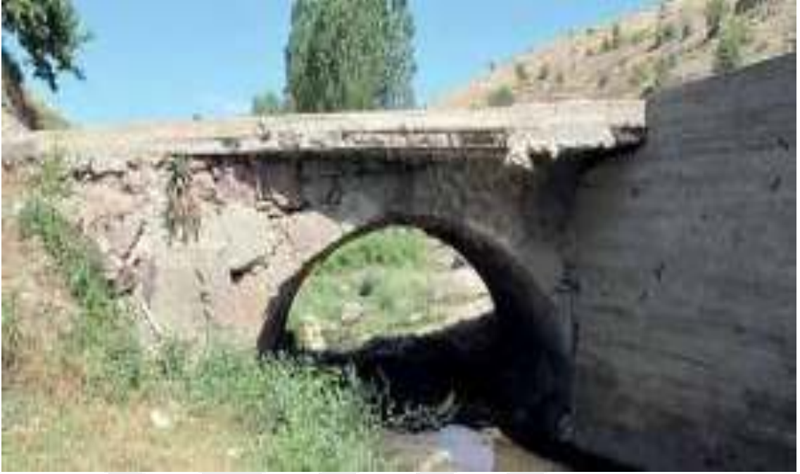
Resim 553. Konya Meram Çukurçimen Köyü Kel Değirmen Köprüsü (Remzi Duran, Ali Baş ve Ruhi Özcan'dan)
