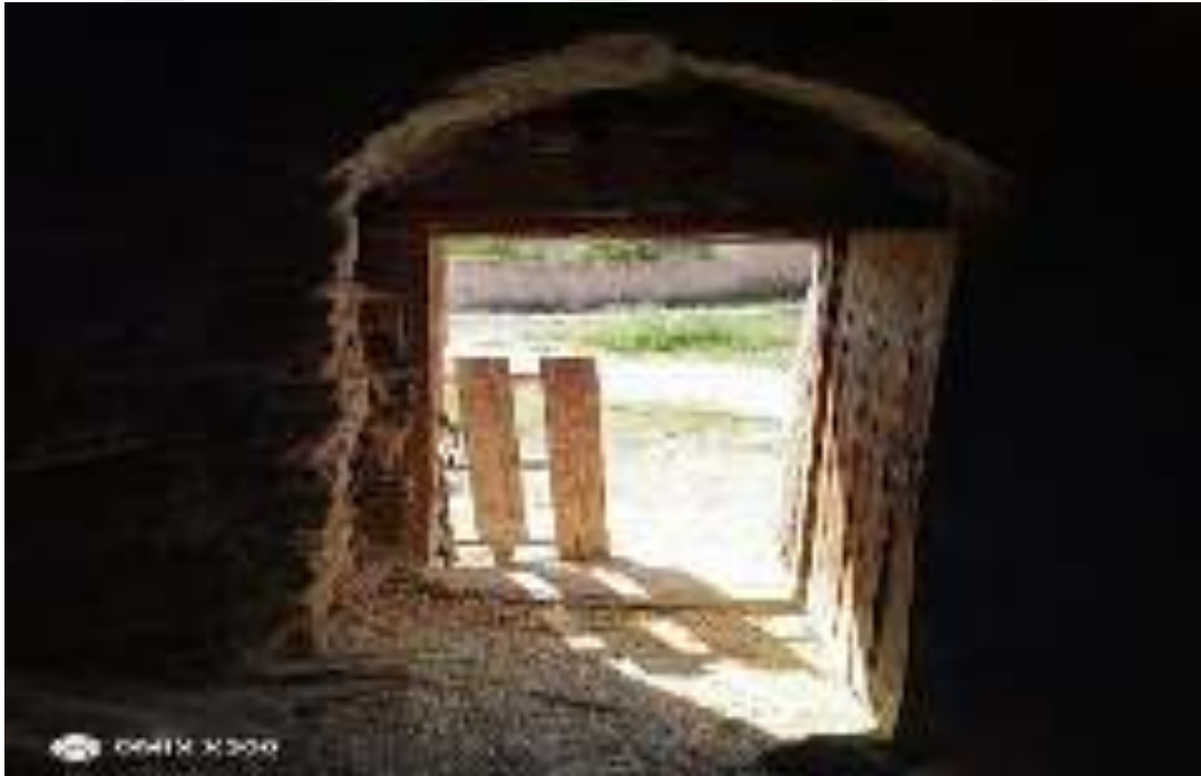
Resim 6. 1 No.lu Ev Alt Kat Samanlık ve Tandır Evi'nin Girişinde Bulunan Sivri Kemer (Ömer İçirgin)
