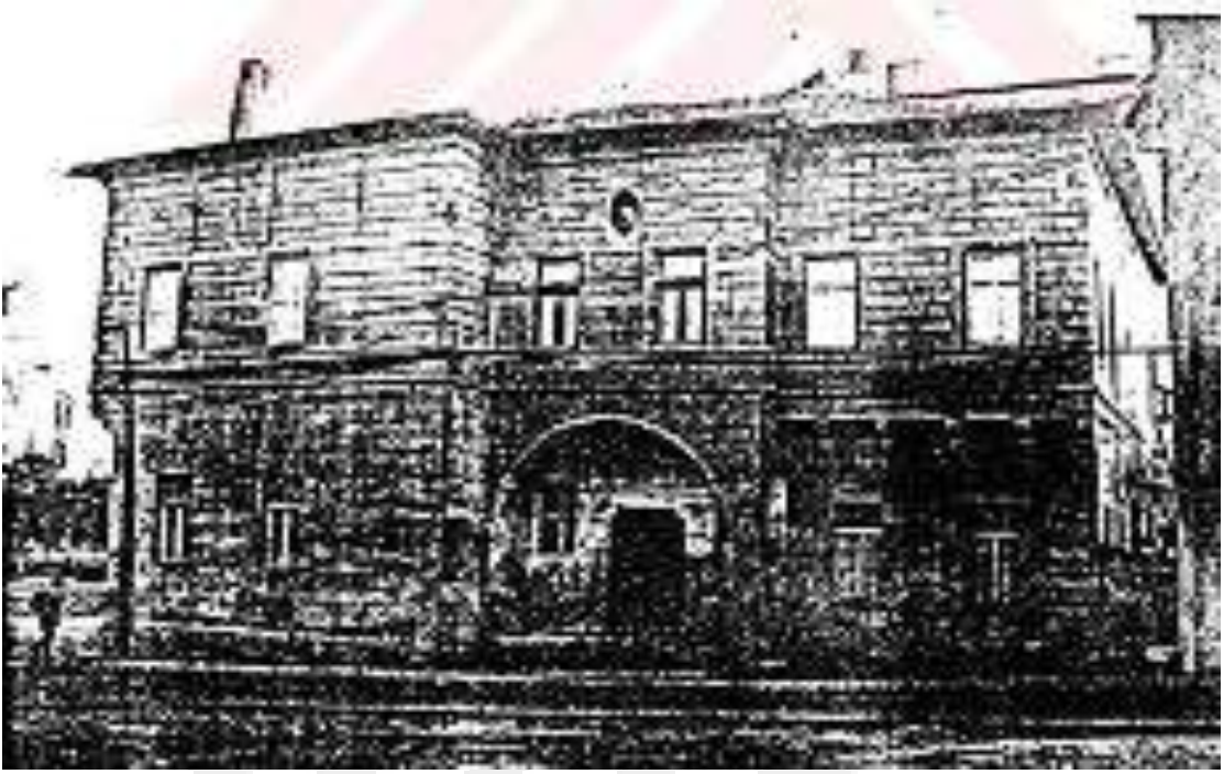
Resim 367. Aksaray Rıza Efendi Evi Kuzey Cephesi (Zekai Erdal'dan)
