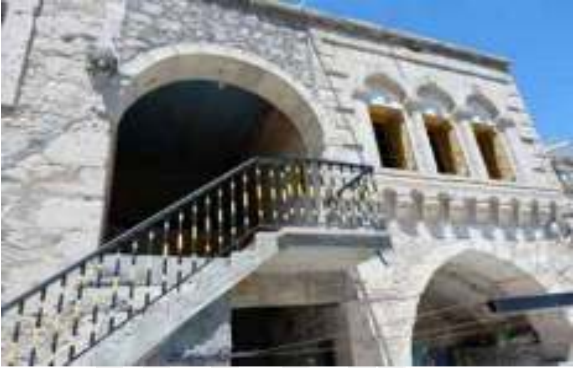
Resim 339. Demirci Abdullah Sapmaz Evi Eyvan ve Kuzey Oda Cephe Görünümü (Erkan Aygör'den)
