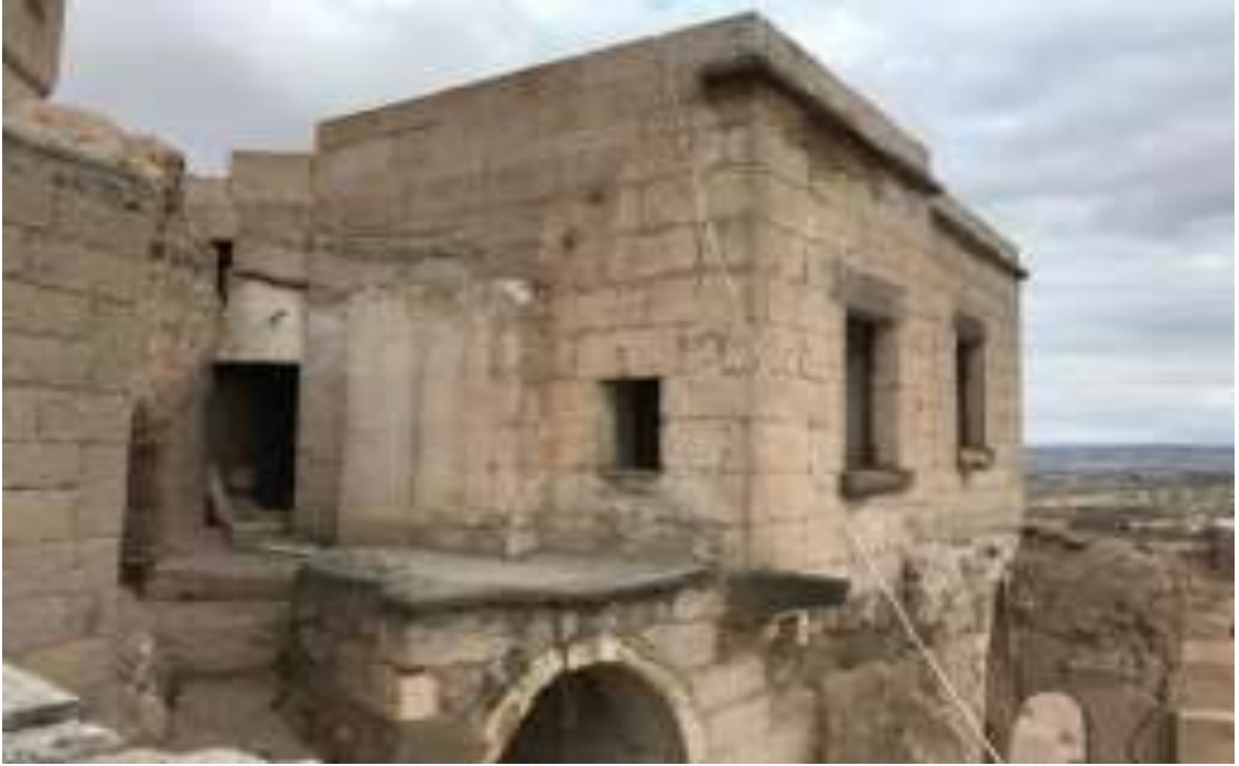
Resim 321.-322. Uçhisar'da Kaya Oyma ve Yığma Teknikleri İle Yapılmış Evler, Parsel:765-666 (Yusuf Budak'tan)
