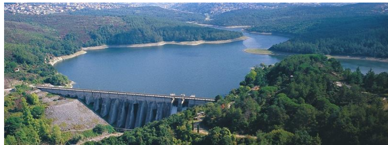
Şekil 3.11. Elmalı Barajı (URL-12)
