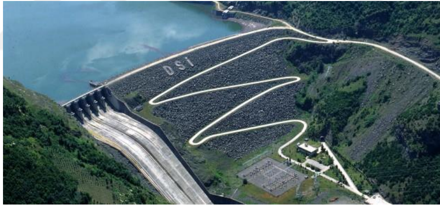
Şekil 3.2. Hasan Uğurlu Barajı (URL-4)
