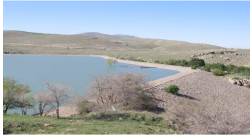
Şekil 3.1. Gebere Barajı (URL-3)
