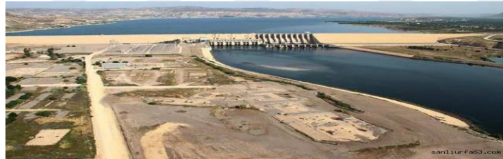
Şekil 3.23. Birecik-Nizip Barajı (URL-29)
