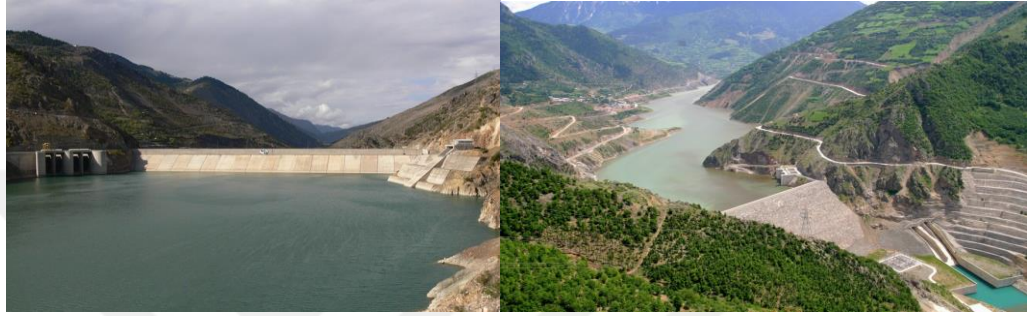
Şekil 3.8. Kürtün Barajı memba ve mansaptan görünümü (URL-10)
