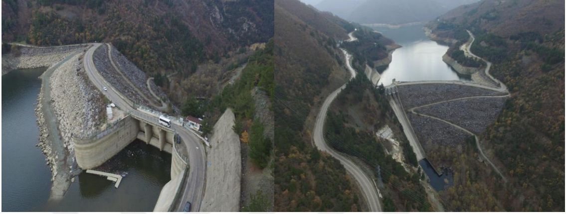
Şekil 3.6. Doğancı Barajı (URL-8)
