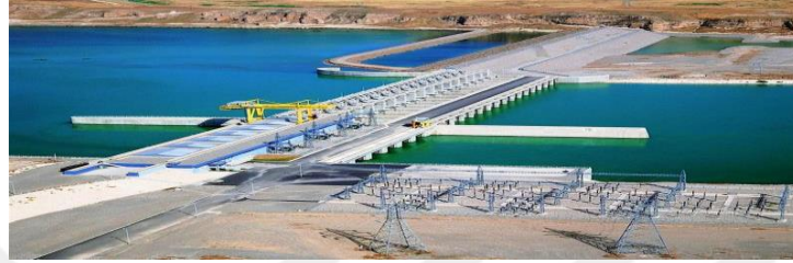
Şekil 3.14. Karkamış Barajı (URL-15)
