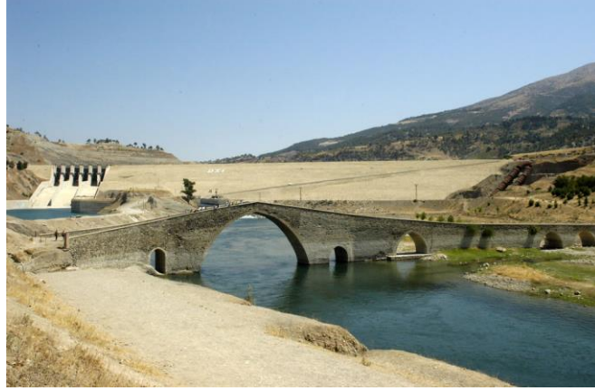
Şekil 3.3. Kılavuzlu Barajı (URL-5)
