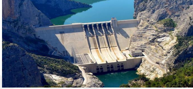
Şekil 3.10. Boyabat Barajı (URL-11)
