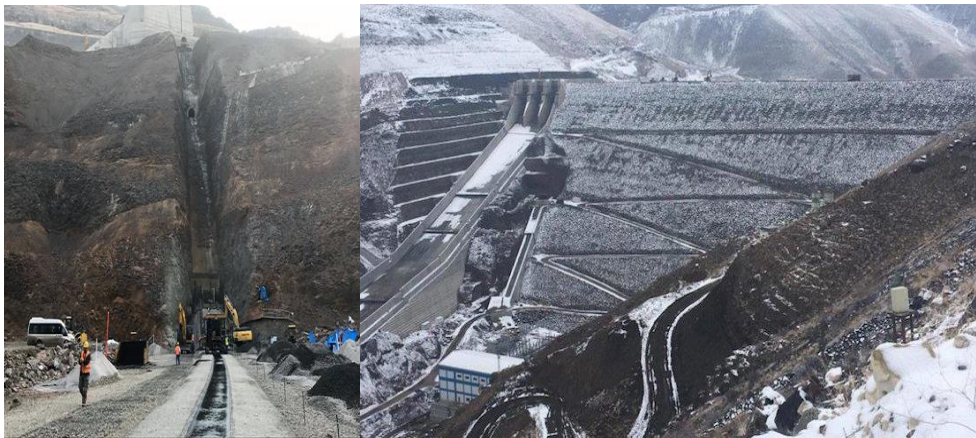
Şekil 3.7. Karakurt Barajı'nın inşa aşaması ve tamamlanmış hali (URL-9)
