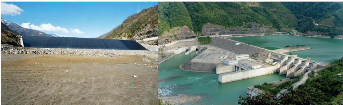
Şekil 3.9. Muratlı Barajı inşaa aşaması membadan ve inşaa sonrası mansaptan görünümü (URL-2)
