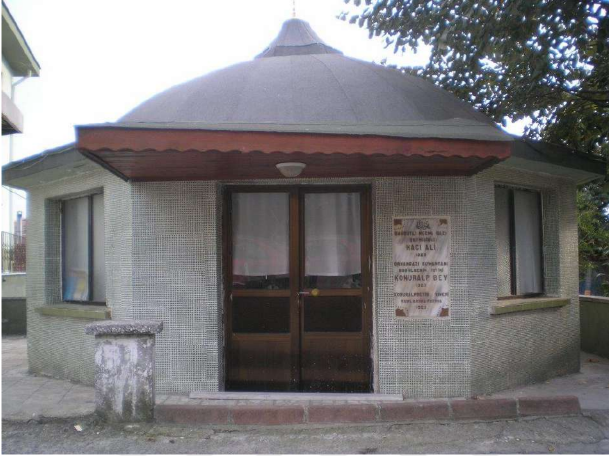
Fotoğraf 53: Türbenin Tadilat Görmeden Önceki Hâli (Düzce/Merkez)
