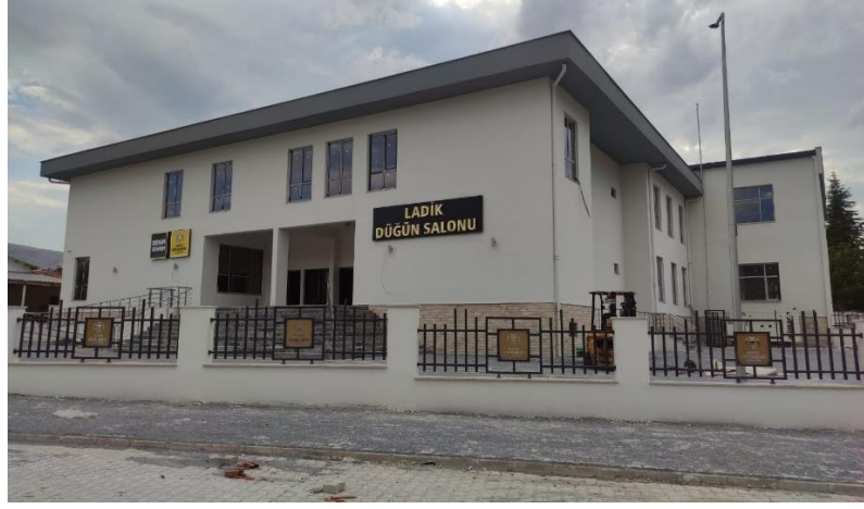
Şekil 4.8 Ladik Mahallesi'nde henüz inşaat halinde olan düğün salonu
